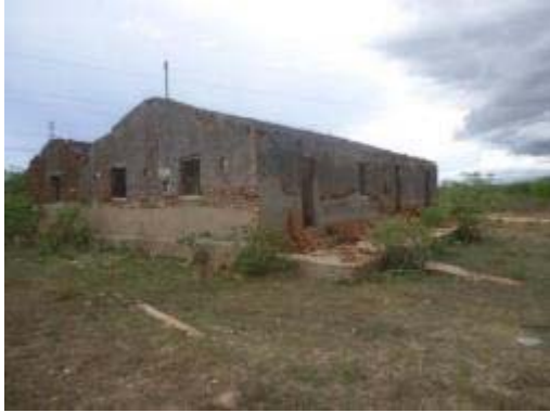
Figura 44. Estrutura da habitação. Foto: Jagô, 2019.
