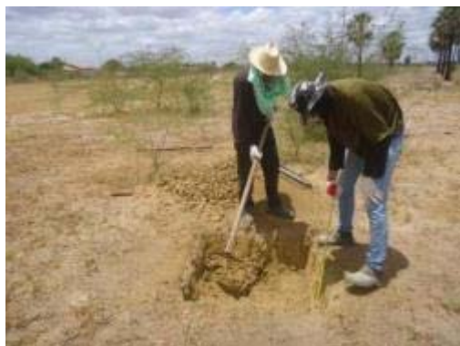
Figura 7. Procedimento: escavação com enxada. Foto: Jagô, 2018.
