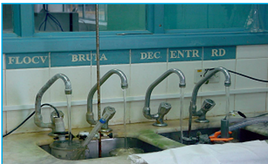
Figura 85. Torneiras localizadas no laboratório da ETA para controle das etapas do processo de tratamento (Foto: Carlos Jesus Brandão/CETESB).
