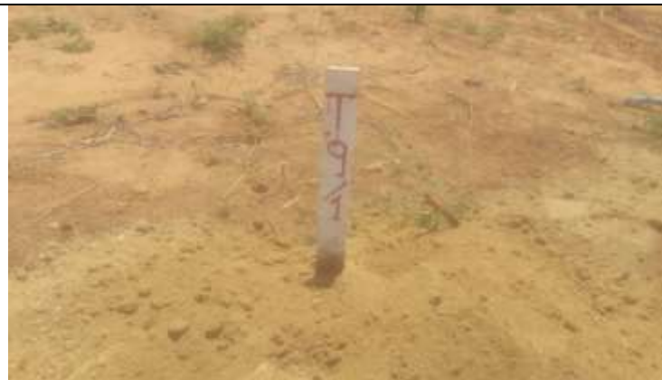
Figura 5. Vistoria de escavação por perfuratriz das cavas da praça da torre 9-1.
