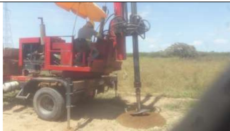
Figura 3. Caminhão-perfuratriz escavando cava na torre 24-1.
