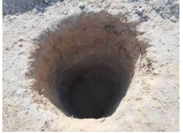
Figura 2. Escavação com rompedor finalizada. Torre 88/1, cava B
