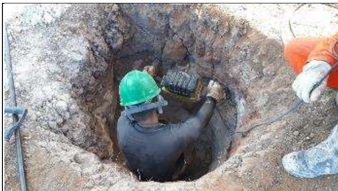
Figura 7. Reabertura da cava A torre 46/1
