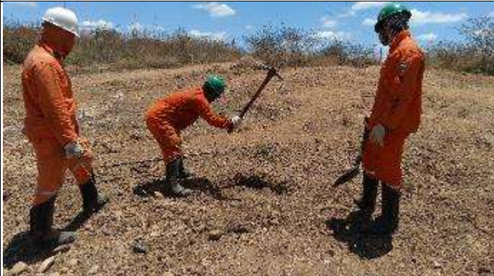
Figura 7. Escavação com picareta Cava D - T 76/1
