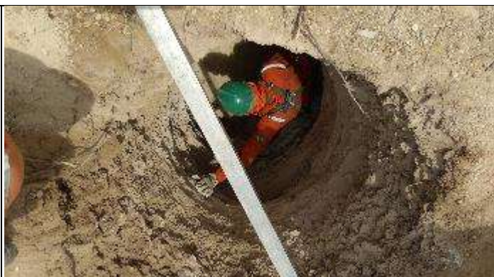
Figura 8. Finalizando cava D com martelete.
