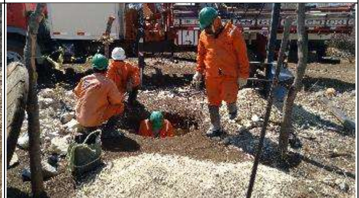
Figura 6. Reabertura cava C com martelete.
