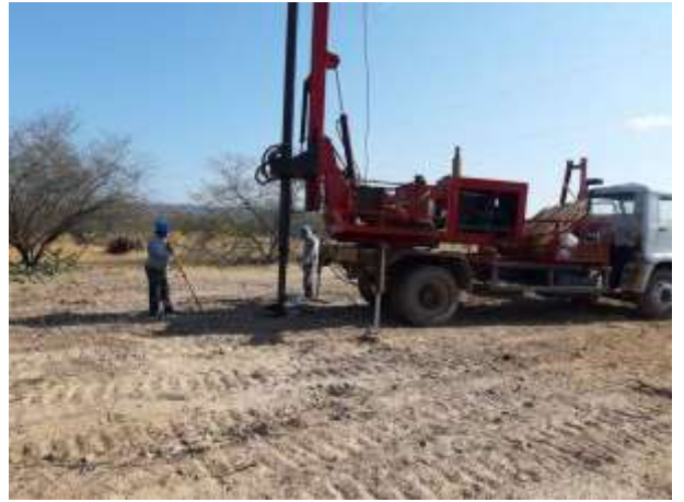
Figura 4. Torre 76/1 - Posicionamento da perfuratriz durante escavação da cava A.
