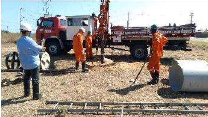
Figura 1. Abertura Cava D com perfuratriz T 76/1 A
