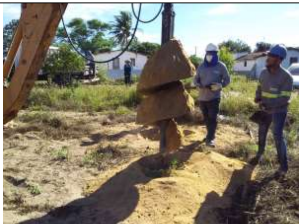
Figura 1. Escavação da torre 61/2, cava A.
