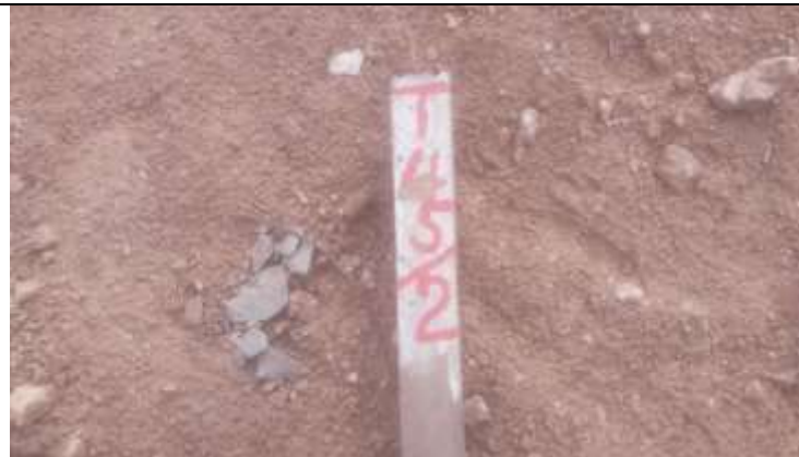
Figura 1. Marco central da torre 45-2.
