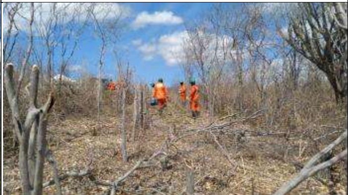
Figura 4. Supressão acesso torre 73/1
