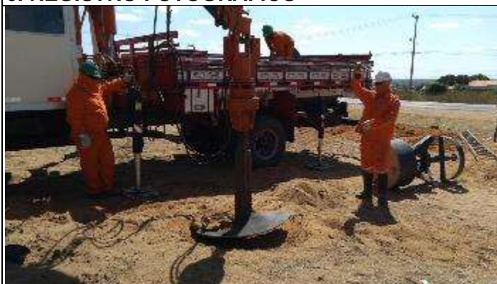
Figura 1. Início de reabertura cava C com perfuratriz
