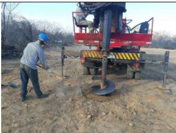
Figura 1. Torre 71/2- Escavação com perfuratriz da cava A.
