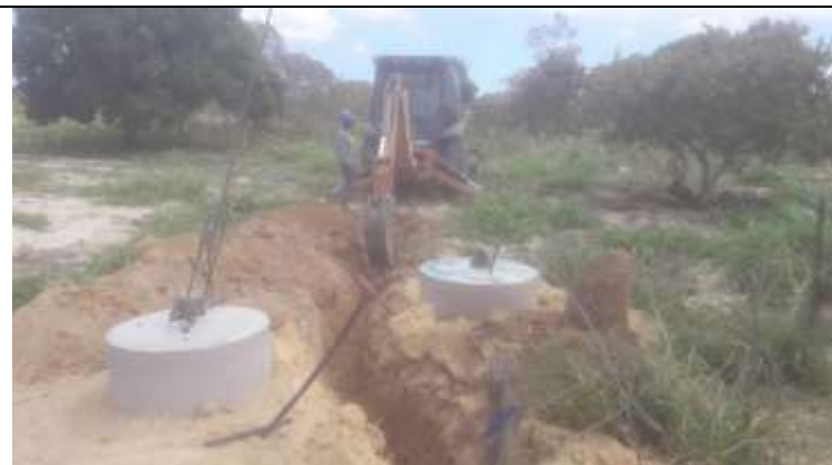
Figura 3. Atividade de escavação para contrapeso com retroescavadeira na torre 55-2.
