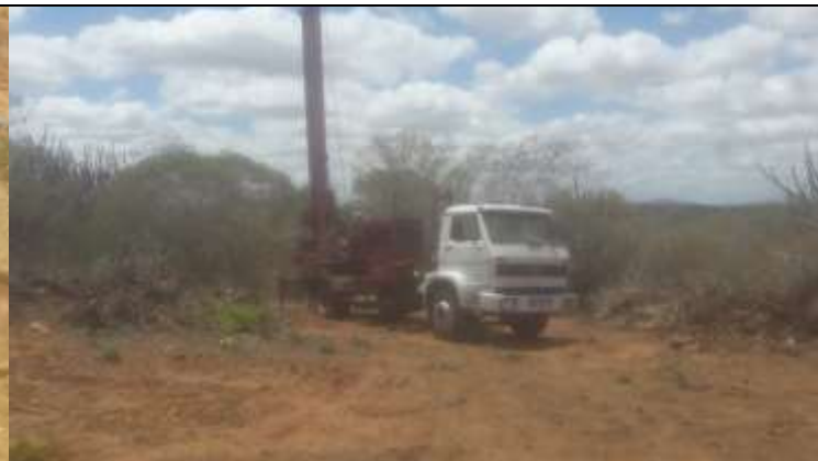
Figura 6. Vistoria de escavação por perfuratriz das cavas da praça da torre 9-1.
