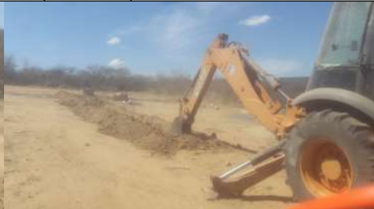
Figura 6. Retroexcavadora realizando a abertura de valas para o contrapeso na torre 46-1.
