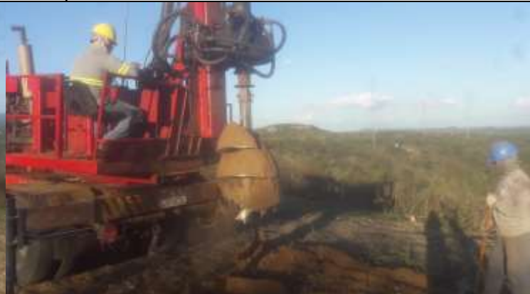
Figura 6. Atividade de escavações por perfuratriz para cavas na torre 29-1.
