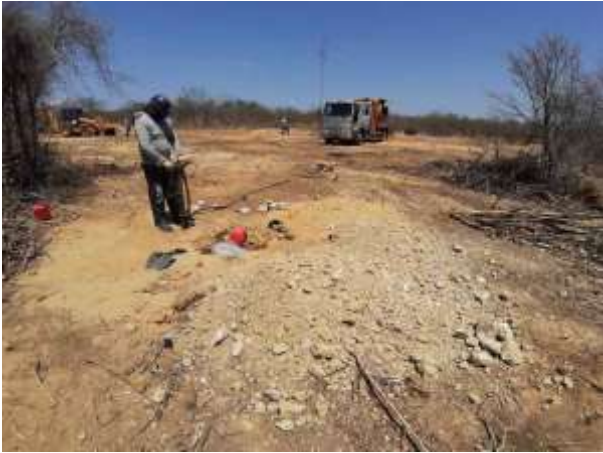
Figura 3. Escavação da torre 80/1, cava A.
