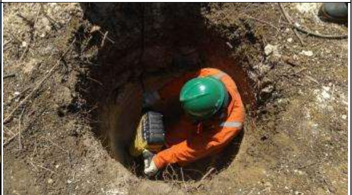
Figura 6. Reabertura cava B com martetele
