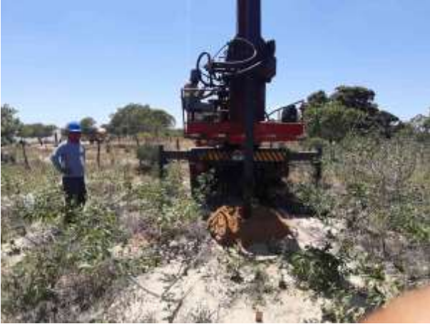
Figura 1. Torre 57/1, cava C.
