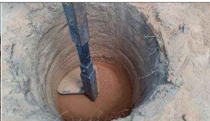
Figura 2. Reabertura Cava C nível 1,50m.
