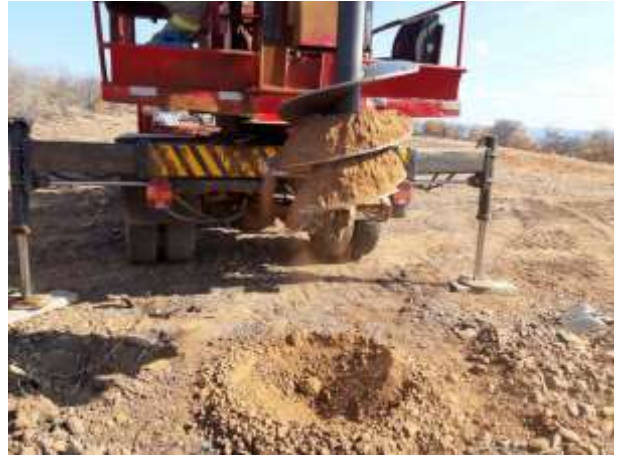
Figura 4. Torre 77/1 - Posicionamento da perfuratriz durante escavação da cava D.
