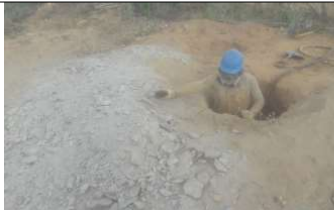
Figura 4. Atividade de escavação com martetele em cava da torre 38-1.
