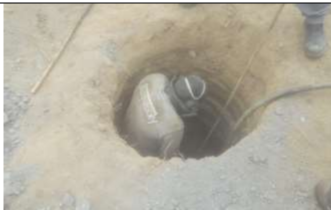
Figura 4. Atividade de escavação com martelete em cava da torre 36-2.
