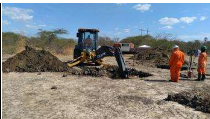
Figura 6. Abertura cava C torre 6/2
