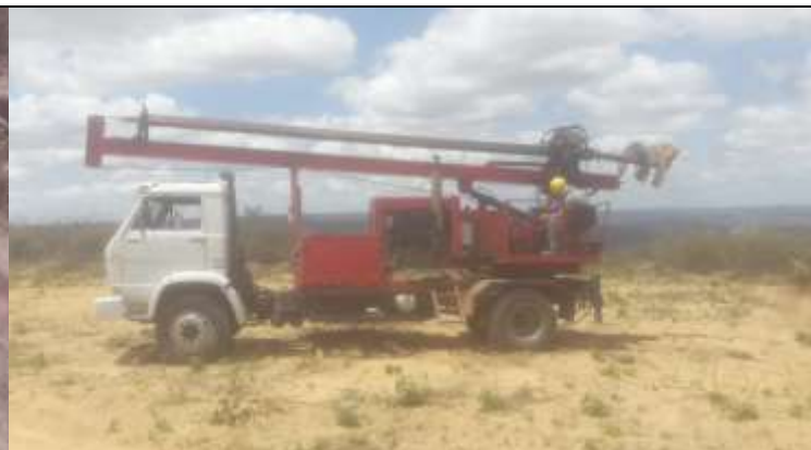
Figura 4. Perfuratriz parada na torre 54-1, onde teve problemas e voltou para o canteiro de obras.
