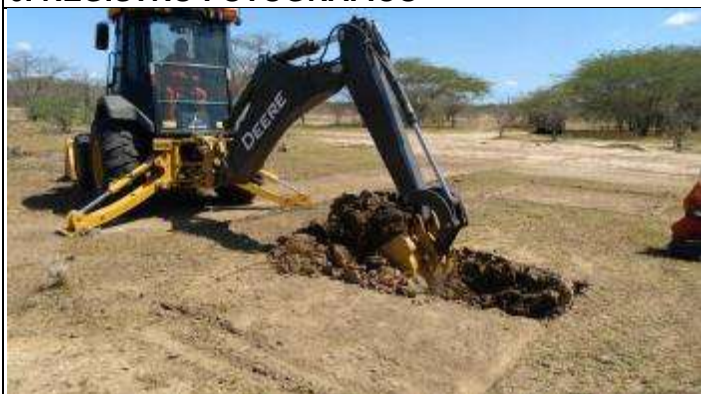
Figura 1. Abertura da cava A da Torre 7/1.
