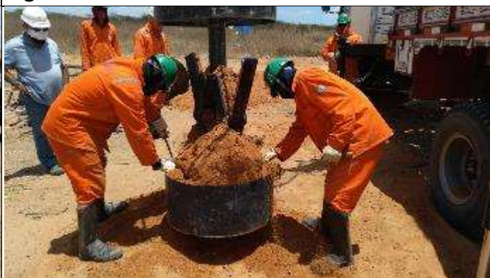
Figura 4. Escavação Cava C com broca especial
