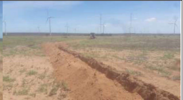
Figura 4. Atividade de escavação para contrapeso com retroescavadeira na torre 62-2.
