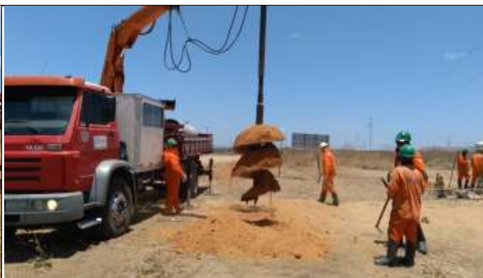
Figura 2. Reabertura Cava C
