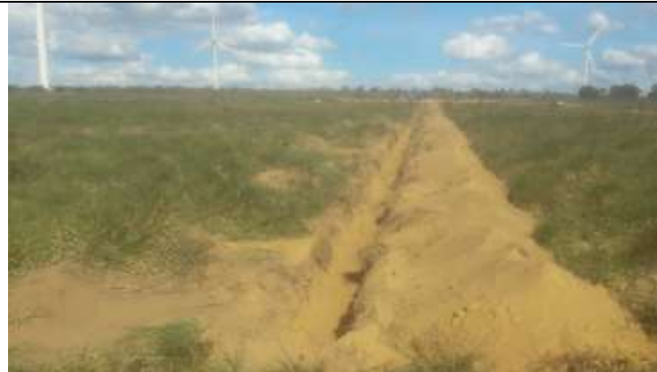
Figura 5. Atividade de escavação por retroescavadeira de vala para contrapeso com na torre 63-1.
