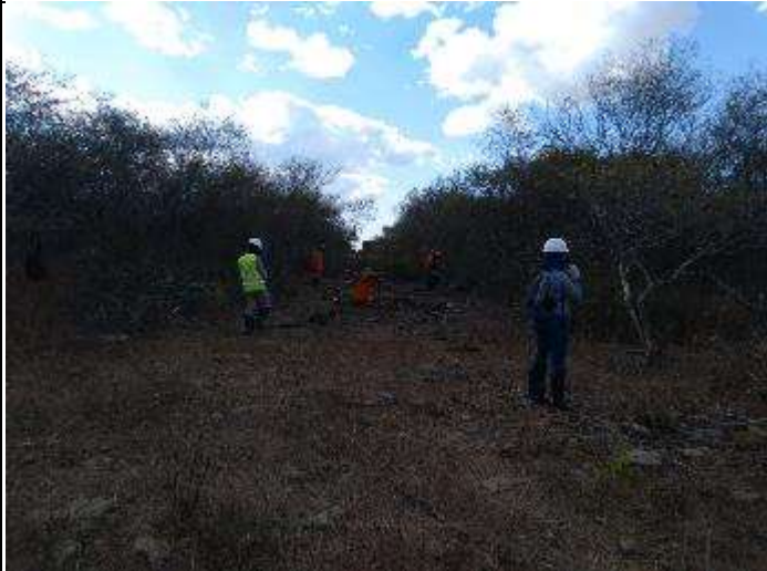
Figura 5. Supressão vegetal com moto serra no acesso da torre 38/2.
