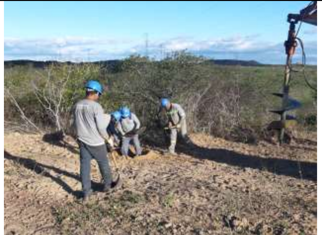
Figura 2. Escavação da Torre 46/1, cava central.
