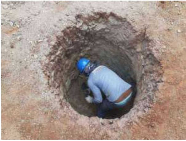
Figura 3. Escavação da torre 2/2, cava C.
