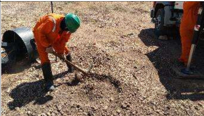
Figura 3. Escavação com picareta Cava A - T 76/1
