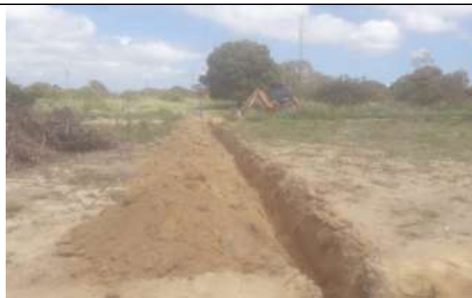
Figura 4. Atividade de escavação para contrapeso com retroescavadeira na torre 55-2.
