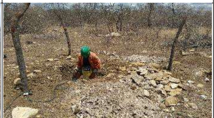
Figura 4. Abertura cava A com martetele T 38/2
