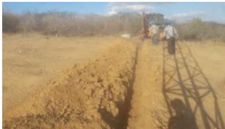
Figura 7. Abertura de vala por retroescavadeira para contrapeso na torre 43-2.
