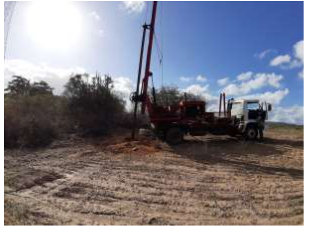
Figura 4. Supressão vegetal da Torre 44/3, cava C.
