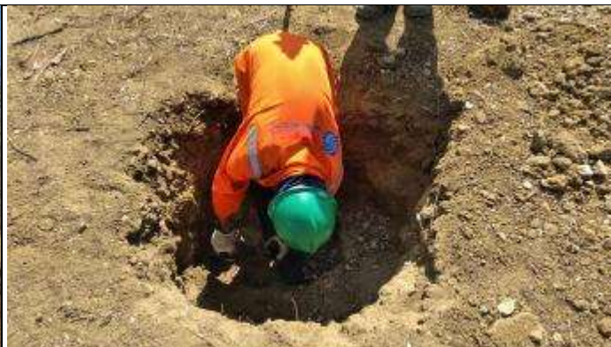
Figura 2. Finalizando na cava A com alavanca 90 cm
