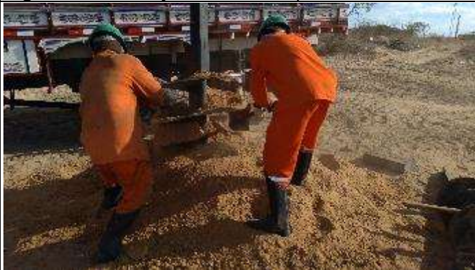
Figura 5. Troca de broca na cava D.
