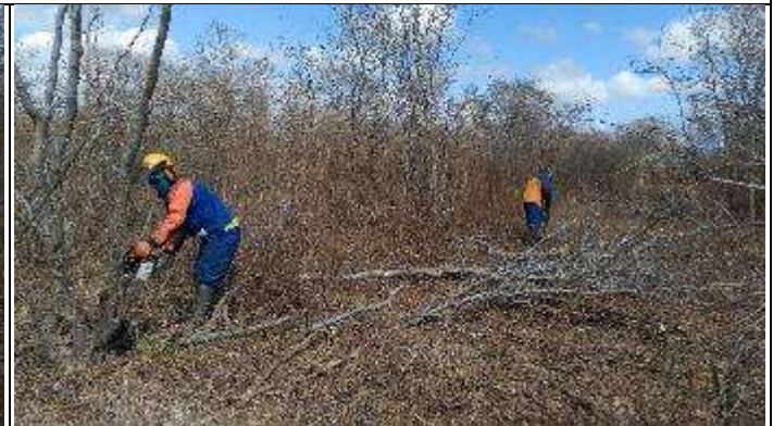
Figura 2. Supressão manual com motosserra.
