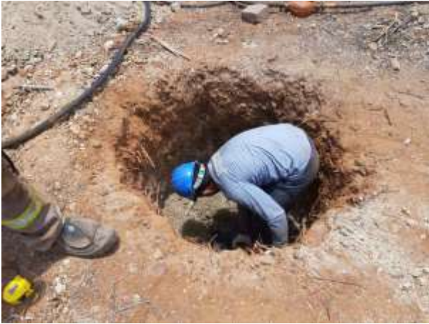
Figura 1. Escavação com rompedor da torre 88/1, cava Central
