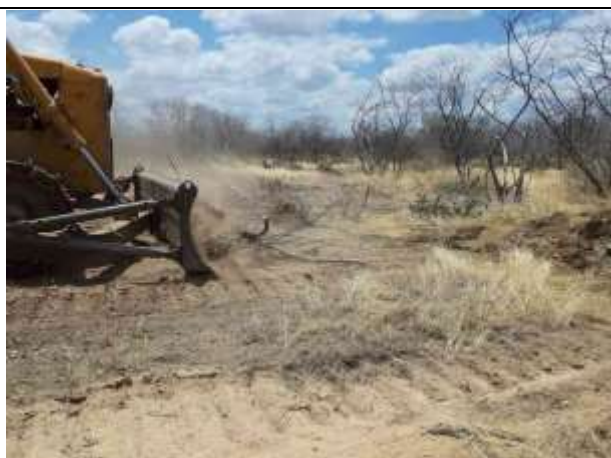
Figura 3. Torre 74/2-limpeza de praça
