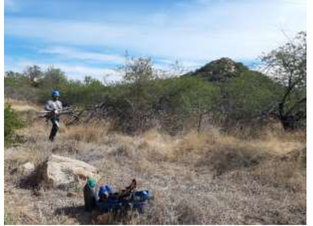
Figura 2. Supressão vegetal na Torre 72/3.
