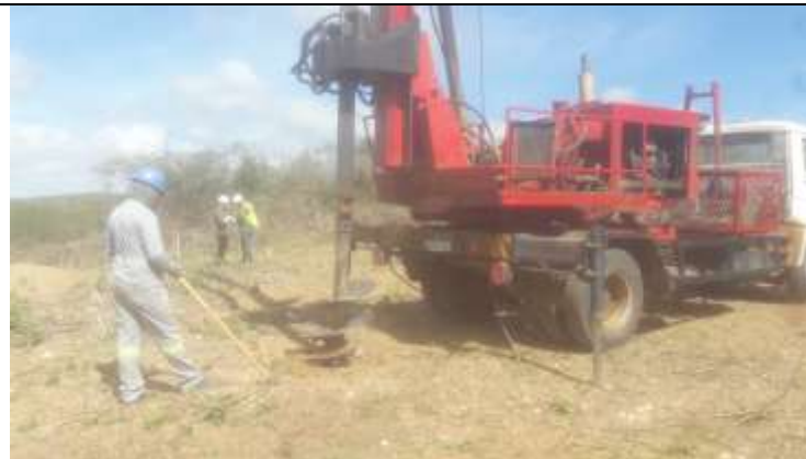
Figura 1. Atividade de escavação por caminhão-perfuratriz de cava na torre 29-1.
