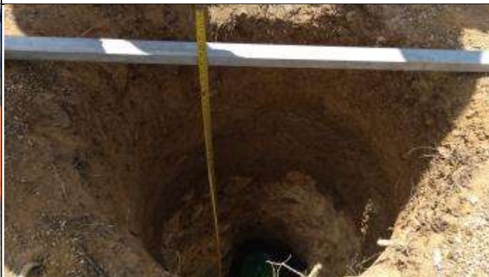
Figura 4. Finalização cava C com martelete.
