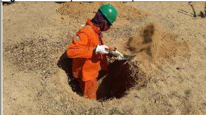
Figura 5. Escavação cava C manual
