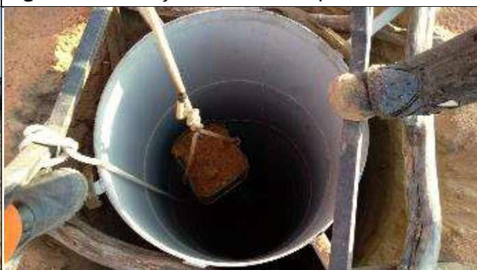
Figura 6. Escavação com auxílio de saia Cava C
