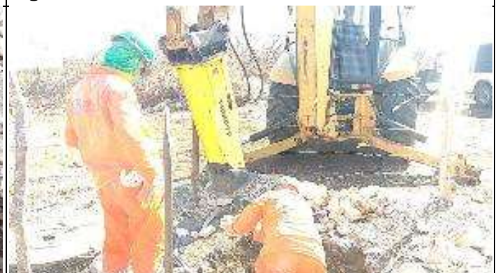
Figura 6. Reabertura cava C com picão rompedor.
