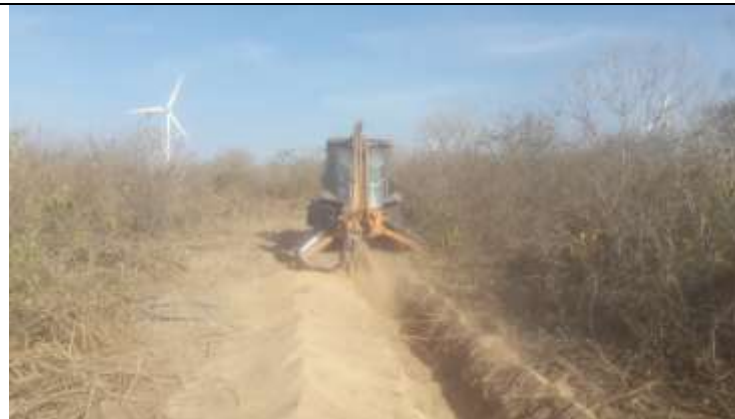
Figura 5. Atividade de escavação de vala por retroescavadeira para contrapeso na torre 64-1.
