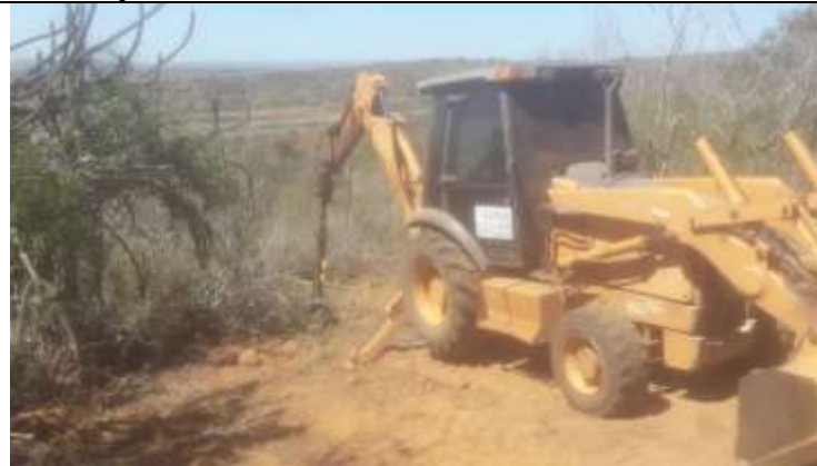
Figura 5. Retroescavadeira em atividade de escavação na torre 11-1.
