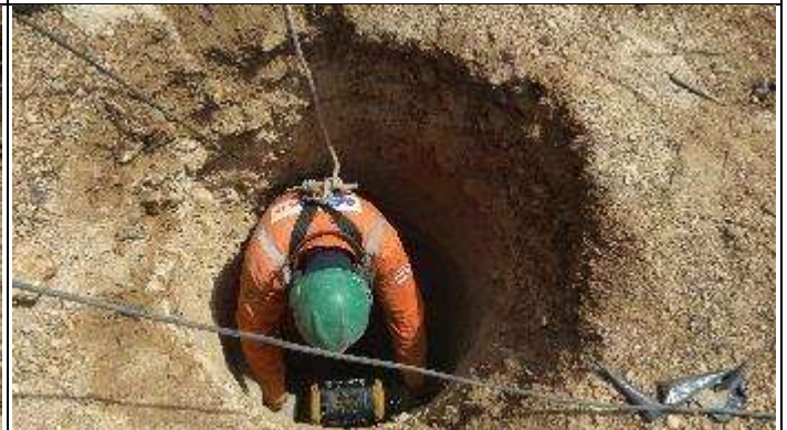
Figura 6. Reabertura Cava D com martetele T 56/1
