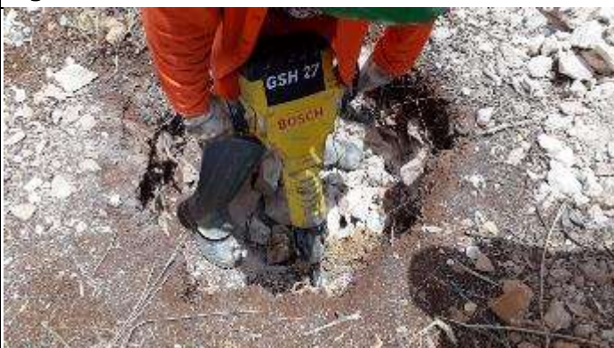
Figura 5. Reabertura Cava C com Martetele.
