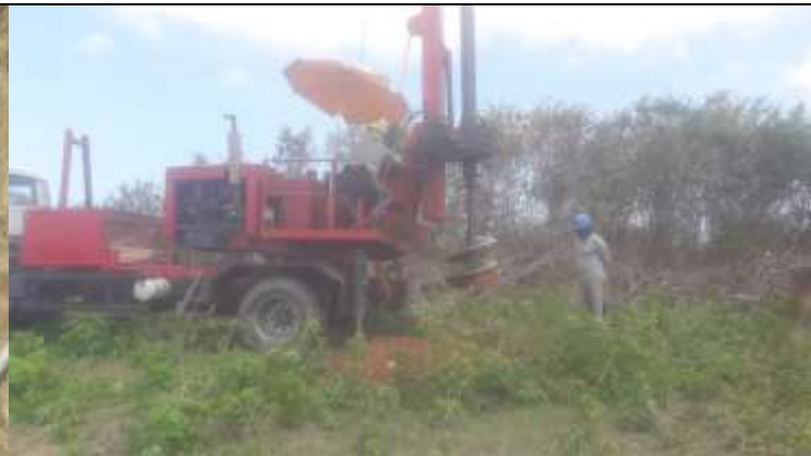
Figura 2. Caminhão-perfuratriz escavando cava na torre 24-1.
