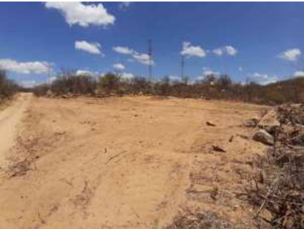
Figura 5. Torre 72/3 limpeza de praça da torre.
