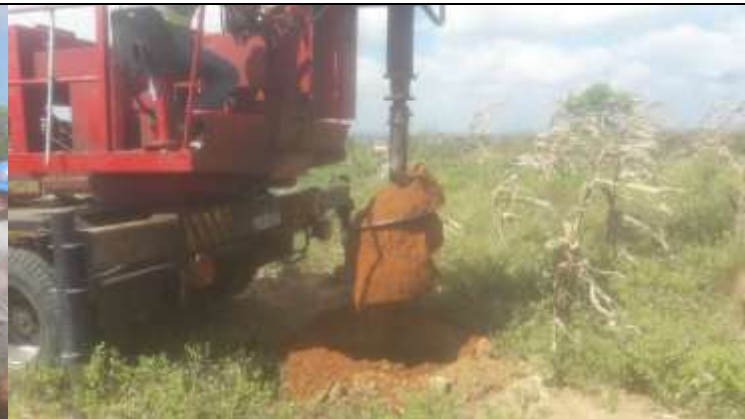
Figura 2. Caminhão-perfuratriz escavando cava na torre 25-2.
