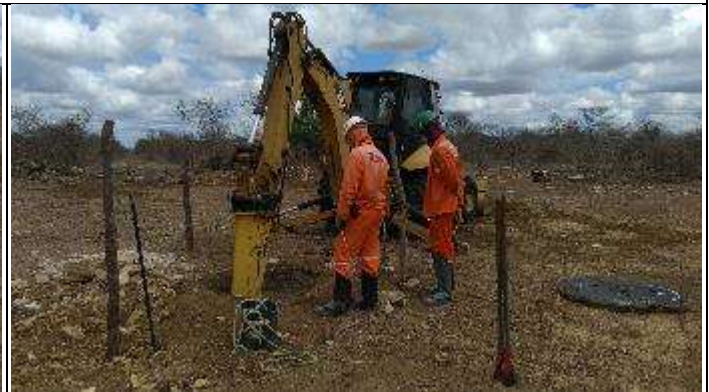
Figura 2. Abertura com picão cava central T 38/2
