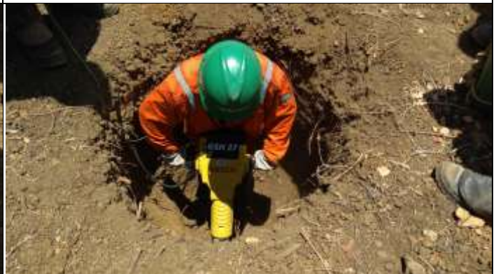
Figura 4. Finalização na cava C com Rompedor.
