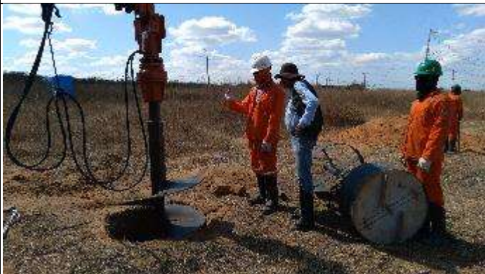
Figura 5. Escavação Cava B
