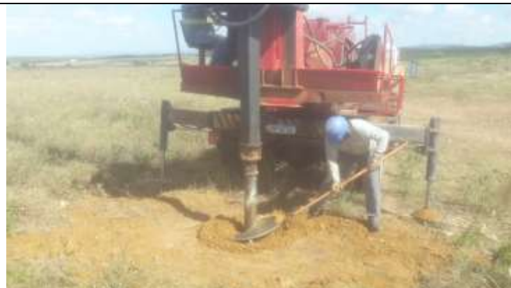
Figura 1. Atividade de escavações por caminhão-perfuratriz para cavas nas torres 30-2.
