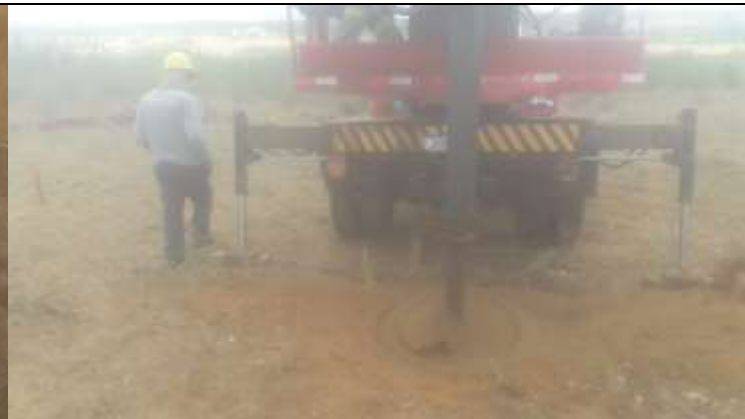
Figura 2. Escavação com perfuratriz de cava na torre 3-1.
