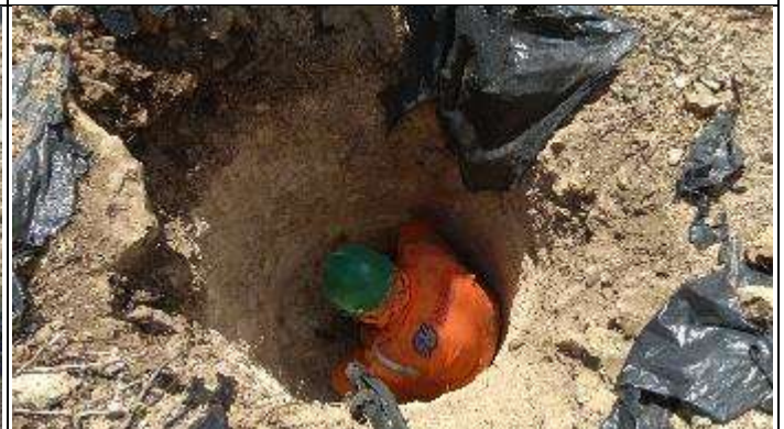
Figura 4. Reabertura Cava A com marreta T 56/1
