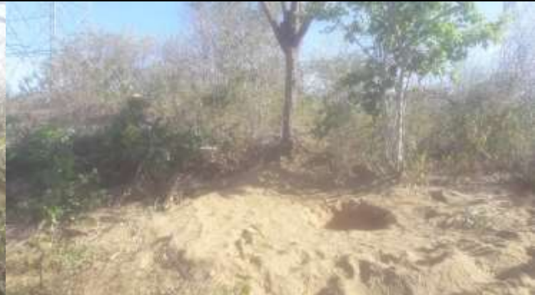
Figura 8. Cava C escavada com perfuratriz da torre 52-1
