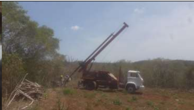
Figura 2. Caminhão-perfuratriz se posicionando para iniciar perfuração de cava na torre 13-2.
