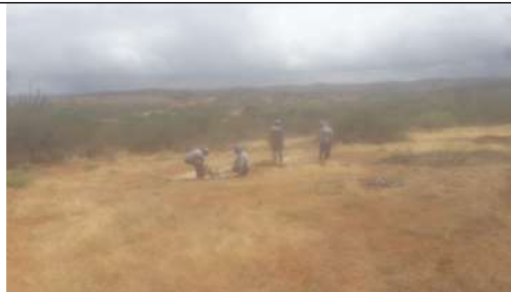
Figura 5. Escavação com rompedor de cavas na torre 4-1.
