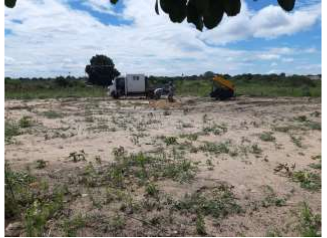
Figura 2. Escavação com rompedor Torre 60/1.
