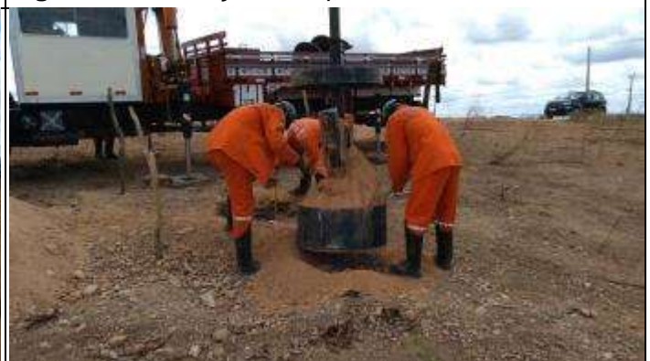
Figura 8. Escavação com broca especial
