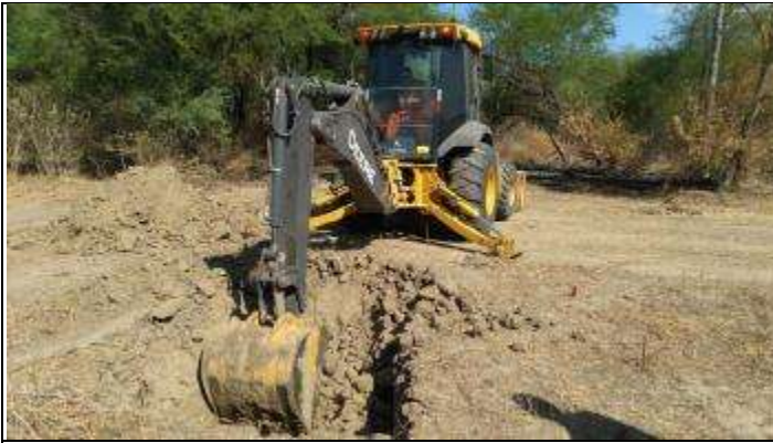
Figura 7. Abertura cava C torre 5/2
