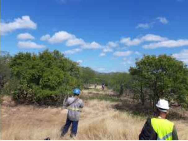
Figura 1. Supressão vegetal do acesso a torre 78/1
