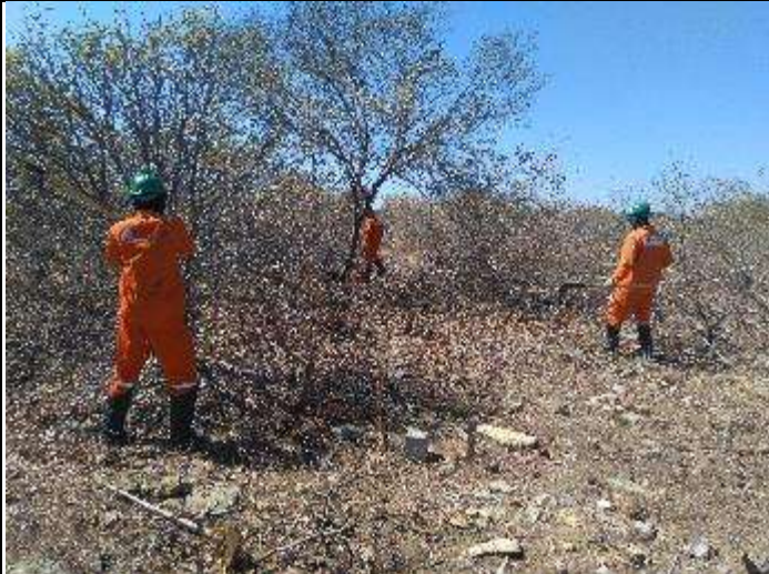
Figura 1. Supressão vegetal na base da torre 38/2.
