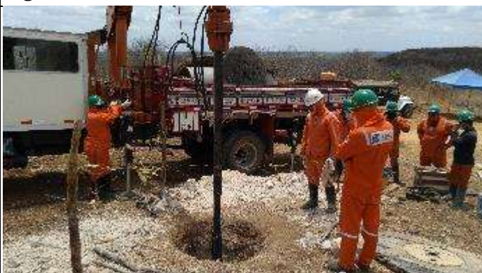
Figura 5. Reabertura Cava C com perfuratriz.
