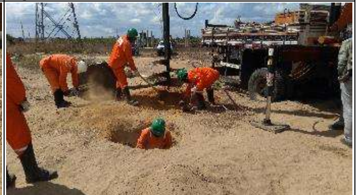
Figura 6. Escavação da cava C na Torre 76-2
