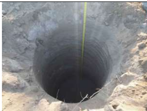
Figura 4. Torre 71/3 - escavação finalizada da cava C.
