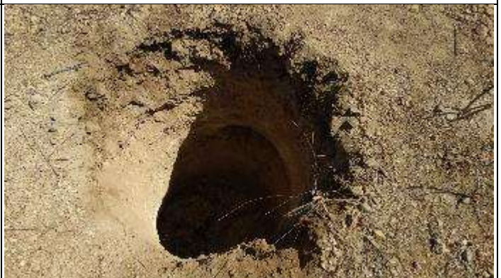
Figura 6. Finalização escavação Cava D T 56/1
