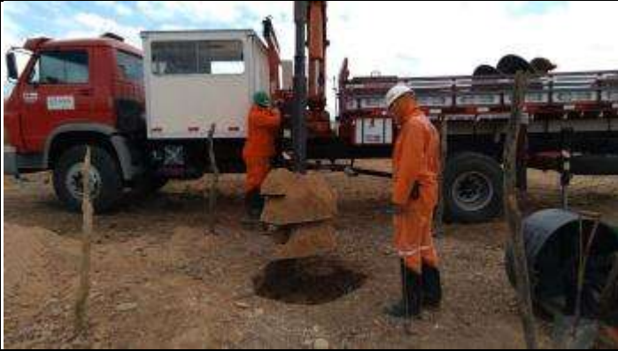
Figura 1. Abertura com perfuratriz cava C
