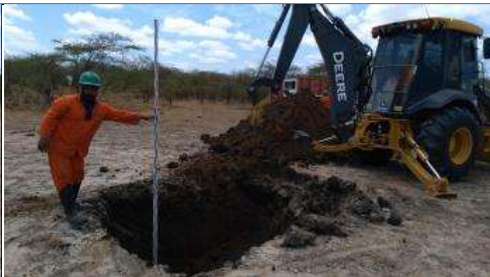
Figura 2. Continuação abertura da cava D T 6/2.
