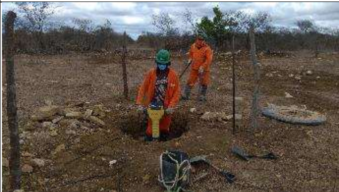
Figura 1. Abertura martetele cava central T 38/2
