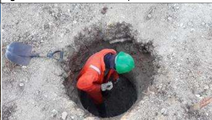
Figura 6. Finalizando cava D da Torre 45/1
