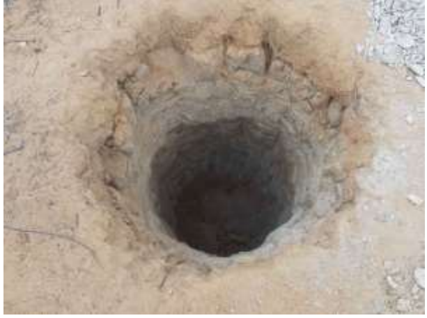
Figura 2. Escavação com rompedor finalizada. Torre 88/1, cava C
