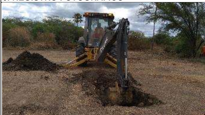
Figura 1. Início de abertura da cava C Torre 5/1.
