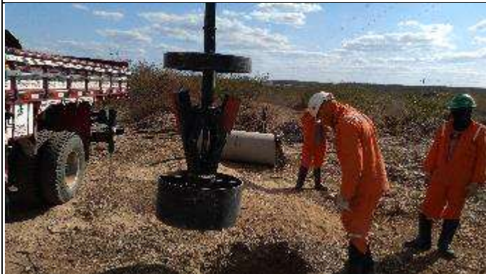
Figura 11. Escavação com broca especial Cava A
