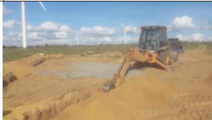
Figura 3. Atividade de escavação por retroescavadeira de vala para contrapeso com na torre 63-1.
