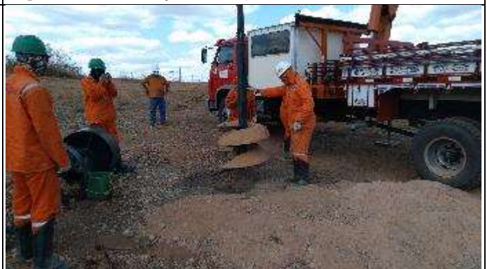
Figura 6. Escavação com perfuratriz Cava A-T 76/1
