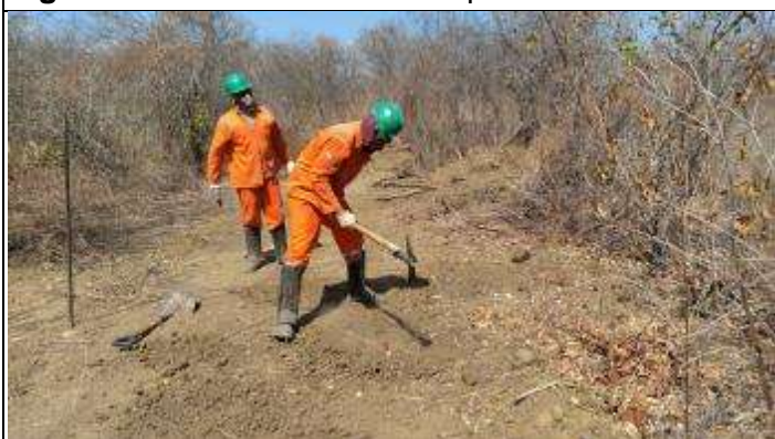
Figura 5. Limpeza na área da cava C com picareta.
