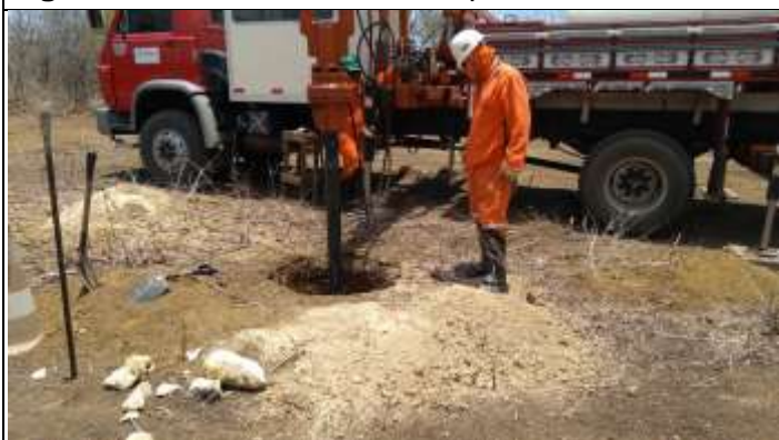
Figura 5. Escavação com perfuratriz até 1,45 m
