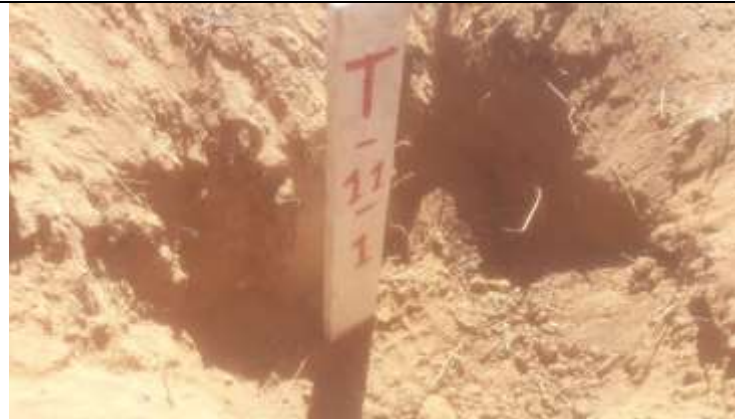
Figura 1. Marco central da torre 11-1.
