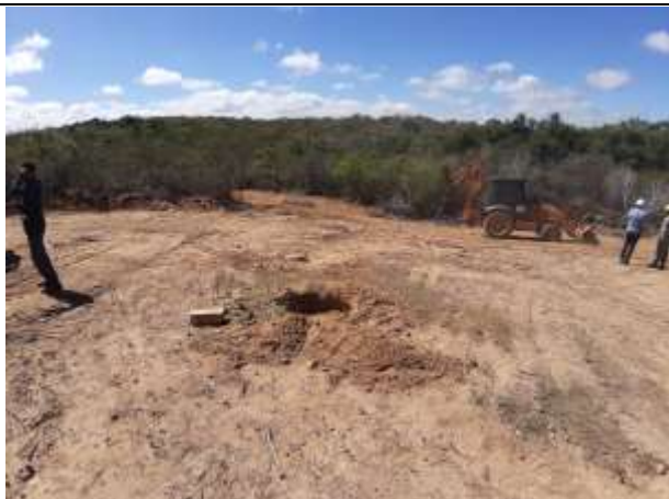
Figura 1. Escavação da torre 42/1, cava Central.
