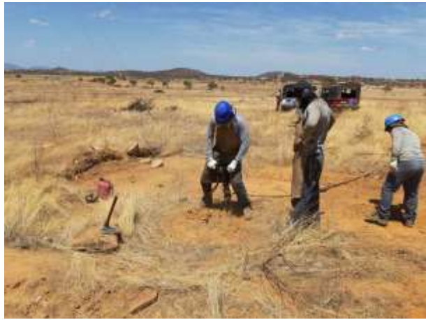
Figura 2. Escavação com rompedor. Torre 85/2, cava B
