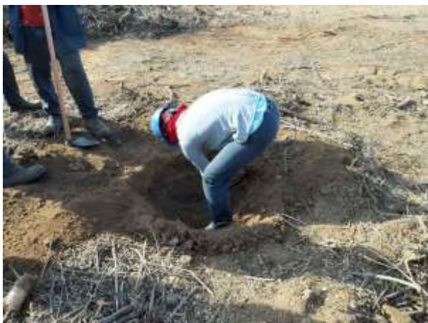
Figura 3. Escavação da torre 75/1, cava D.
