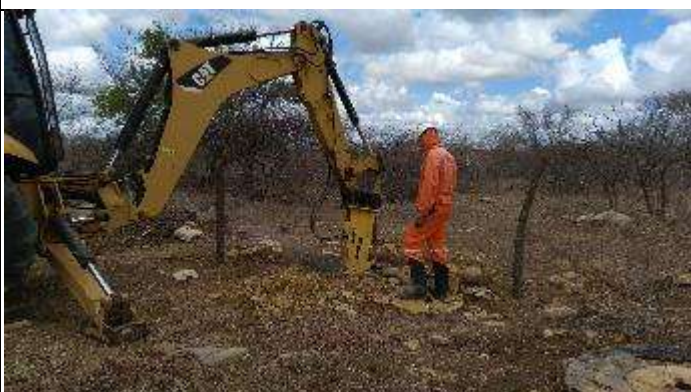
Figura 3. Abertura cava A com Picão T 38/2
