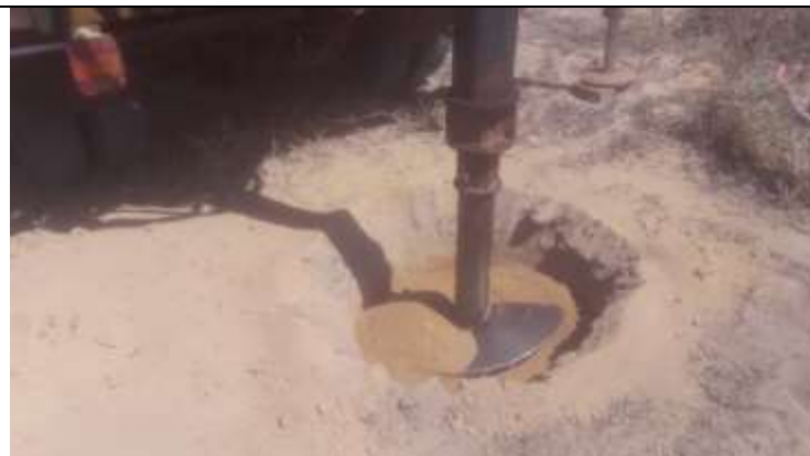
Figura 3. Acompanhamento da perfuratriz na abertura de cavas na torre 59-1.
