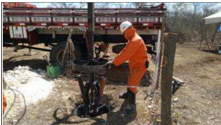
Figura 7. Escavação com broca especial cava A
