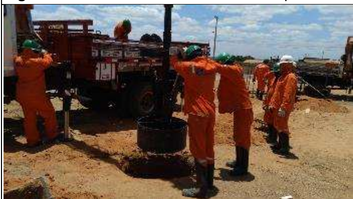
Figura 3. Escavação com broca especial Cava C
