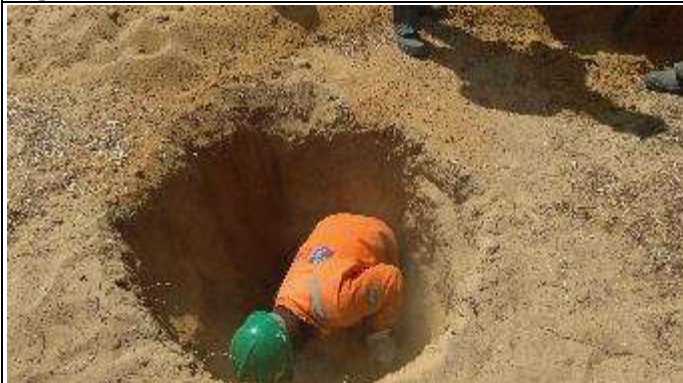
Figura 5. Aprofundamento da cava C na Torre 76-2
