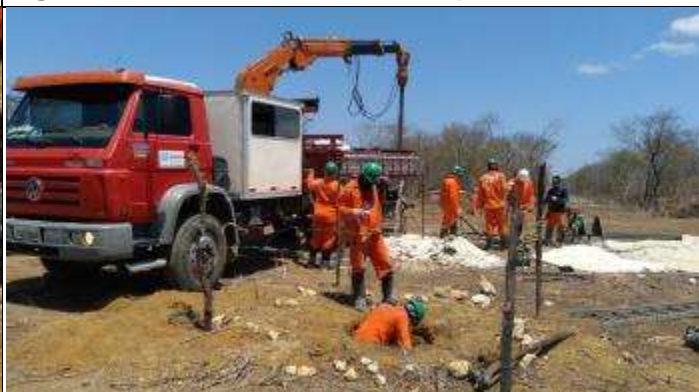
Figura 6. Reabertura cava D com martetele
