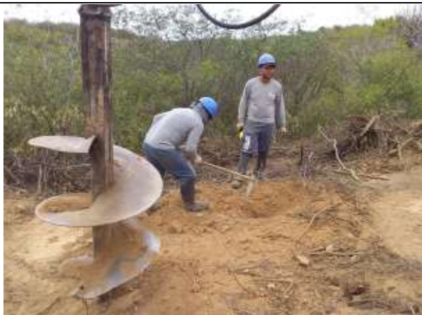
Figura 1. Escavação da torre 38/1, cava B.
