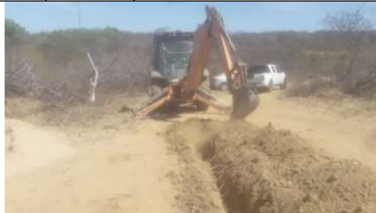
Figura 5. Retroexcavadora realizando a abertura de valas para o contrapeso na torre 46-1.
