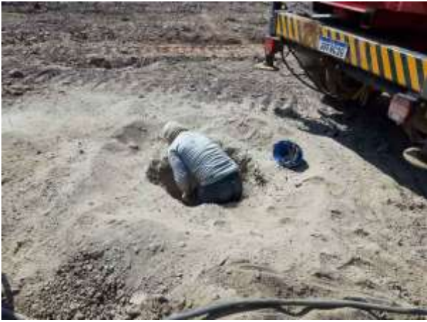
Figura 3. Escavação da torre 79/1, cava B.
