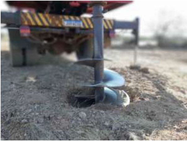
Figura 3. Escavação da torre 76/1, cava B.
