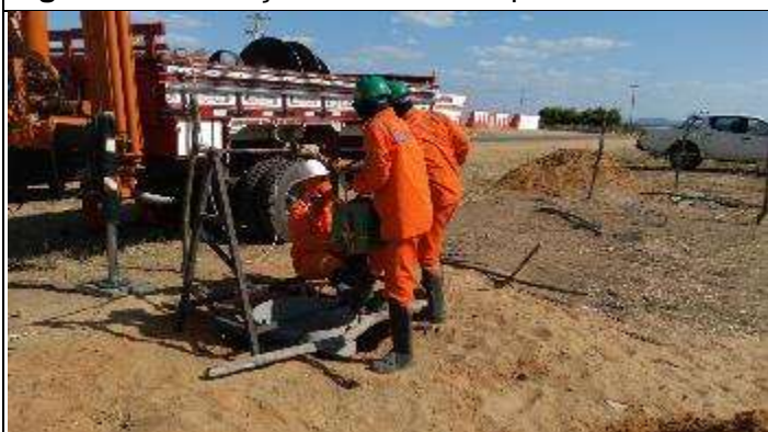
Figura 5. Escavação manual com saia na Cava C
