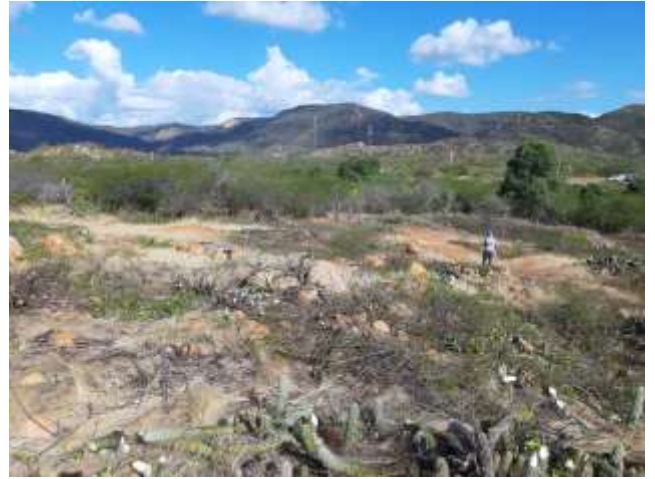
Figura 2. Supressão vegetal finalizada na Torre 70/2.
