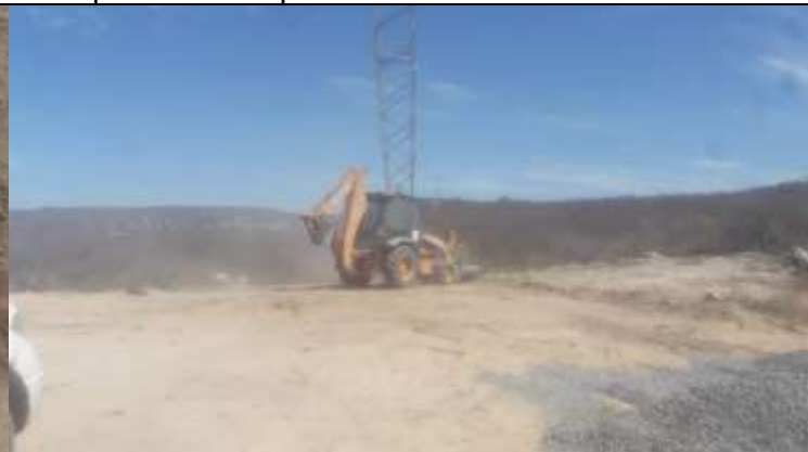
Figura 4. Retroexcavadora realizando a abertura de valas para o contrapeso na torre 46-1.
