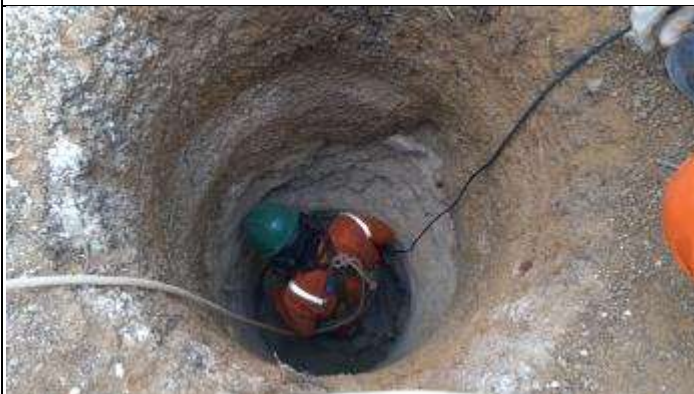
Figura 3. Reabertura cava C com martelete
