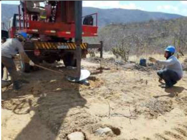
Figura 1. Torre 67/2 - Escavação com perfuratriz da cava B.
