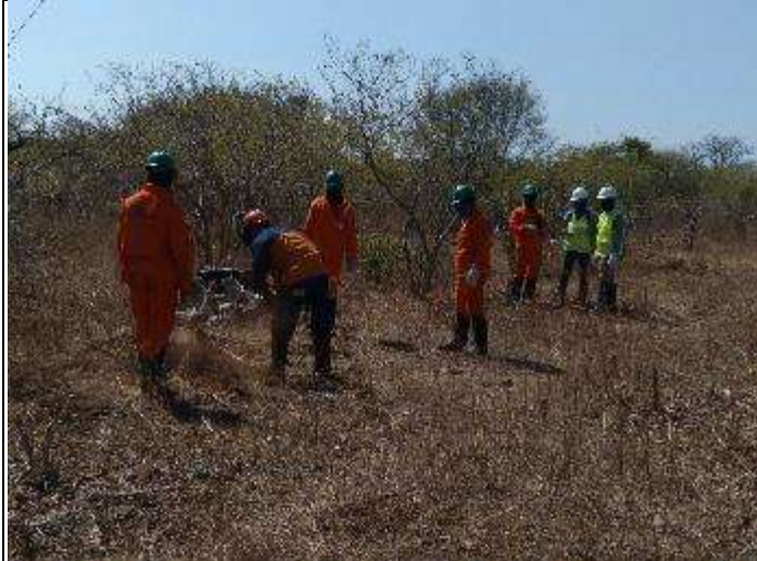
Figura 3. Supressão vegetal com moto serra no acesso da torre 38/2.
