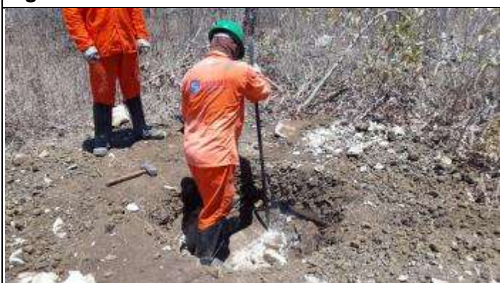
Figura 3. Abertura da cava A da torre 5/2.
