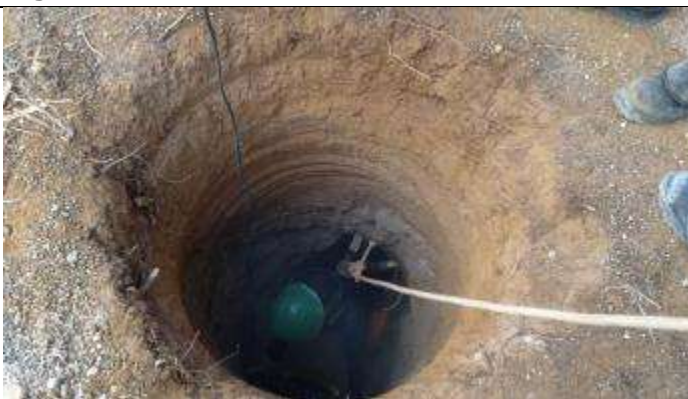
Figura 7. Reabertura cava D com martetele
