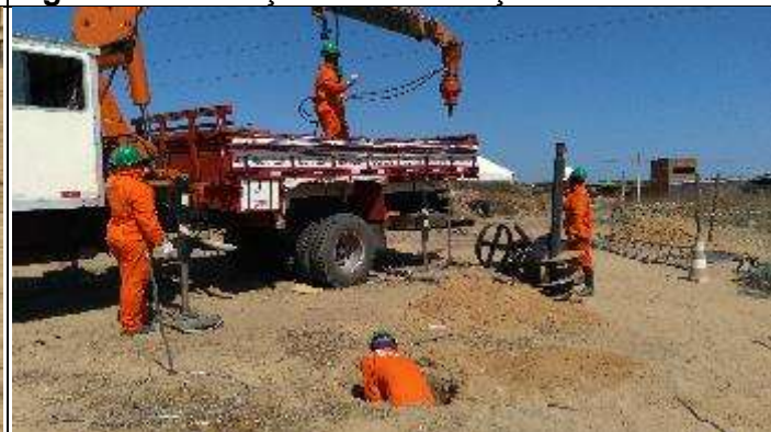
Figura 6. Escavação cava C manual
