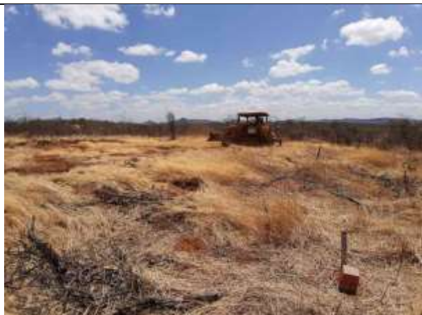
Figura 1. Torre 74/1-limpeza de praça
