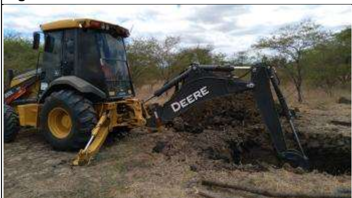
Figura 3. Abertura da cava B da torre 6/1.
