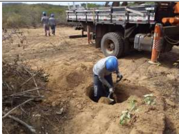
Figura 2. Escavação da Torre 39/1, cava C.
