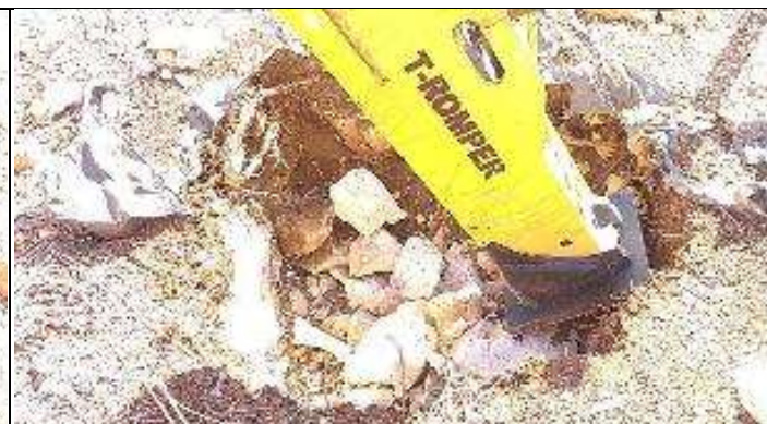
Figura 8. Reabertura cava B com picão rompedor.
