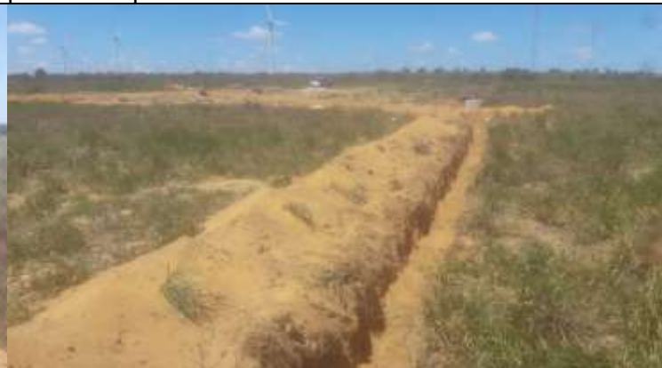
Figura 4. Atividade de escavações com retroescavadeira para abertura de valas para contrapeso na torre 63-1
