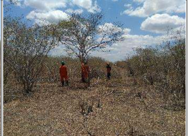
Figura 4. Supressão vegetal com moto serra no acesso da torre 38/1.
