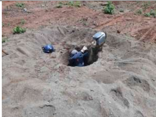
Figura 2. Torre 19/1 – escavação manual, cava B.
