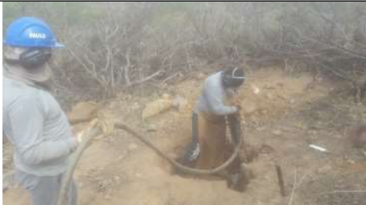
Figura 1. Atividade de escavação com martetele em cava da torre 39-2.
