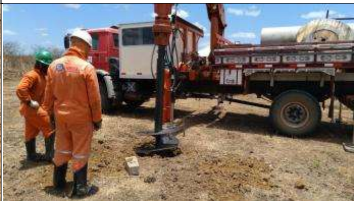
Figura 4. Abertura cava Central com perfuratriz.
