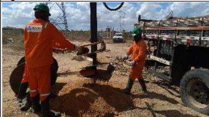
Figura 8. Retirada e verificação da cava C.
