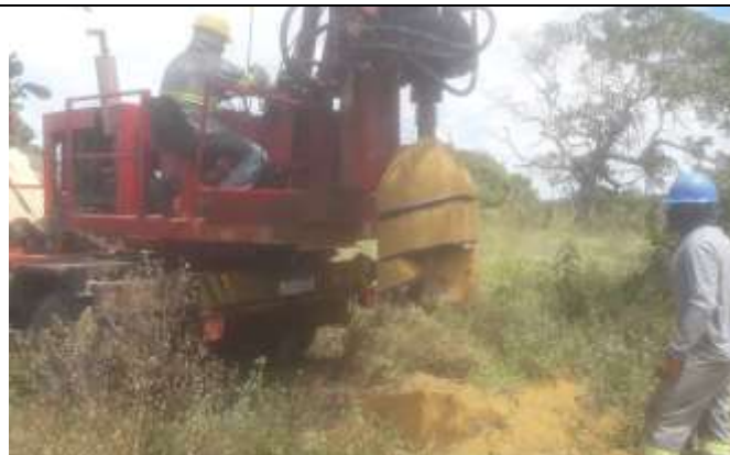
Figura 2. Atividade de escavação com perfuratriz Cava D da torre 56-2.
