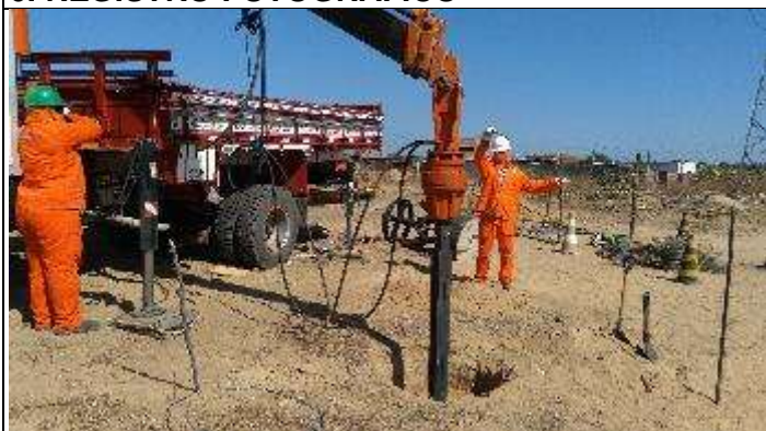
Figura 1. Escavação cava A T 76/2
