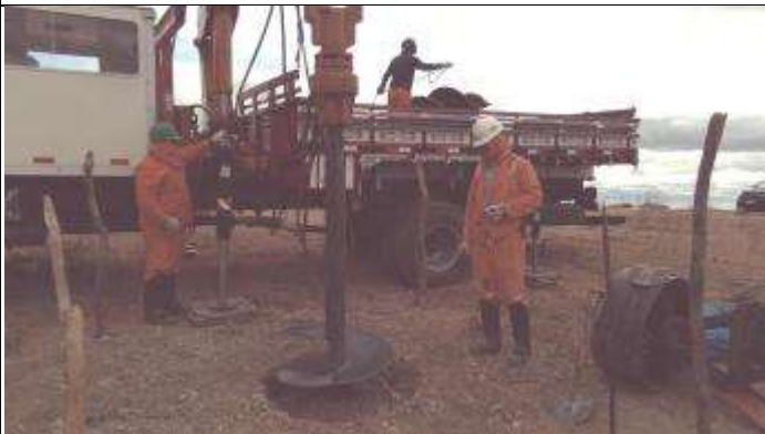
Figura 5. Escavação com perfuratriz Cava D
