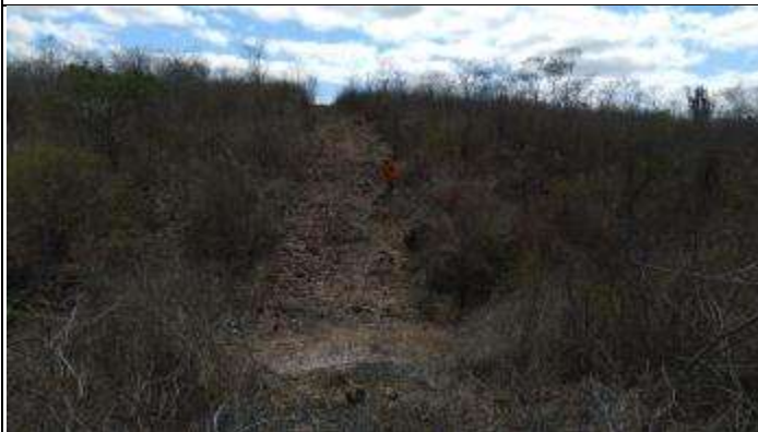
Figura 7. Supressão acesso torre 73/1
