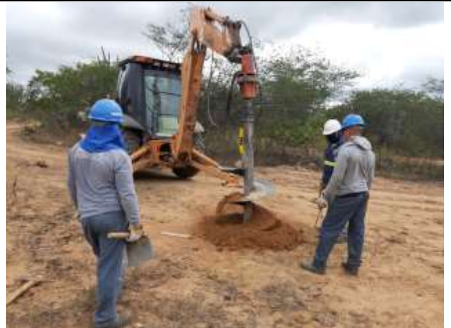
Figura 2. Escavação da Torre 50/1, cava D.
