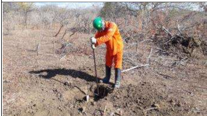
Figura 7. Abertura da cava C torre 38/1
