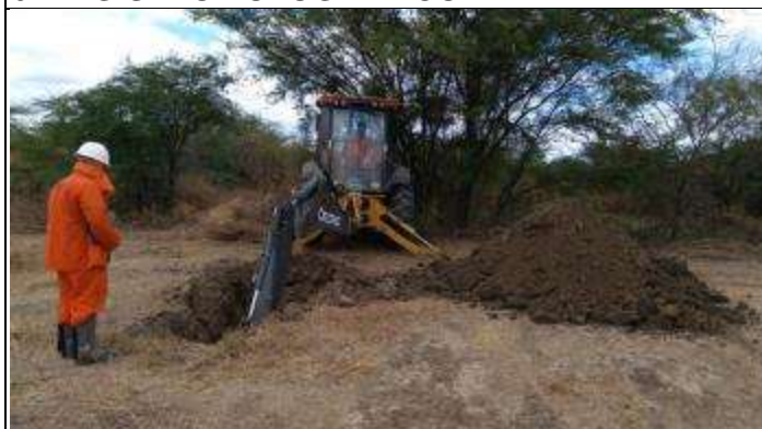
Figura 1. Abertura da cava D da Torre 5/1.
