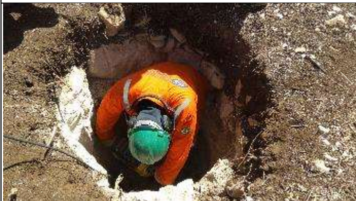
Figura 3. Reabertura Cava B com martelete T 54/4
