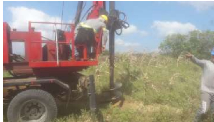
Figura 1. Caminhão-perfuratriz escavando cava na torre 25-2.
