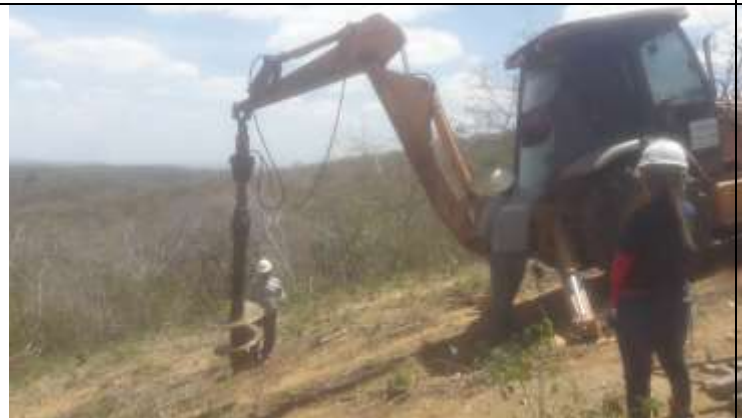
Figura 3. Atividade de escavação com retroescavadeira-perfuratriz de cava na torre 32-1.
