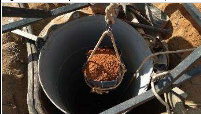
Figura 6. Escavação manual com auxílio de saia
