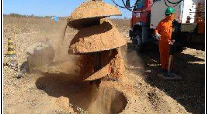
Figura 2. Abertura Cava D com perfuratriz T 76/1 A
