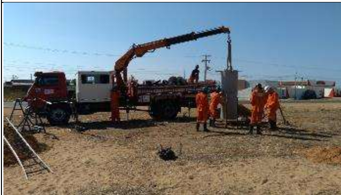
Figura 1. Colocação de saia na cava B
