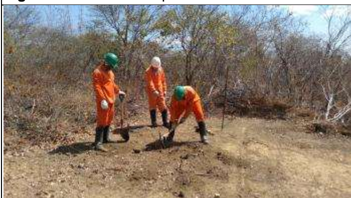
Figura 3. Abertura cava D com pá e alavanca.
