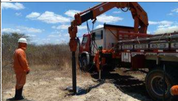
Figura 4. Abertura cava B com perfuratriz T 45/1.
