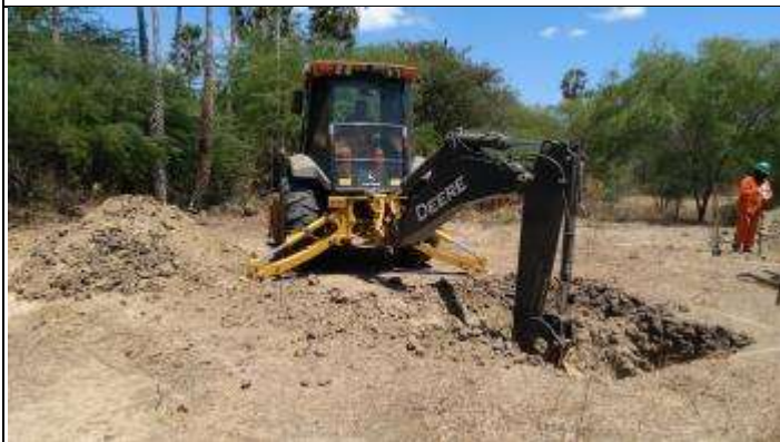
Figura 1. Início de abertura da cava B da Torre 5/2.
