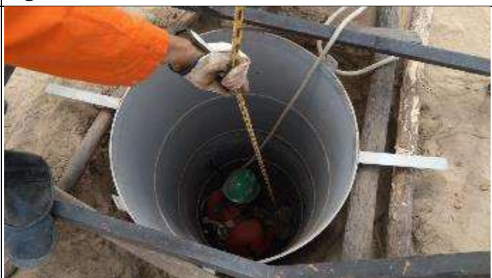
Figura 4. Retirada de excesso de material T 76/2
