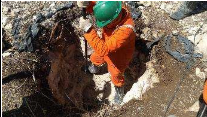
Figura 1. Reabertura cava A com alavanca T 54/4.
