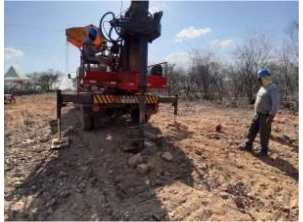
Figura 4. Torre 79/1 - Posicionamento da perfuratriz durante escavação da cava D.
