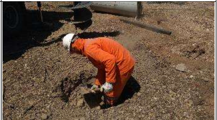
Figura 4. Escavação com pá Cava A - T 76/1
