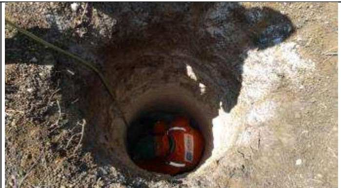
Figura 2. Escavação com martetele cava A
