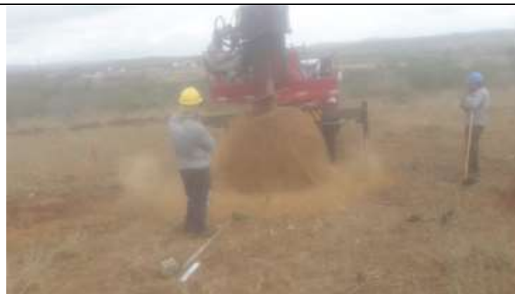
Figura 3. Escavação com perfuratriz de cava na torre 3-1.
