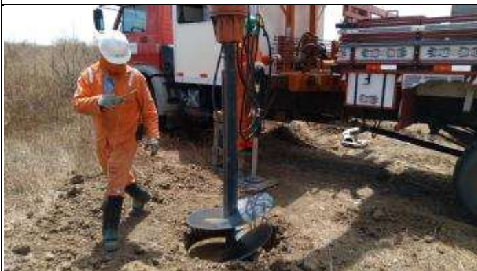
Figura 5. Abertura cava B com perfuratriz.
