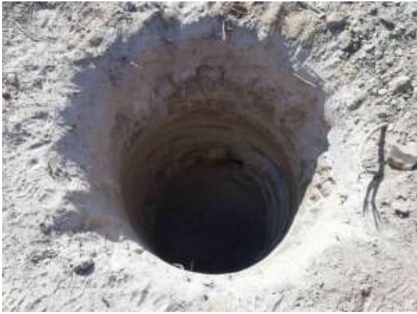
Figura 5. Escavação da torre 82/2, Cava C finalizada.
