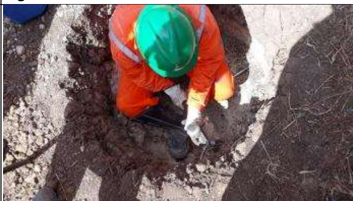
Figura 8. Abertura cava central torre 45/2
