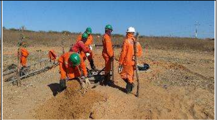
Figura 2. Finalização cava C Torre 76/1 A
