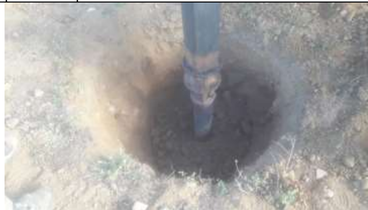
Figura 5. Atividade de escavação por caminhão-perfuratriz para cavas nas torres 30-2.
