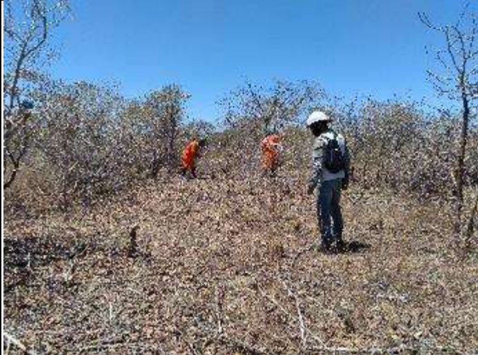
Figura 3. Supressão vegetal no acesso da torre 38/1.
