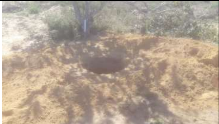
Figura 3. Atividade de escavação para contrapeso com retroescavadeira na torre 62-2.
