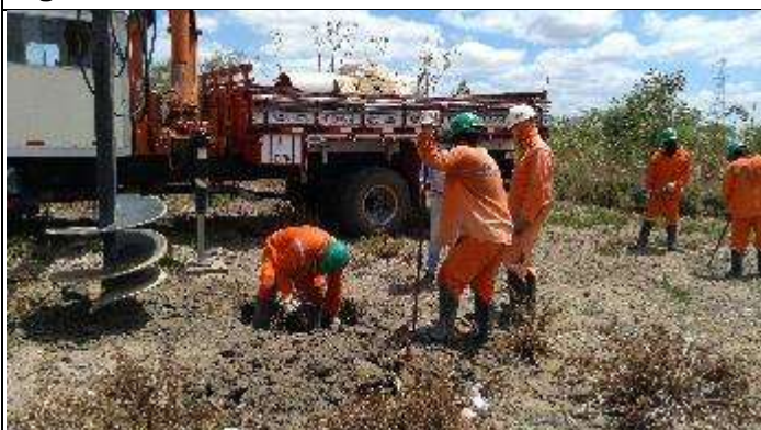
Figura 3. Abertura cava B com alavanca T 4-2
