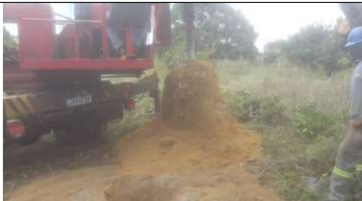
Figura 1. Atividade de escavação com perfuratriz Cava B da torre 56-2.
