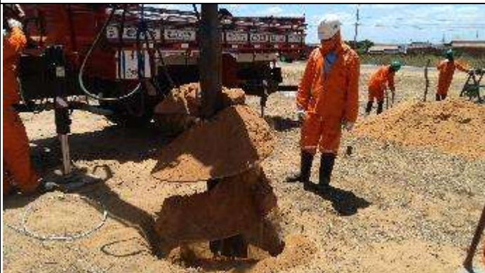
Figura 3. Início de abertura Cava C com perfuratriz
