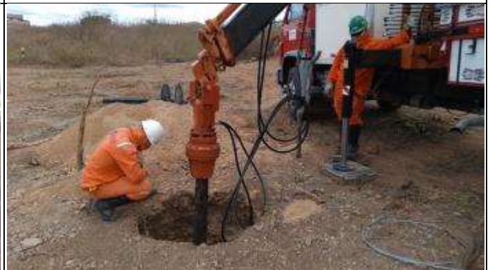
Figura 6. Escavação com perfuratriz Cava D
