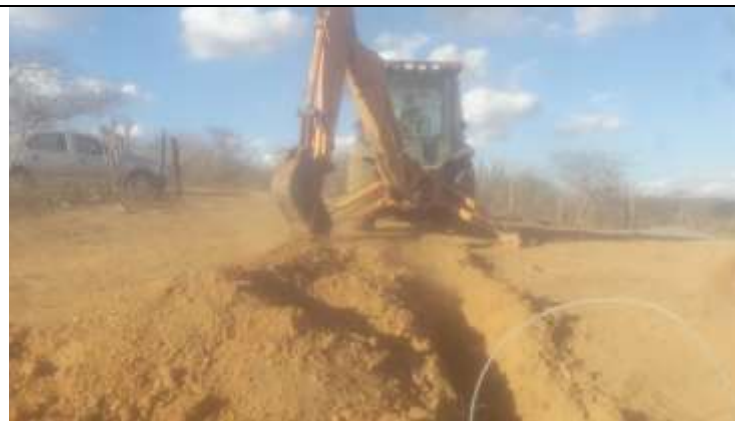
Figura 5. Escavação com retroescavadeira de vala na torre 38-1.
