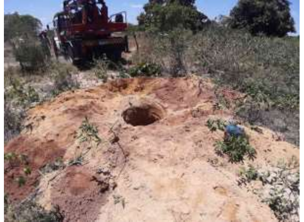
Figura 2. Torre 57/1 – finalização da escavação com perfuratriz da cava C.
