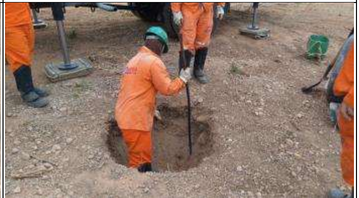
Figura 4. Escavação com alavanca na cava D
