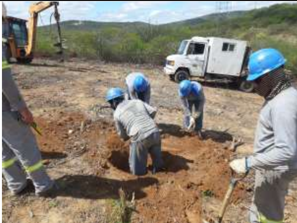
Figura 1. Escavação da torre 51/1 cava central.
