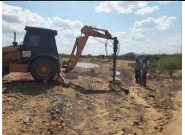
Figura 4. Torre 80/1 - Posicionamento da retro-escavadeira durante escavação da cava B.
