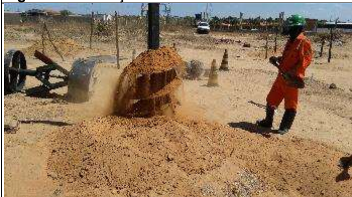
Figura 3. Escavação com mudança de solo
