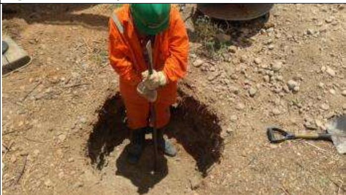
Figura 5. Escavação com alavanca cava B
