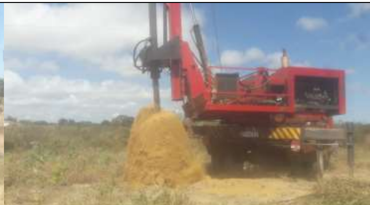
Figura 2. Acompanhamento da perfuratriz na abertura de cavas na torre 59-1.
