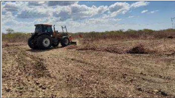
Figura 9. Limpeza de faixa Torre 37/2
