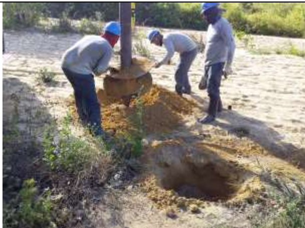
Figura 1. Escavação da torre 57/2 cava C.
