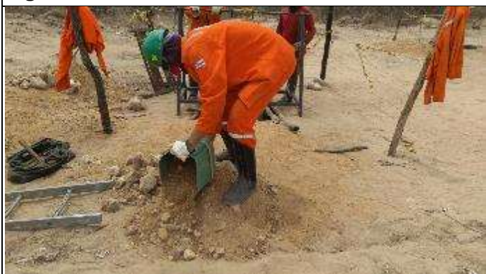
Figura 3. Retirada de excesso de material T 76/2
