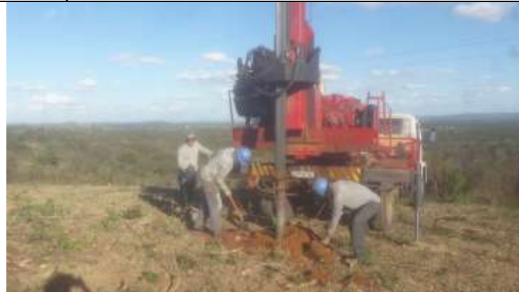
Figura 5. Atividade de escavações por perfuratriz para cavas na torre 29-1.
