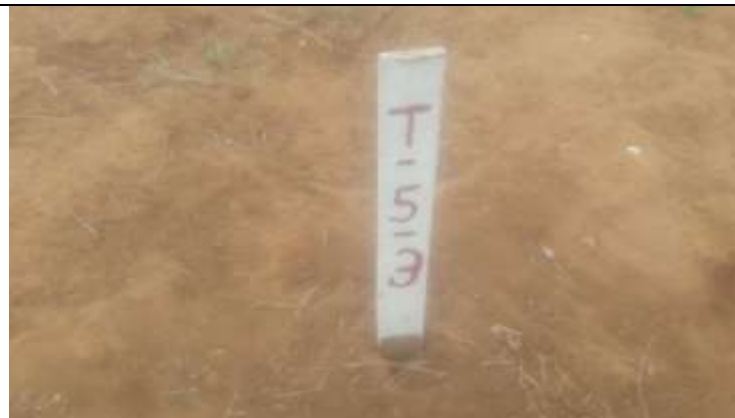
Figura 1. Marco central da torre 5-3.
