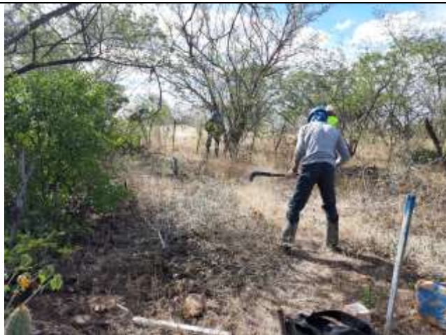
Figura 2. Supressão vegetal na Torre 72/1.
