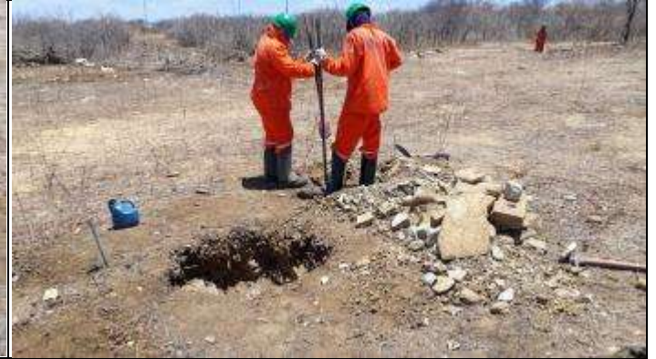
Figura 8. Abertura cava central torre 38/2
