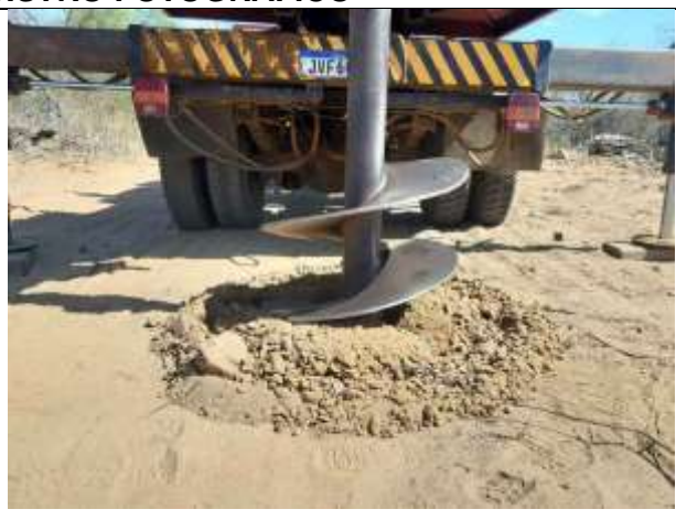
Figura 1. Torre 72/2- Escavação com perfuratriz da cava D.
