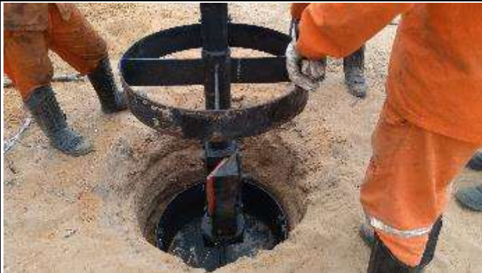
Figura 3. Escavação com broca para saia.
