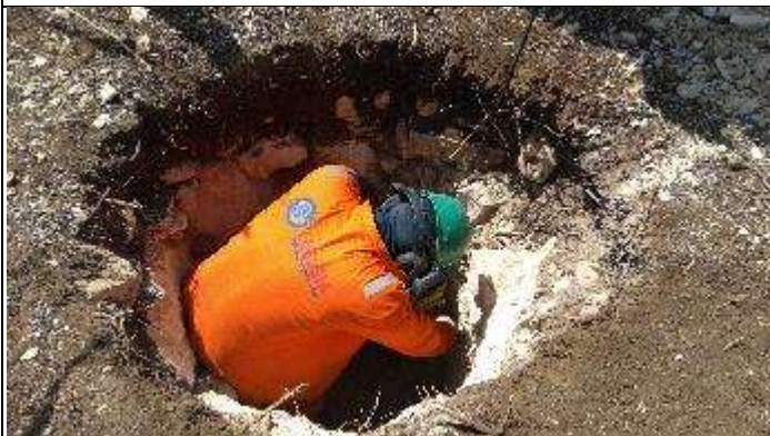
Figura 5. Reabertura Cava C com Martelete.
