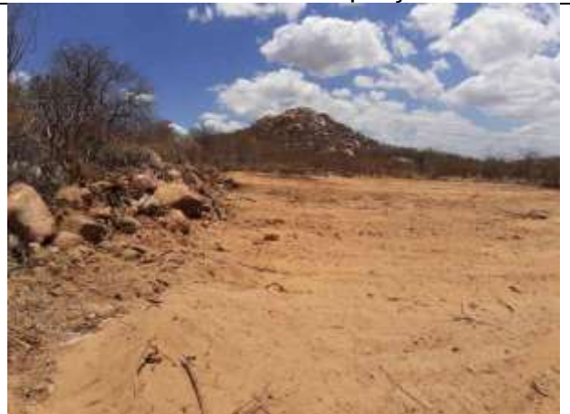
Figura 4. Torre 72/2 – material removido é deixado na extremidade da praça.
