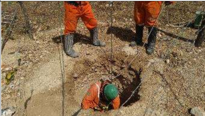
Figura 5. Reabertura Cava D com martetele T 56/1
