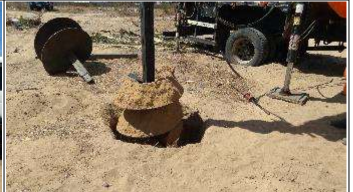
Figura 4. Abertura cava C na Torre 76-2 até 40cm
