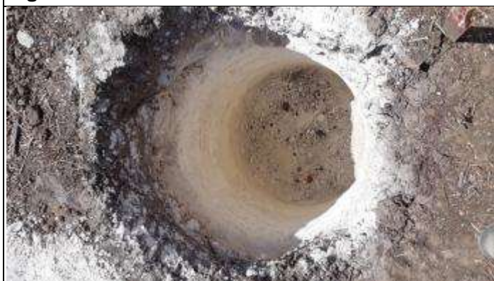
Figura 7. Finalizando Abertura cava B torre 45/2
