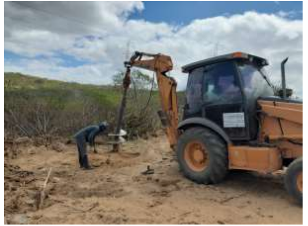
Figura 4. Supressão vegetal da Torre 41/1, cava C.
