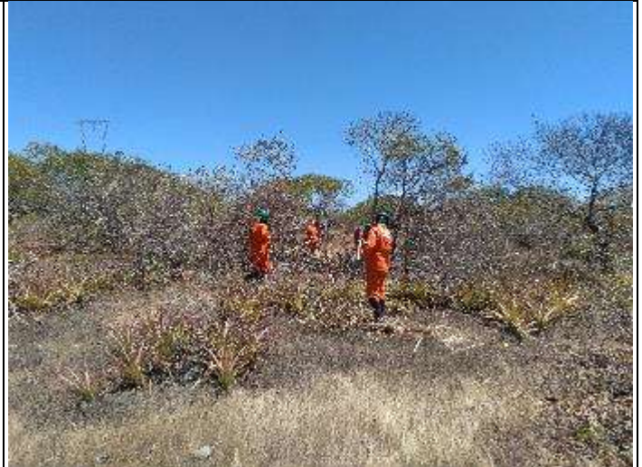
Figura 2. Supressão vegetal no acesso da torre 38/2.
