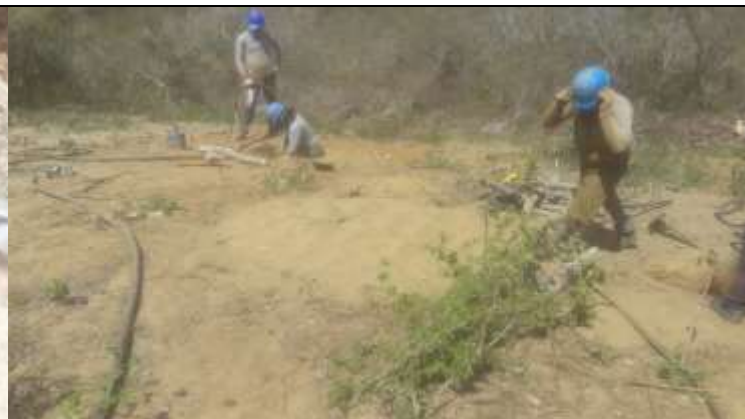
Figura 4. Vistoria nas escavações feitas com martelete, sobre material rochoso.
