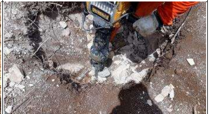
Figura 4. Reabertura Cava A com martetele T 54/4.
