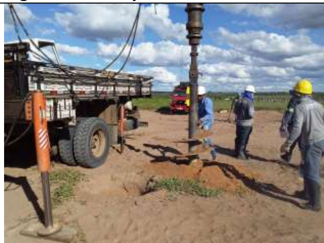
Figura 2. Escavação da Torre 59/2, cava B.
