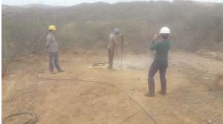
Figura 1. Atividade de escavação com martelete em cava da torre 40-1.
