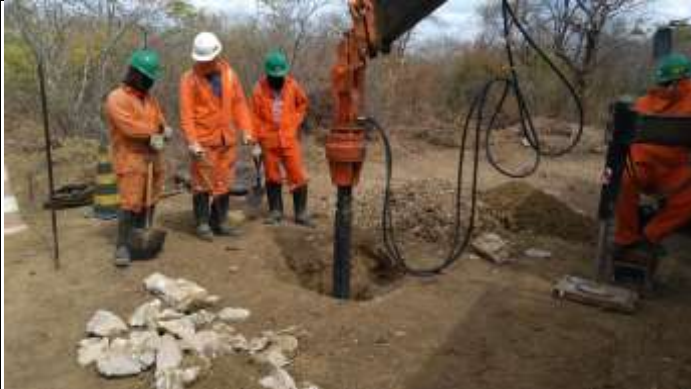
Figura 1. Reabertura com perfuratriz Cava A
