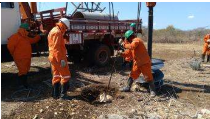
Figura 5. Escavação com alavanca cava A T 54/4
