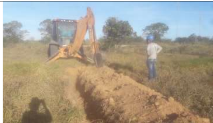
Figura 9. Atividade de escavação para contrapeso com retroescavadeira na 62-2
