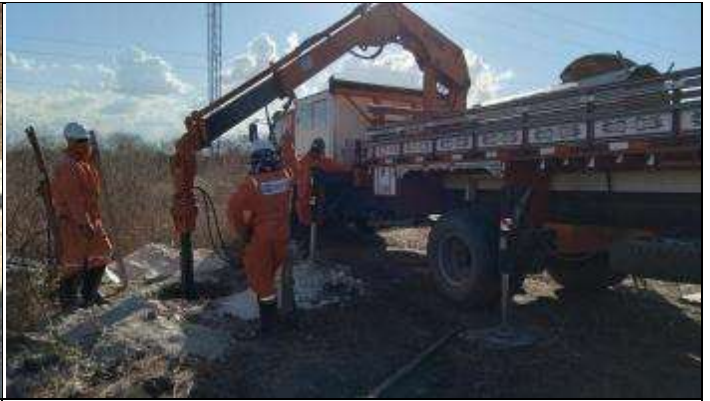
Figura 8. Abertura cava D com perfuratriz torre 45/2
