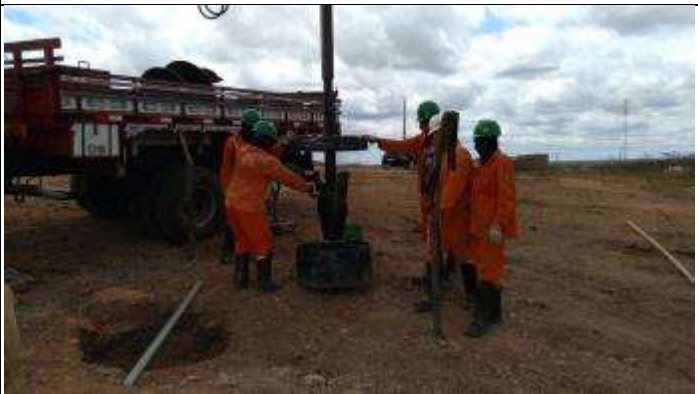
Figura 3. Escavação com broca especial cava C
