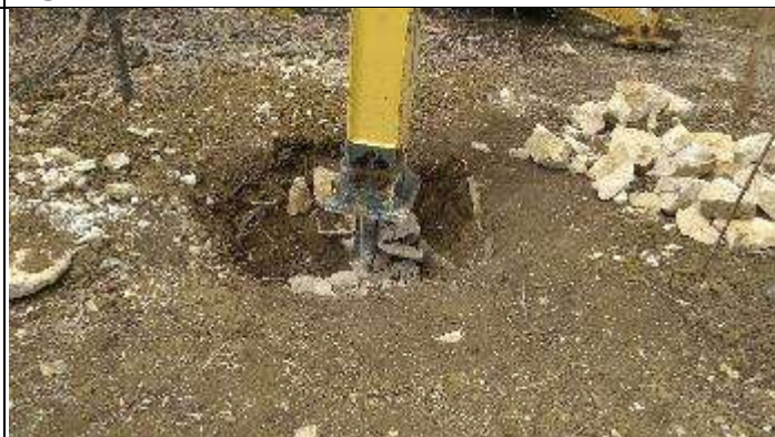
Figura 8. Continuação com picão rompedor
