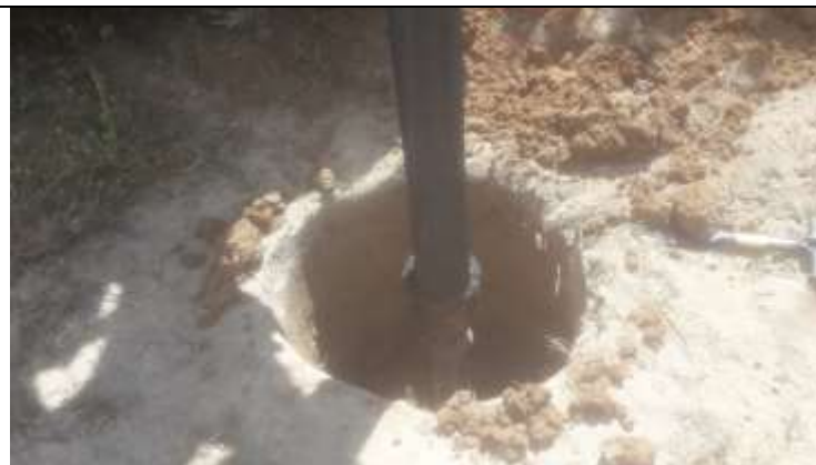
Figura 3. Caminhão-perfuratriz escavando cava na torre 25-2.
