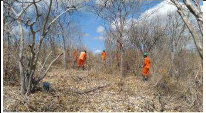
Figura 2. Supressão acesso torre 73/2
