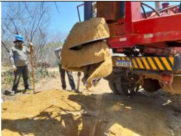
Figura 1. Torre 71/2- Escavação com perfuratriz da cava A.
