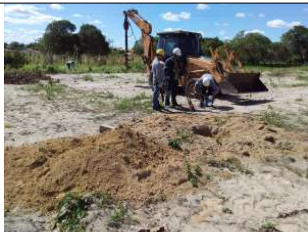
Figura 2. Escavação da Torre 55/1, cava Central.
