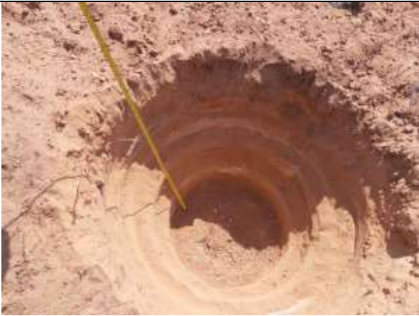
Figura 5. Escavação da torre 80/2, cava Central.
