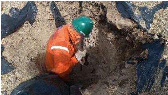
Figura 3. Reabertura Cava A com alavanca T 56/1
