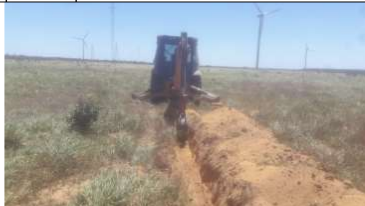
Figura 3. Atividade de escavações com retroescavadeira para abertura de valas para contrapeso na torre 63-1
