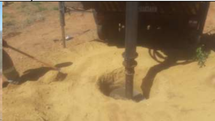
Figura 4. Caminhão perfuratriz em atividade de escavação na torre 11-1.
