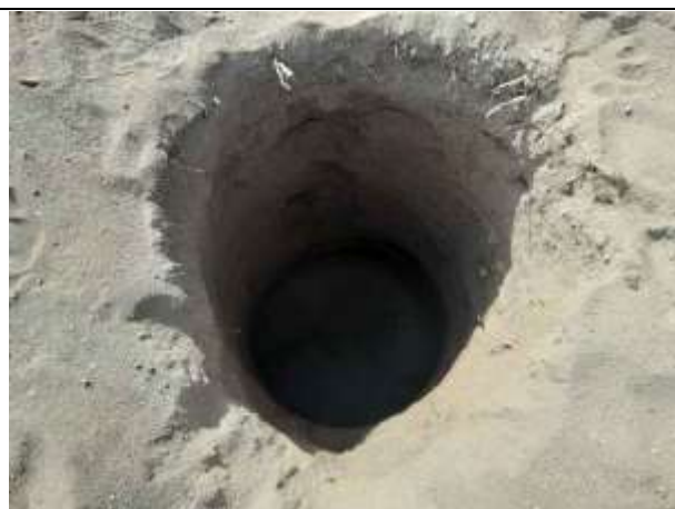
Figura 4. Torre 68/1 - Posicionamento da perfuratriz durante escavação da cava D.
