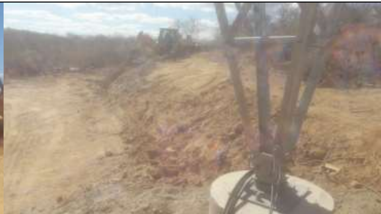
Figura 6. Escavação com retroescavadeira de vala para contrapeso na torre 40-1.
