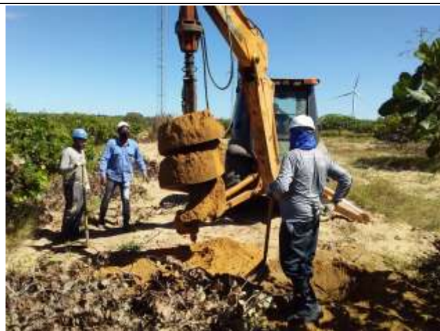
Figura 2. Escavação da Torre 59/2, cava B.
