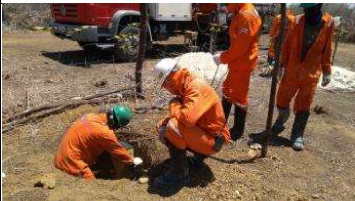
Figura 3. Reabertura da cava A com martetele
