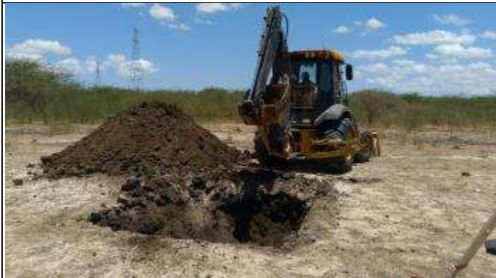
Figura 3. Abertura da cava B da torre 6/2.
