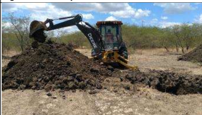
Figura 4. Abertura cava A da torre 6/1.
