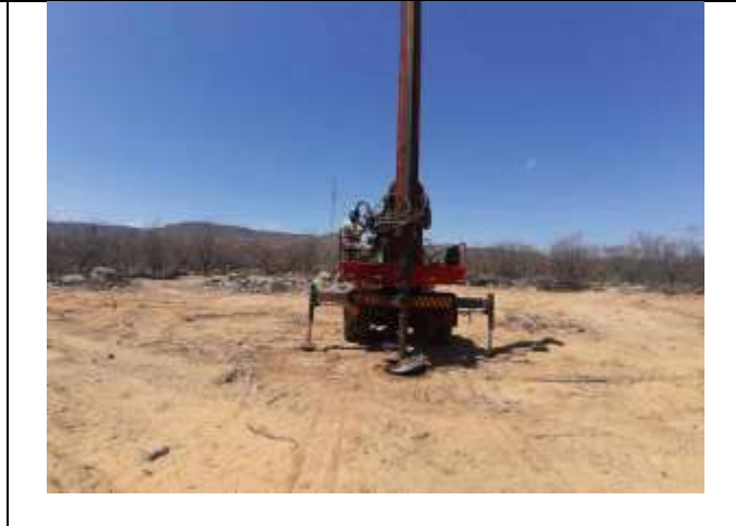
Figura 2. Torre 71/3-Escavação com perfuratriz da cava Central.
