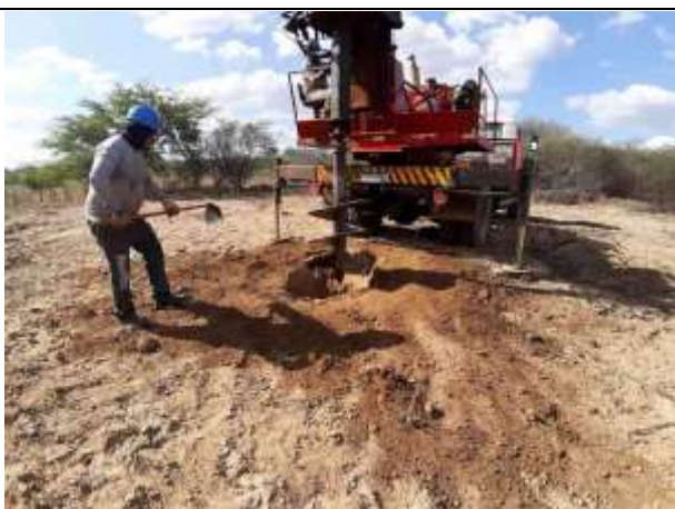
Figura 1. Torre 67/2 - Escavação com perfuratriz da cava B.
