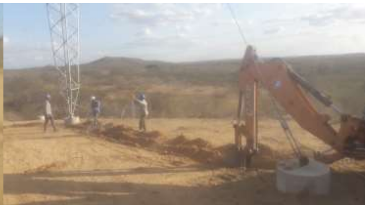
Figura 8. Abertura de vala por retroescavadeira para contrapeso na torre 43-2.
