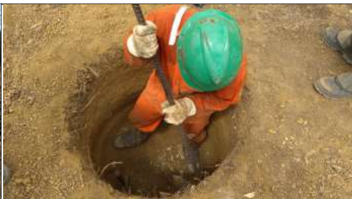
Figura 2. Finalização cava C com alavanca 1,10m
