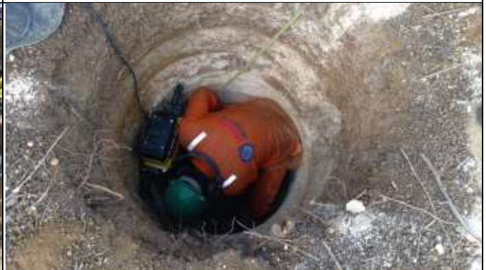
Figura 6. Reabertura com rompedor cava B T 54/3
