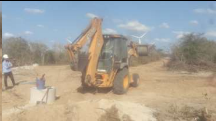
Figura 6. Atividade de escavação para contrapeso com retroescavadeira na torre 64-2.
