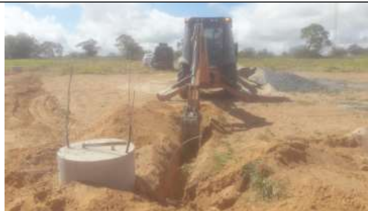
Figura 1. Atividade de escavação com retroescavadeira para abertura de valas para contrapeso na torre 63-1.
