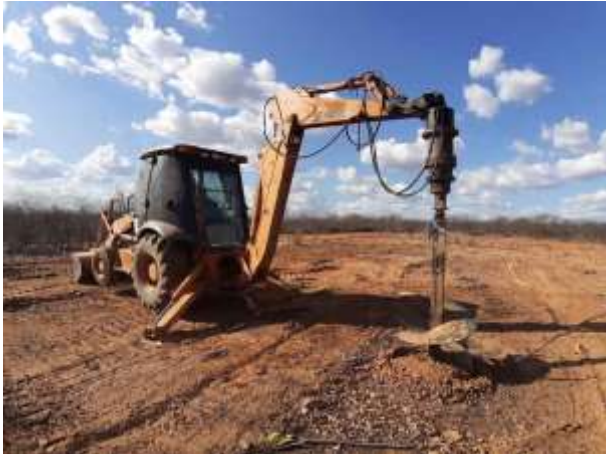
Figura 1. Escavação com retroescavadeira da torre 84/1, cava B
