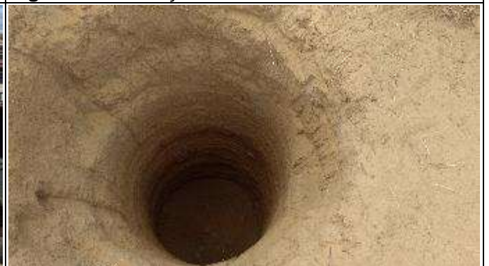
Figura 8. Finalização da escavação da cava C.
