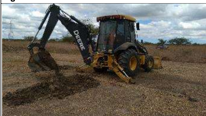
Figura 3. Início de abertura da cava B torre 5/1.
