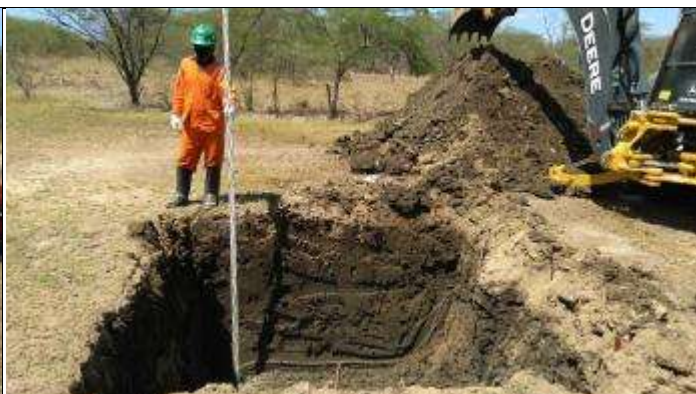
Figura 2. Finalizando escavação da cava A.
