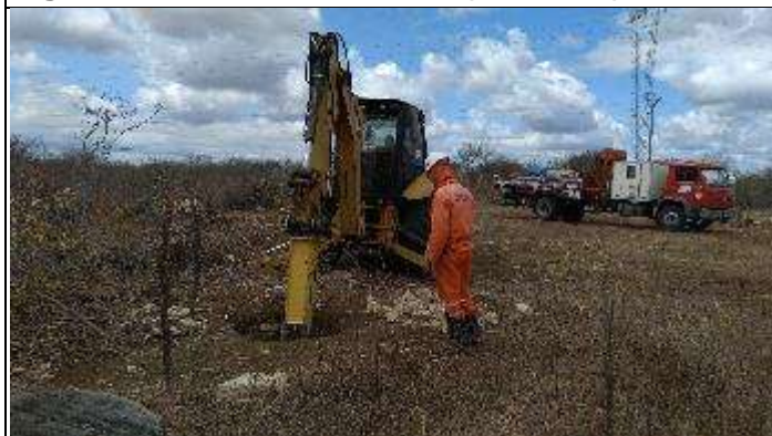
Figura 7. Abertura com picão rompedor
