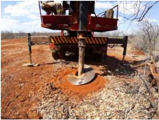
Figura 1. Escavação com perfuratriz da torre 86/2, cava B
