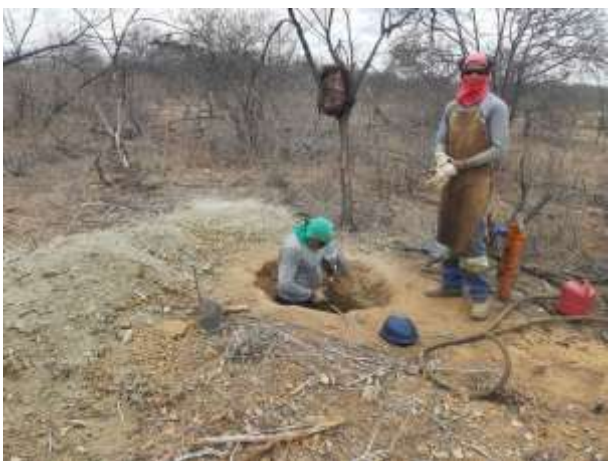
Figura 1. Escavação com rompedor da torre 89/1, cava Central
