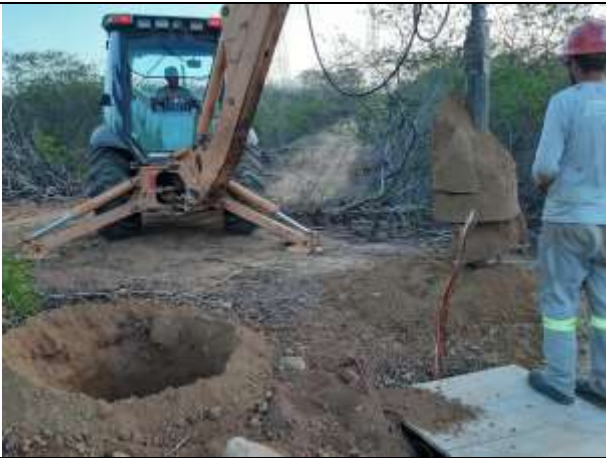
Figura 4. Supressão vegetal da Torre 44/1, cava C.
