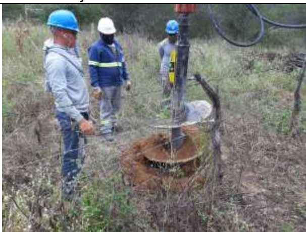
Figura 1. Escavação da torre 51/1 cava central.
