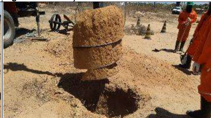
Figura 4. Escavação com mudança de solo
