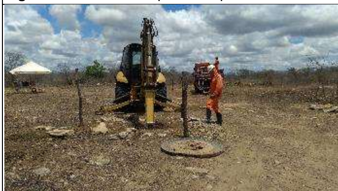
Figura 9. Abertura com picão rompedor cava D
