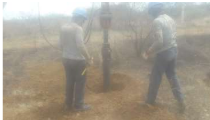
Figura 3. Escavação com perfuratriz de cava na torre 5-3.
