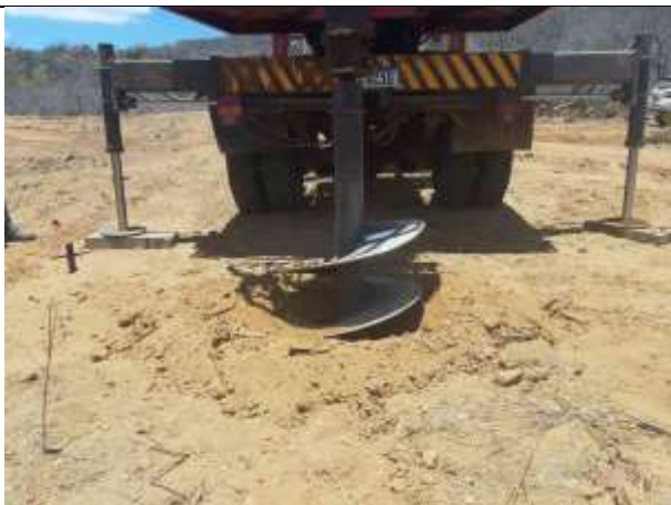
Figura 1. Torre 57/1, cava C.
