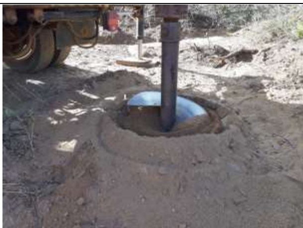
Figura 3. Escavação da torre 41/2, cava A.
