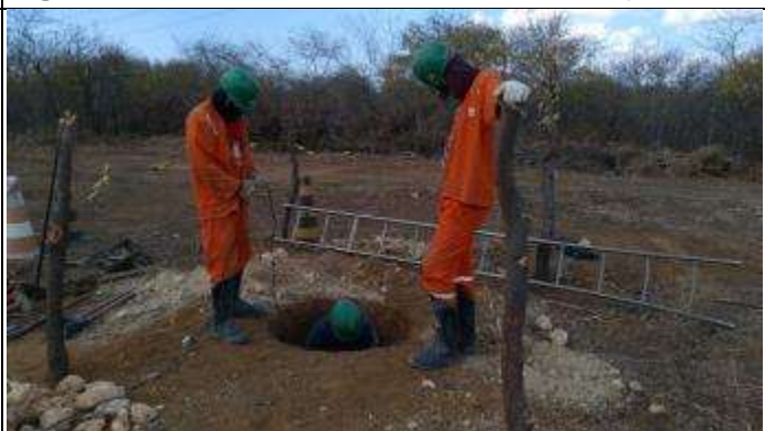
Figura 10. Escavação cava C com martetele.
