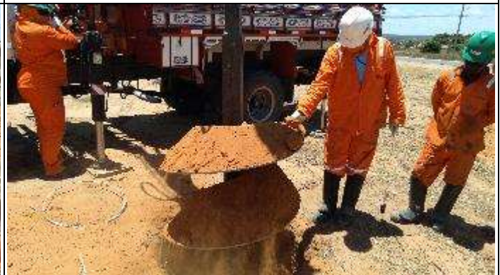
Figura 4. Verificação da escavação Cava C
