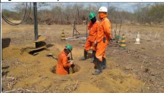
Figura 4. Finalização com alavanca cava D
