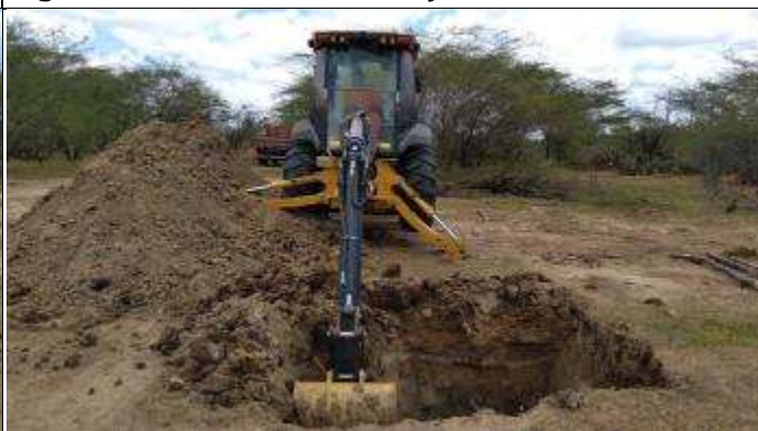
Figura 4. Abertura cava C da torre 7/1.
