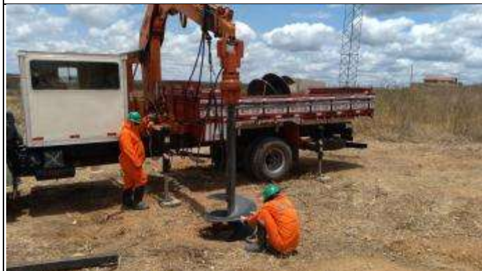
Figura 11. Abertura na Cava C
