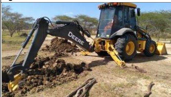
Figura 5. Abertura cava B com retroescavadeira
