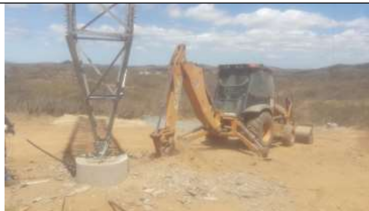
Figura 3. Escavação com retroescavadeira de vala para contrapeso na torre 45-2.
