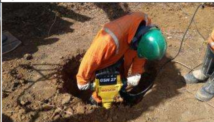
Figura 4. Abertura cava A com martetele rompedor
