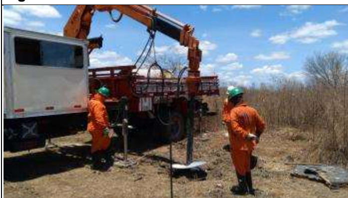
Figura 5. Inicio abertura cava C torre 45/1
