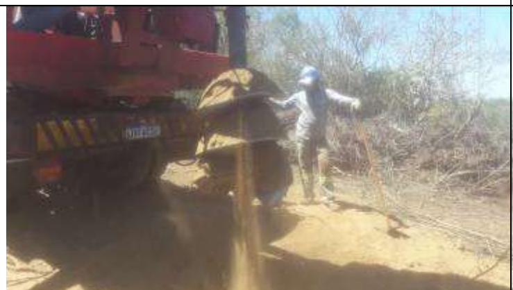
Figura 3. Caminhão-perfuratriz escavando cava na torre 27-2.
