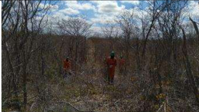
Figura 1. Supressão acesso torre 73/2
