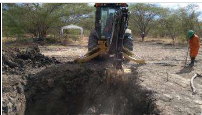
Figura 6. Finalizando cava D torre 6/1
