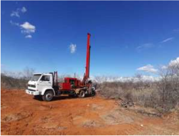
Figura 1. Escavação com perfuratriz da torre 86/2, cava A
