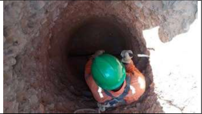
Figura 2. Abertura com alavanca cava C
