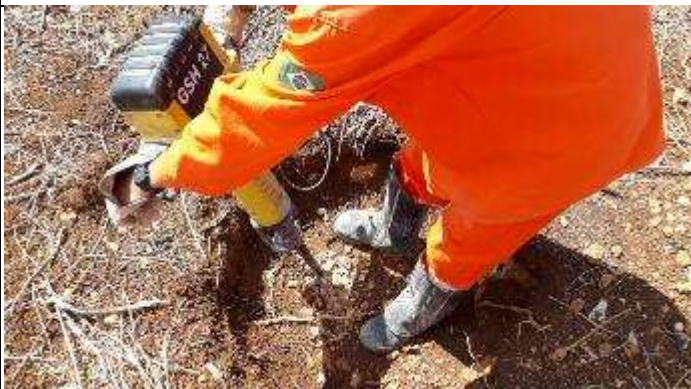
Figura 3. Reabertura Cava A com martetele T 54/4
