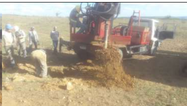
Figura 4. Atividade de escavação por caminhão-perfuratriz para cavas nas torres 30-2.
