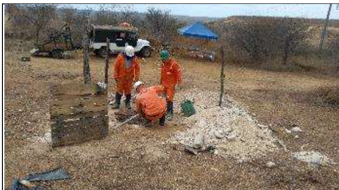
Figura 7. Reabertura cava D com martelete.
