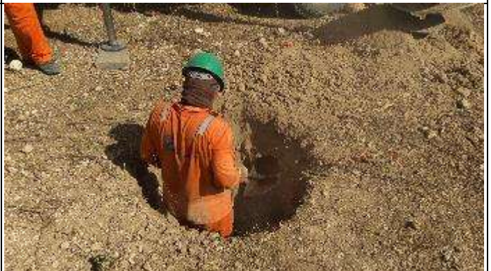
Figura 8. Escavação Cava C com pá T 56/1
