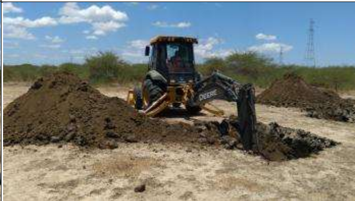
Figura 4. Abertura cava A da torre 6/2.
