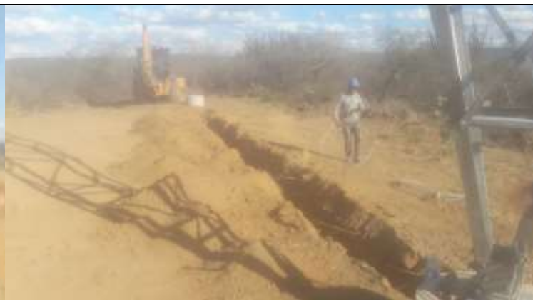
Figura 6. Escavação com retroescavadeira de vala na torre 38-1.
