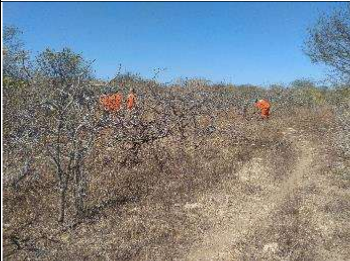
Figura 3. Supressão vegetal no acesso da torre 39/1.
