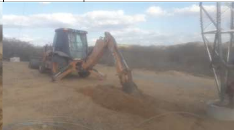
Figura 6. Abertura de vala por retroescavadeira para contrapeso na torre 44-1.
