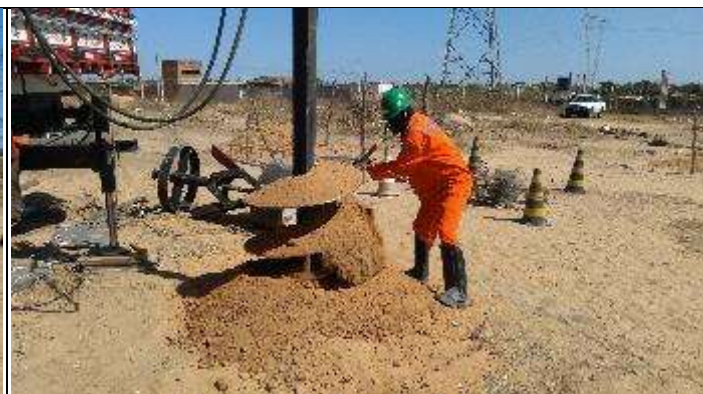
Figura 2. Escavação cava A T 76/2
