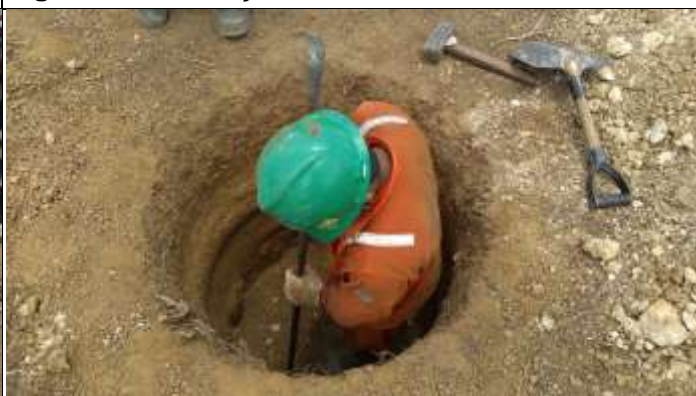
Figura 6. Escavação finalizada a 1,60 m cava B
