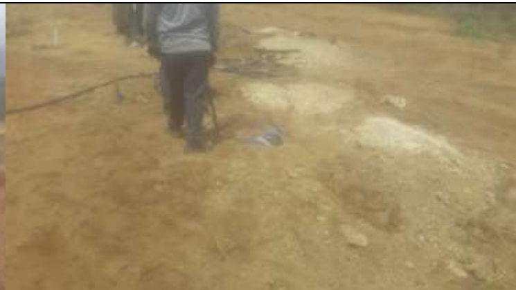
Figura 6. Escavação com rompedor de cavas na torre 4-1.
