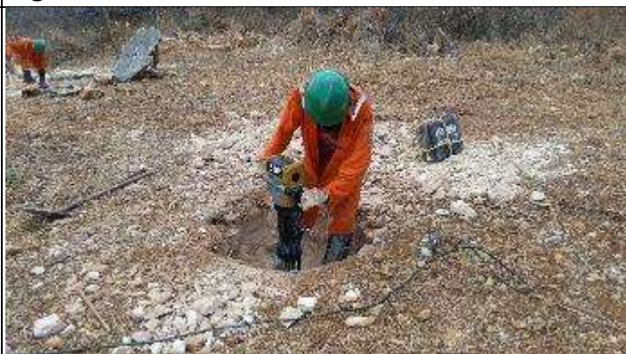
Figura 10. Reabertura cava B com martelete.
