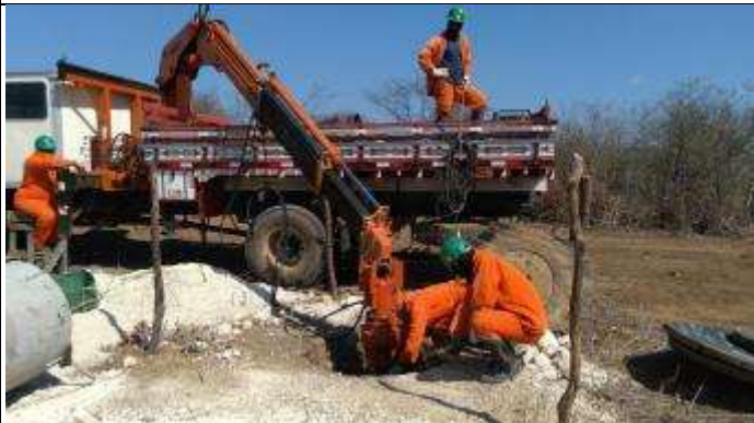
Figura 1. Escavação com perfuratriz cava A
