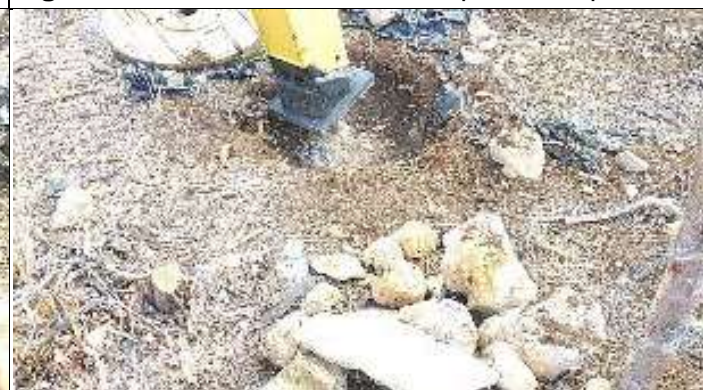
Figura 10. Reabertura cava D com picão rompedor.
