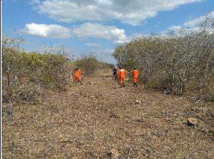
Figura 3. Supressão vegetal com moto serra no acesso da torre 38/1.
