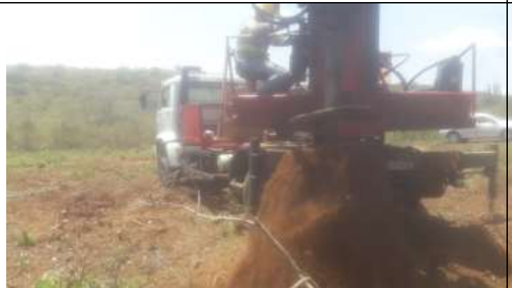
Figura 3. Caminhão-perfuratriz escavando cava na torre 13-2.
