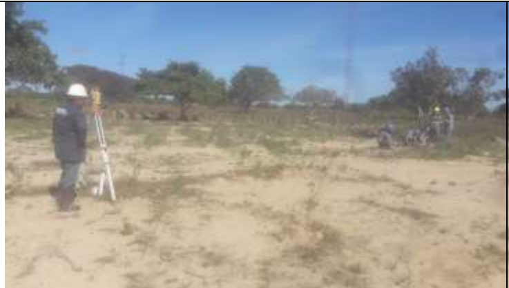
Figura 1. Equipe de topografia alocando os pontos da torre 54-2.
