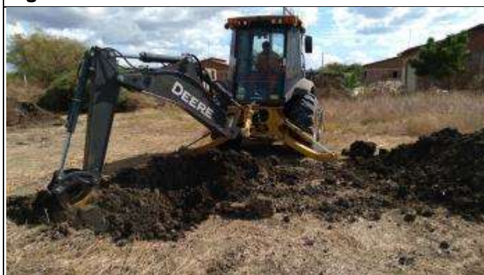
Figura 3. Abertura da cava A da torre 5/1.
