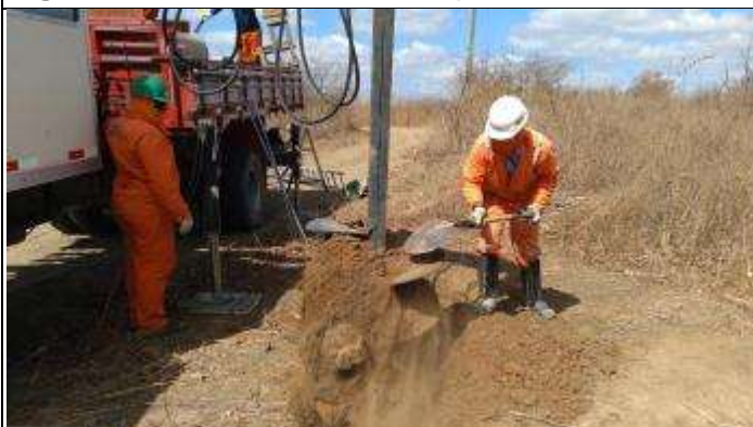
Figura 3. Abertura da cava A com perfuratriz
