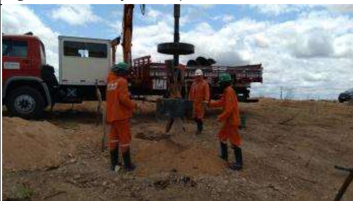
Figura 7. Escavação com broca especial
