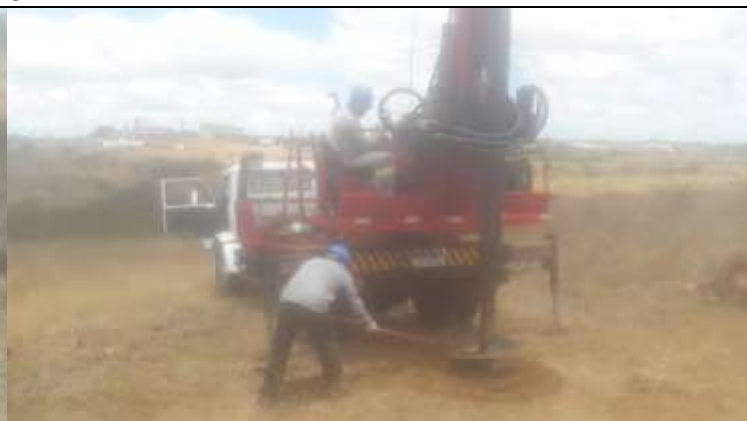
Figura 4. Escavação com perfuratriz de cava na torre 5-1.
