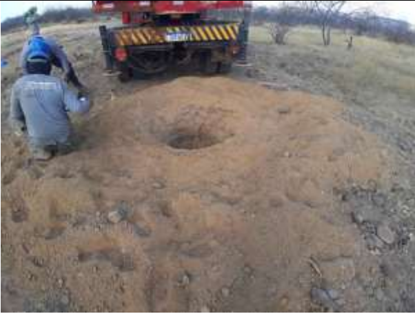
Figura 5. Escavação da torre 74/2, cava B.
