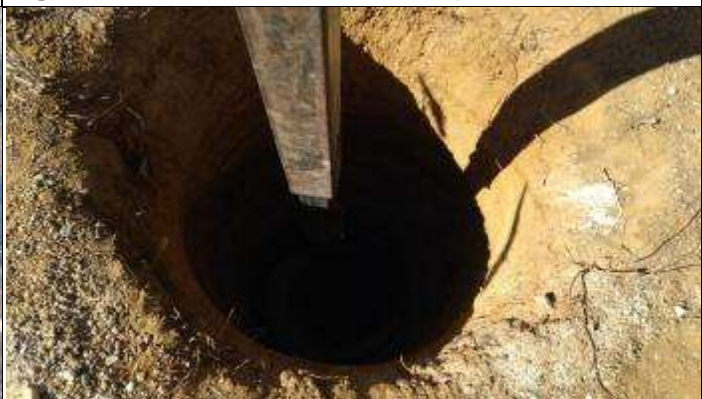
Figura 8. Finalizando cava D com perfuratriz
