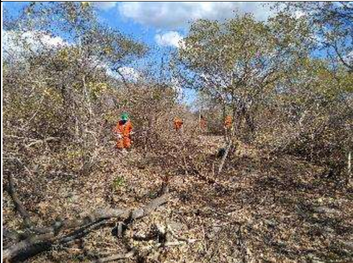
Figura 5. Supressão vegetal no início da torre 38/2.
