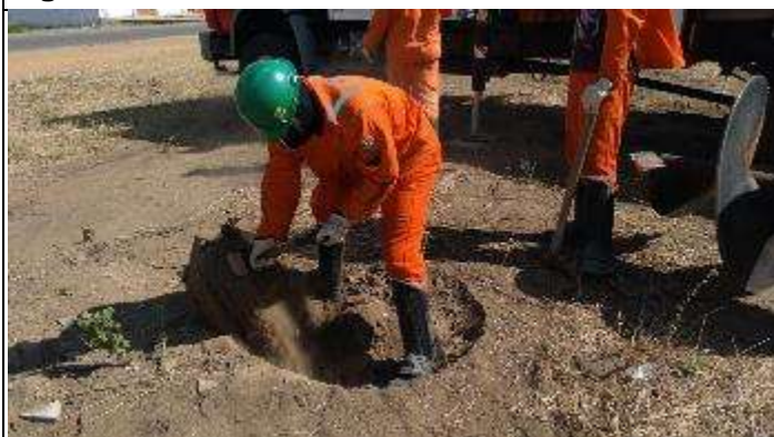
Figura 5. Escavação com pá cava A.
