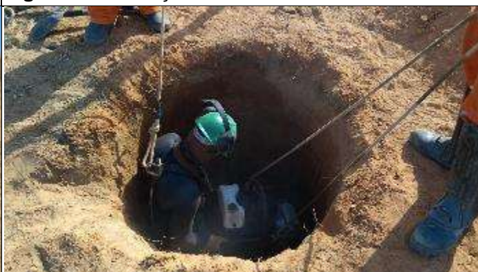
Figura 4. Compactação na cava C antiga.
