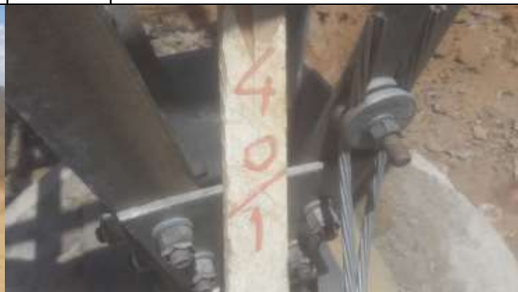
Figura 4. Marco central da torre 40-1.
