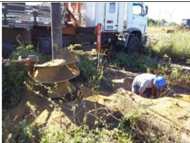
Figura 1. Escavação da torre 60/1 cava B.
