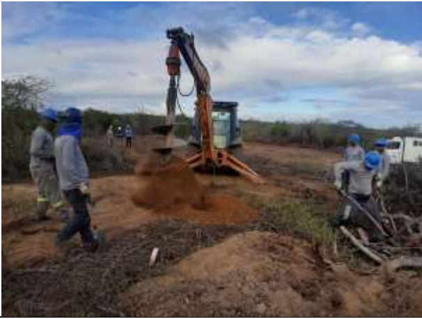
Figura 5. Escavação da Torre 47/2, cava B.
