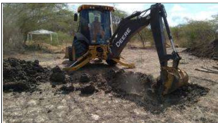
Figura 5. Inicio abertura da cava D torre 6/1
