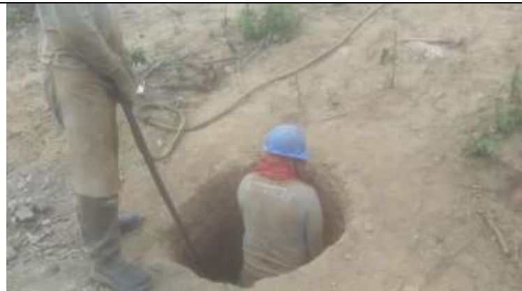
Figura 3. Atividade de escavação com martetele em cava da torre 38-1.
