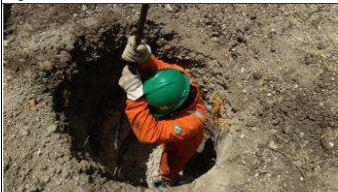
Figura 3. Abertura da cava A com alavanca T 45/1.
