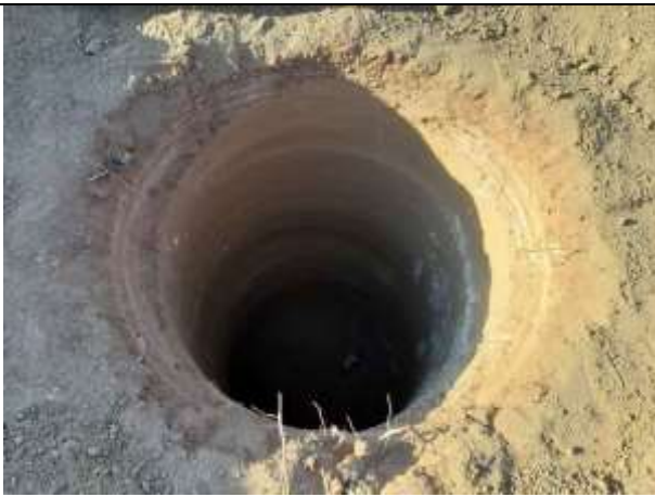
Figura 7. Escavação da torre 73/1, cava A finalizada.
