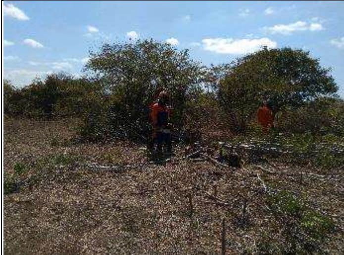
Figura 1. Supressão vegetal com moto serra no acesso da torre 38/2.
