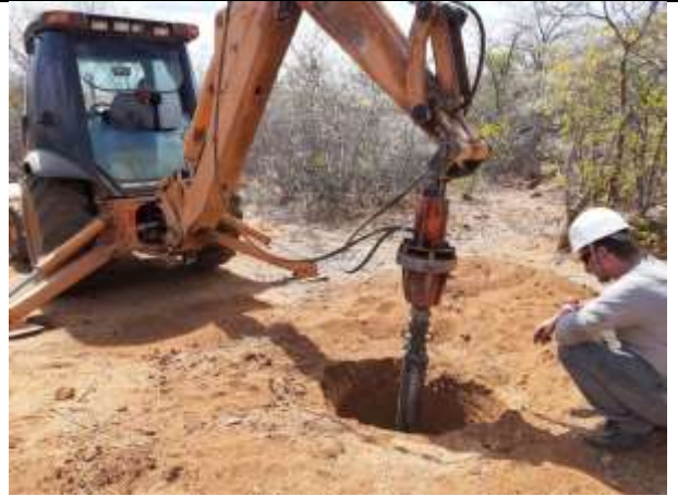
Figura 1. Torre 70/2, cava A. Figura 2. Torre 70/2 - Escavação com retroescavadeira e trado da cava A.
