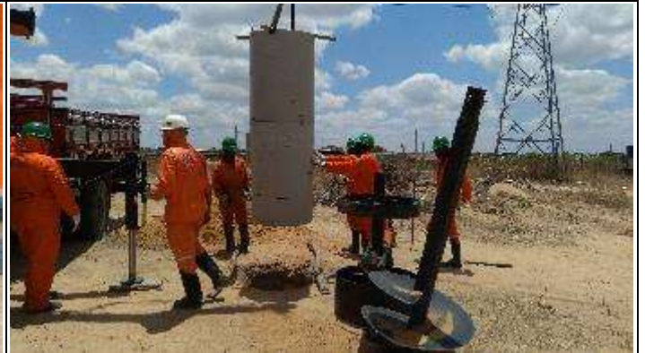
Figura 4. Colocação de saia na cava B na Torre 76-2
