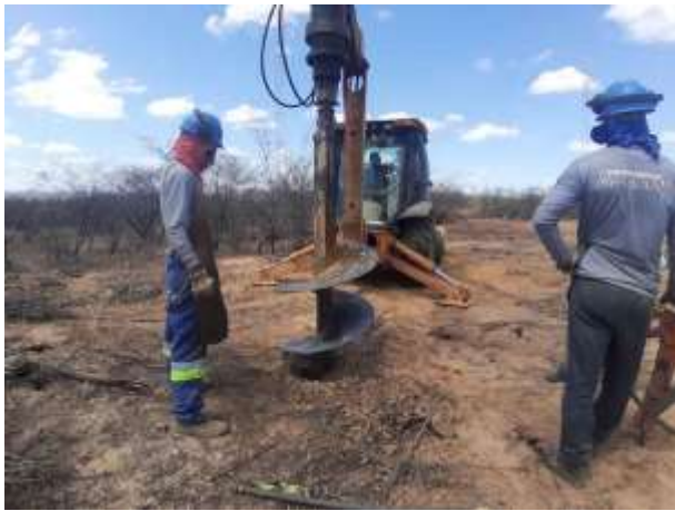
Figura 1. Escavação com retroescavadeira da torre 85/1, cava A
