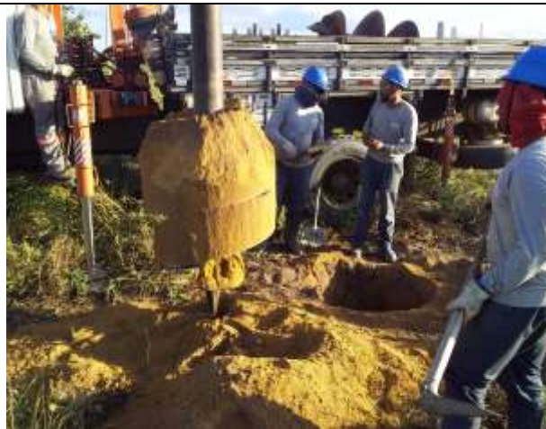
Figura 2. Escavação da Torre 60/1, cava A.
