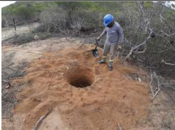
Figura 1. Escavação da torre 39/1, cava B.
