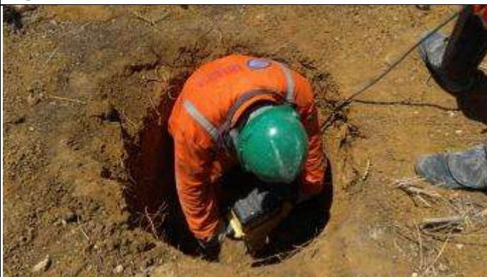
Figura 5. Abertura cava D com martetele.
