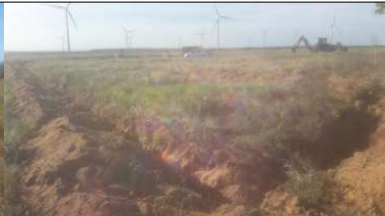
Figura 10. Atividade de escavação para contrapeso com retroescavadeira na 62-2
