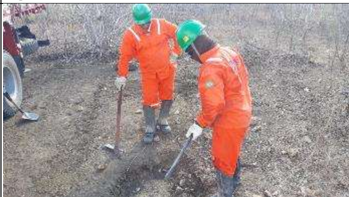
Figura 8. Abertura da cava D torre 38/1
