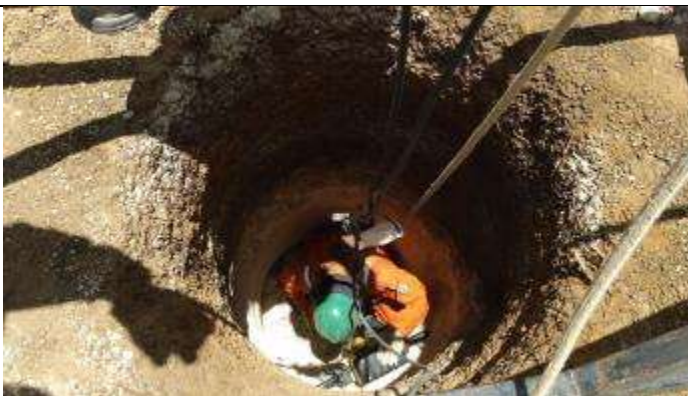
Figura 5. Abertura cava C com martetele.
