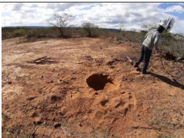
Figura 3. Escavação da torre 40/1, cava A.
