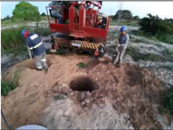
Figura 4. Supressão vegetal da Torre 55/2, cava C.
