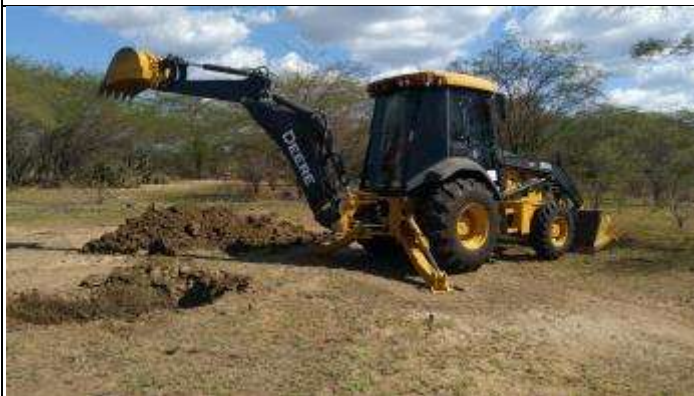
Figura 5. Abertura cava D com retroscavadeira
