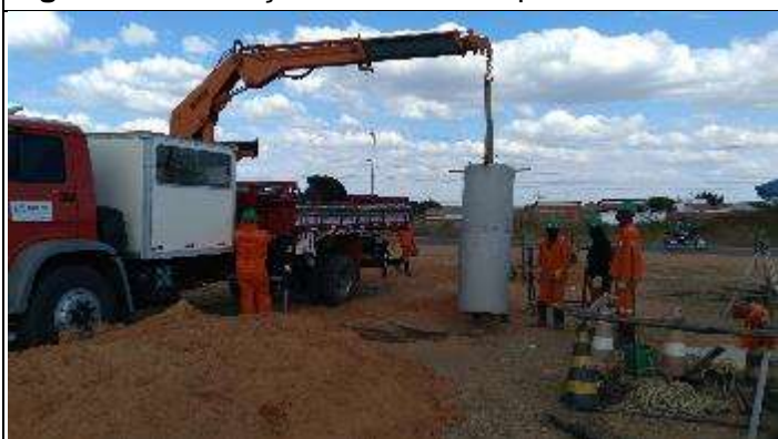
Figura 5. Colocação de saia na Cava C
