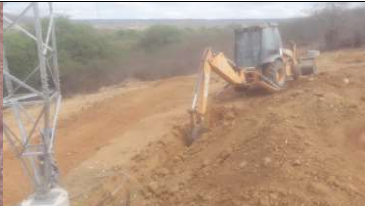
Figura 2. Escavação com retroescavadeira de vala para contrapeso na torre 45-2.
