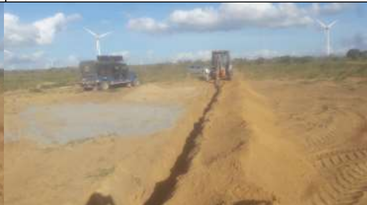
Figura 4. Atividade de escavação por retroescavadeira de vala para contrapeso com na torre 63-1.
