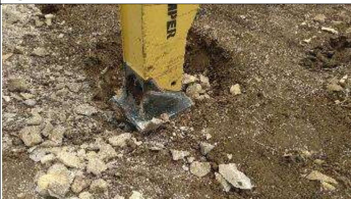
Figura 3. Abertura cava A com Picão T 38/2
