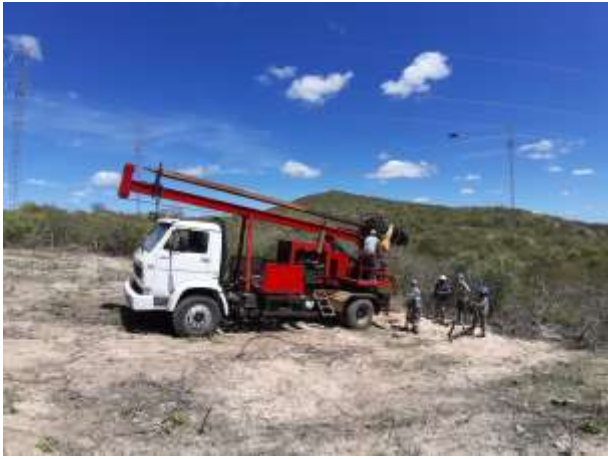
Figura 3. Escavação da torre 48/1, cava A.
