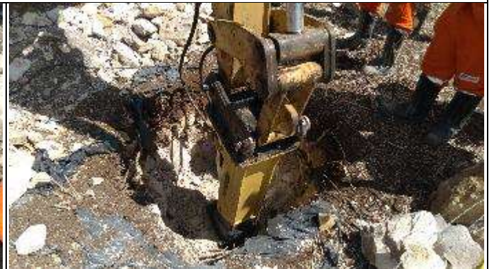
Figura 2. Reabertura cava A com picão rompedor.
