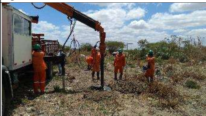
Figura 4. Abertura cava B com Perfuratriz T 4-2
