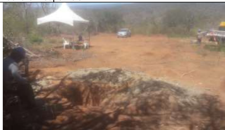
Figura 11. Cava escavada sob rocha por rompedor na torre 13-1.
