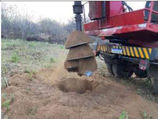
Figura 3. Escavação da torre 20/1, cava A.
