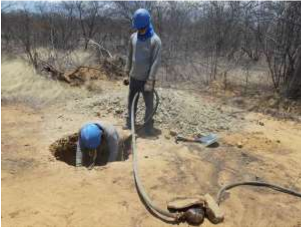
Figura 1. Escavação com rompedor da torre 88/1, cava B
