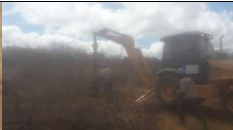
Figura 2. Escavação com perfuratriz de cava na torre 5-3.
