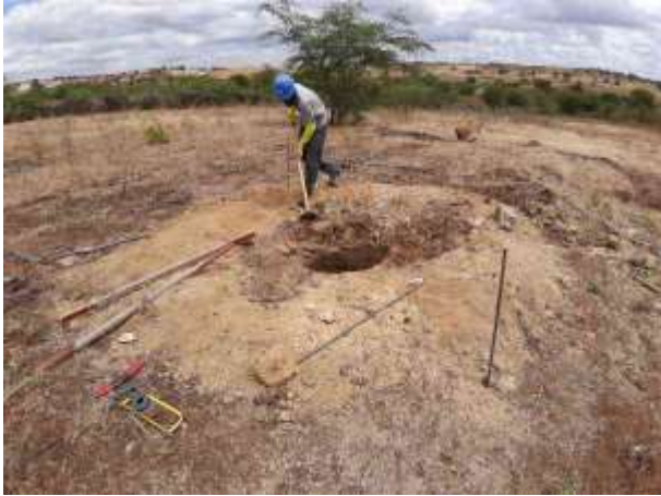
Figura 3. Escavação da torre 2/2, cava C.
