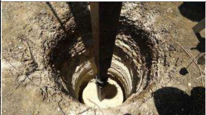
Figura 4. Finalizando cava B com perfuratriz
