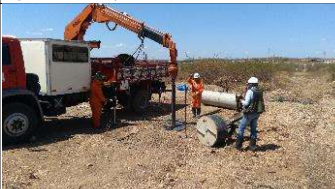
Figura 5. Escavação com perfuratriz Cava A-T 76/1
