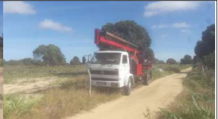
Figura 2. Caminhão perfuratriz parado na torre 54-2.
