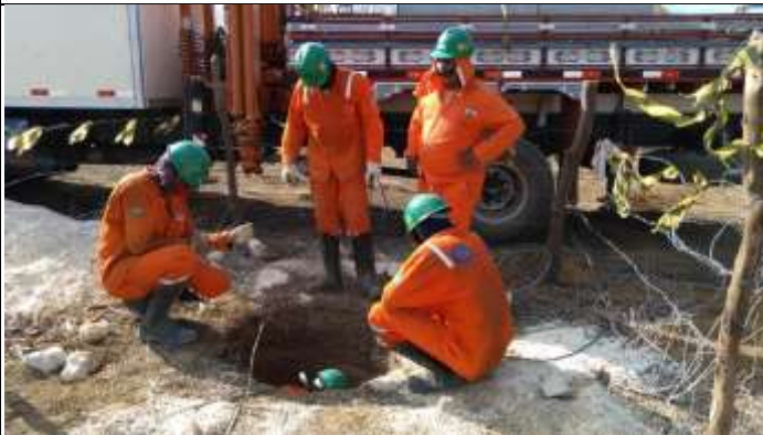
Figura 5. Reabertura com rompedor cava B T 54/3.
