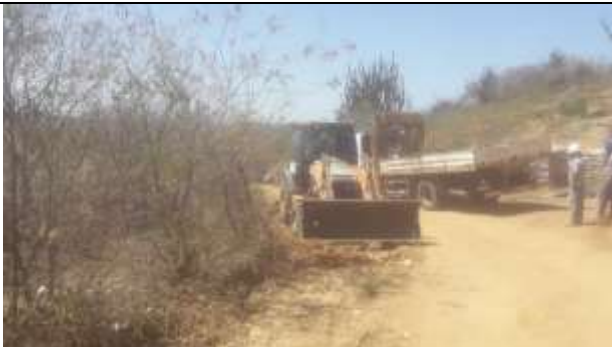
Figura 1. Máquina retroescavadeira parada em torre que ocorria concretagem.
