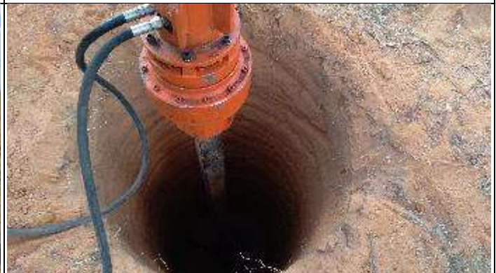
Figura 6. Finalização escavação Cava B
