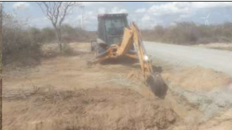
Figura 4. Atividade de escavação para contrapeso com retroescavadeira na torre 64-2.
