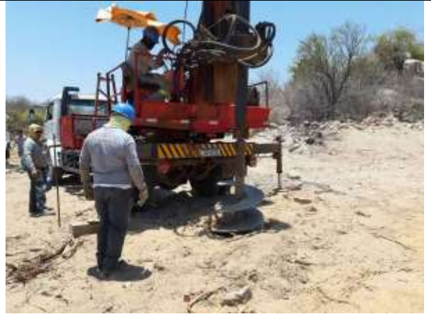
Figura 1. Torre 78/2, cava D. Figura 2. Torre 78/2 - Escavação com perfuratriz da cava Central.
