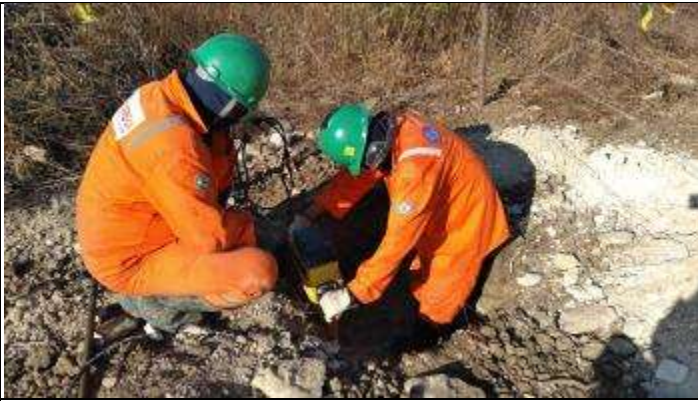
Figura 7. Abertura cava B com martelete torre 45/2
