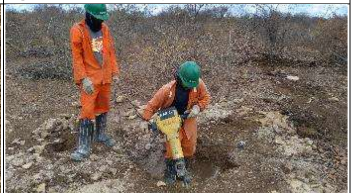
Figura 4. Abertura cava A com martetele T 38/2
