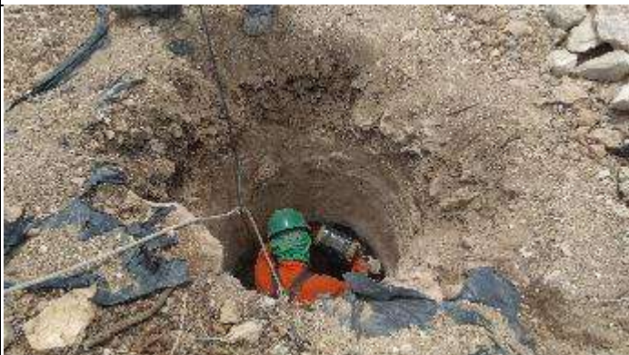
Figura 3. Reabertura Cava A com martetele.
