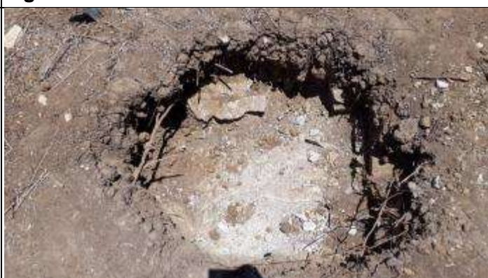
Figura 4. Abertura cava D da torre 5/2.
