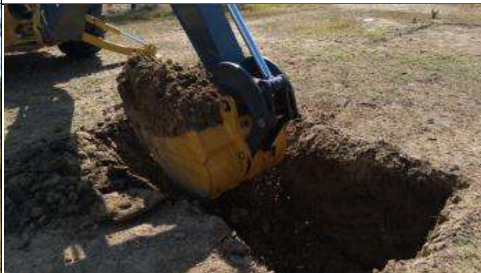
Figura 6. Abertura cava D com retroscavadeira
