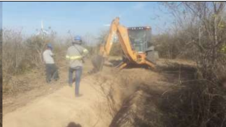
Figura 6. Atividade de escavação de vala por retroescavadeira para contrapeso na torre 64-1.
