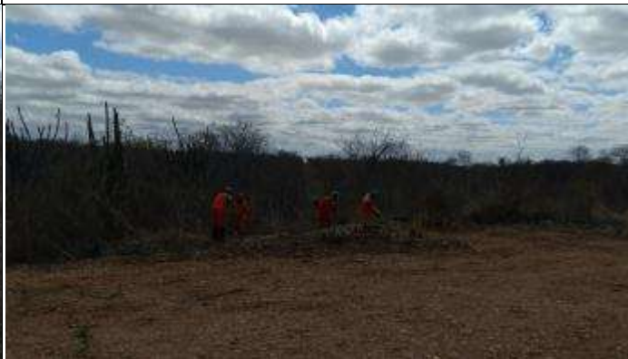
Figura 8. Supressão acesso torre 73/1
