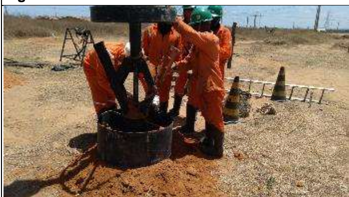
Figura 3. Escavação com broca especial Cava B
