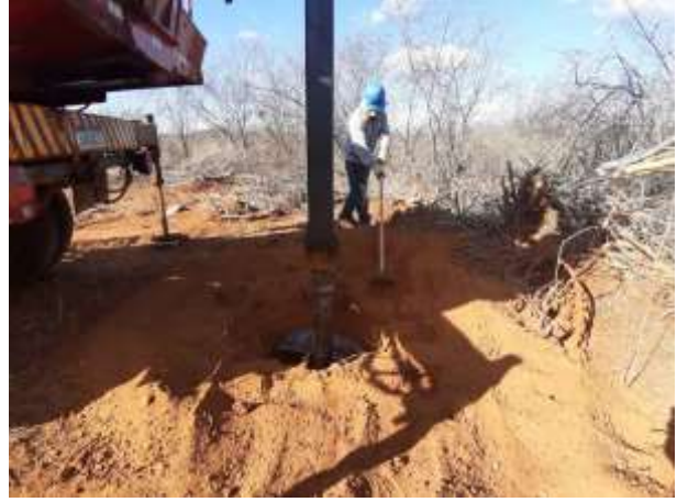
Figura 2. Atividade de limpeza da perfuração. Torre 86/2, cava A
