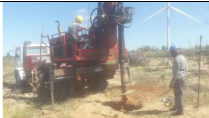
Figura 1. Acompanhamento da perfuratriz na abertura de cavas na torre 59-1.
