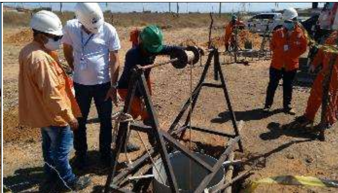
Figura 2. Escavação manual cava B
