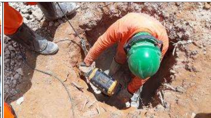
Figura 8. Reabertura da cava B torre 46/1
