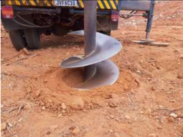
Figura 1. Torre 70/2, cava A. Figura 2. Torre 70/2 - Escavação com retroescavadeira e trado da cava A.
