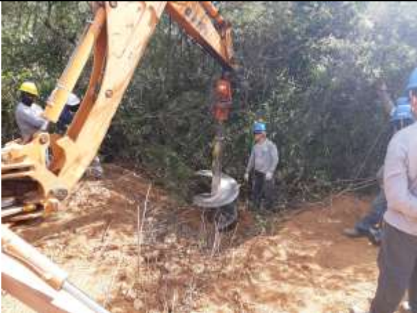
Figura 3. Escavação da Torre 45/2, cava C.
