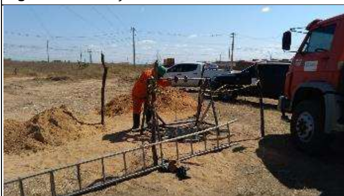
Figura 5. Escavação manual Cava D
