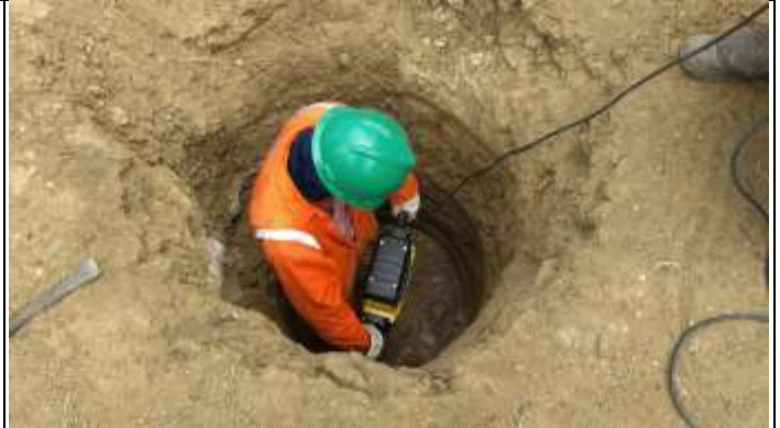
Figura 2. Finalizando a cava A com Rompedor
