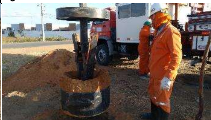
Figura 4. Escavação com broca especial Cava C
