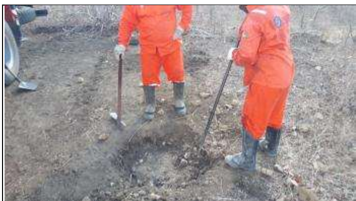
Figura 5. Abertura da cava A torre 38/1
