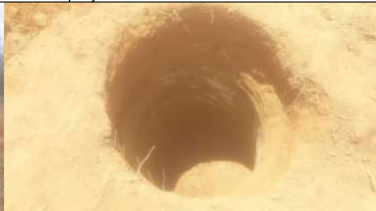
Figura 8. Vistoria de escavação por perfuratriz das cavas da praça da torre 9-1.
