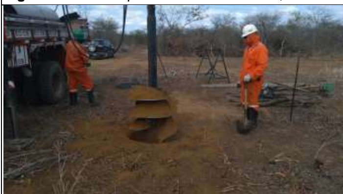
Figura 3. Abertura cava D com perfuratriz até 0,90m
