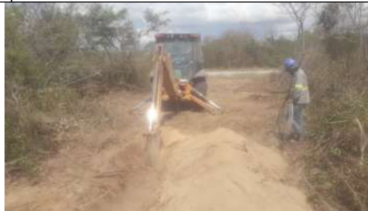
Figura 3. Atividade de escavação para contrapeso com retroescavadeira na torre 64-2.
