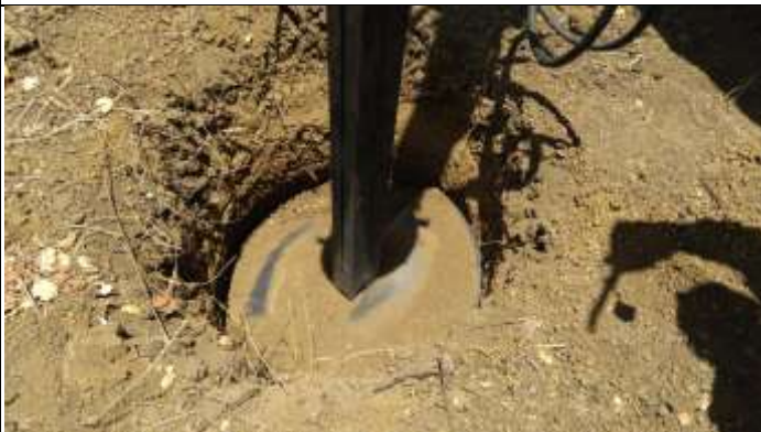
Figura 3. Reabertura da cava C com Perfuratriz.
