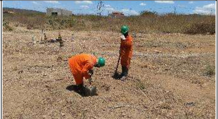
Figura 8. Escavação com pá Cava D - T 76/1
