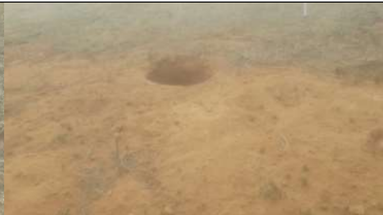
Figura 2. Vistoria das cavas da praça da torre 10-1.
