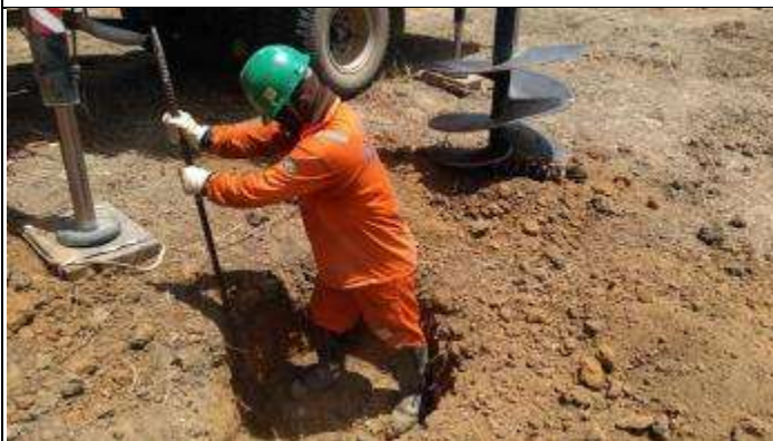
Figura 3. Abertura cava D com alavanca.
