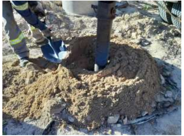
Figura 4. Supressão vegetal da Torre 55/1, cava A.
