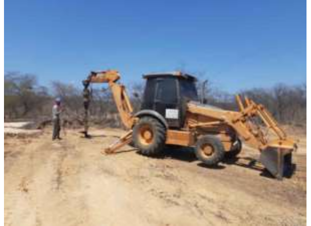
Figura 4. Torre 80/1 - Posicionamento da retro-escavadeira durante escavação da cava B.
