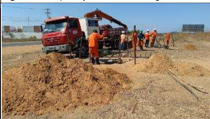
Figura 6. Escavação com auxílio de saia Cava D
