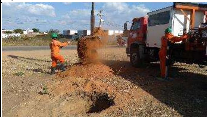
Figura 6. Escavação com perfuratriz cava A.
