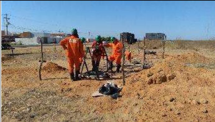
Figura 1. Finalização cava C Torre 76/1 A
