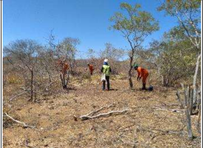
Figura 4. Supressão vegetal no acesso da torre 38/1.
