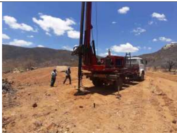
Figura 2. Torre 57/1 – escavação com perfuratriz da cava C.
