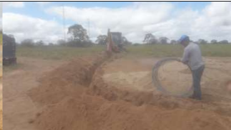
Figura 2. Atividade de escavação com retroescavadeira para abertura de valas para contrapeso na torre 63-1.
