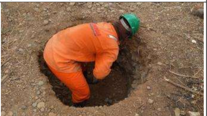
Figura 6. Escavação com pá cava B
