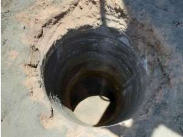
Figura 1. Torre 78/2, cava D. Figura 2. Torre 78/2 - Escavação com perfuratriz da cava Central.
