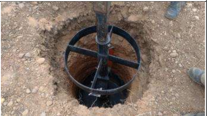
Figura 4. Escavação com broca especial cava C
