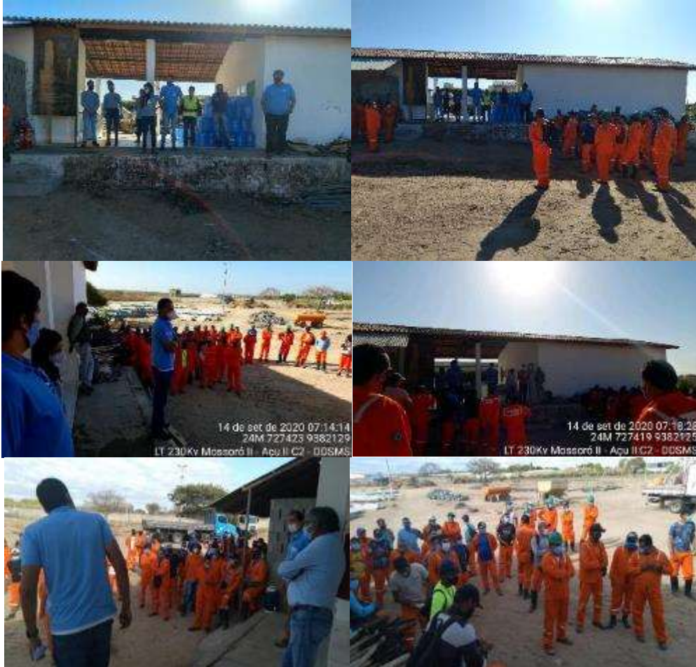
Figura 18. DDSs com funcionários da supressão vegetal e escavação.
