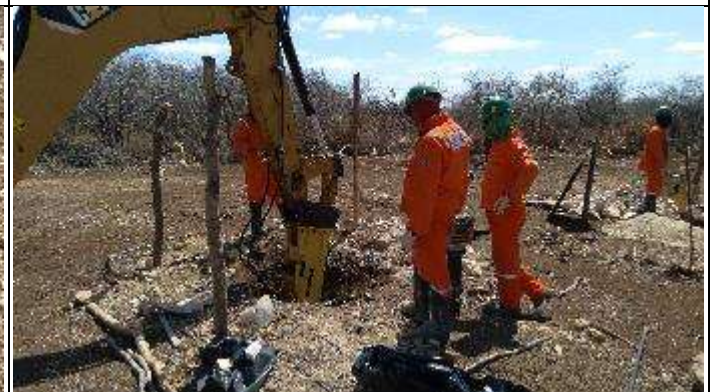
Figura 4. Reabertura Cava B com picão T 54/4.
