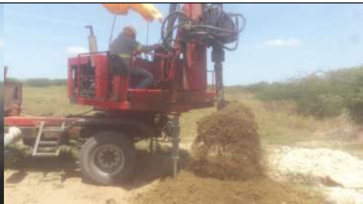
Figura 4. Caminhão-perfuratriz escavando cava na torre 24-1.
