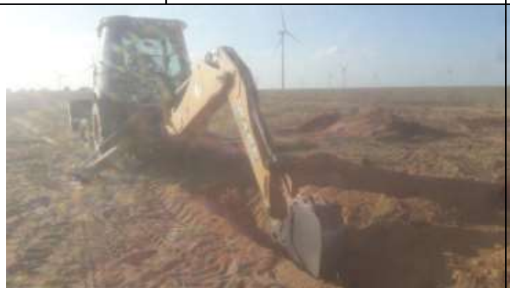
Figura 5. Atividade de escavação com retroescavadeira de vala para contrapeso na torre 62-1.
