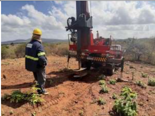
Figura 1. Torre 19/1, cava A.
