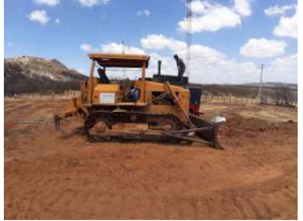
Figura 2. Torre 73/1 – trator quebrado.
