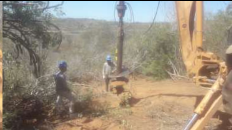
Figura 6. Retroescavadeira em atividade de escavação na torre 11-1.
