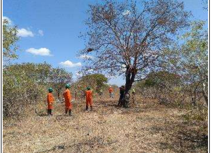
Figura 2. Supressão vegetal com moto serra no acesso da torre 38/2.
