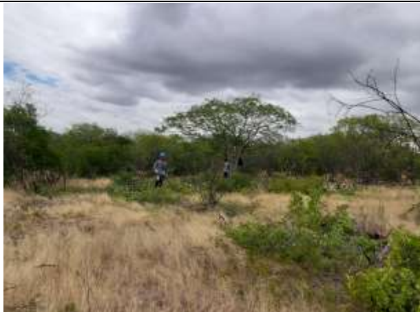
Figura 1. Supressão vegetal da torre 77/1 cava A
