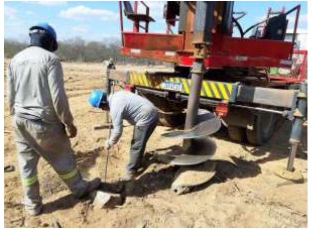
Figura 4. Torre 72/2 - cava B.
