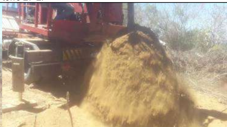
Figura 4. Caminhão-perfuratriz escavando cava na torre 27-2.
