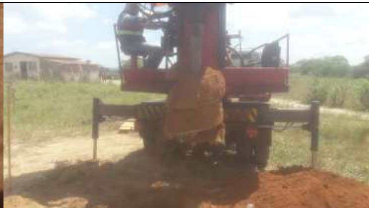
Figura 2. Atividade de escavação por caminhão-perfuratriz de cava na torre 25-2.
