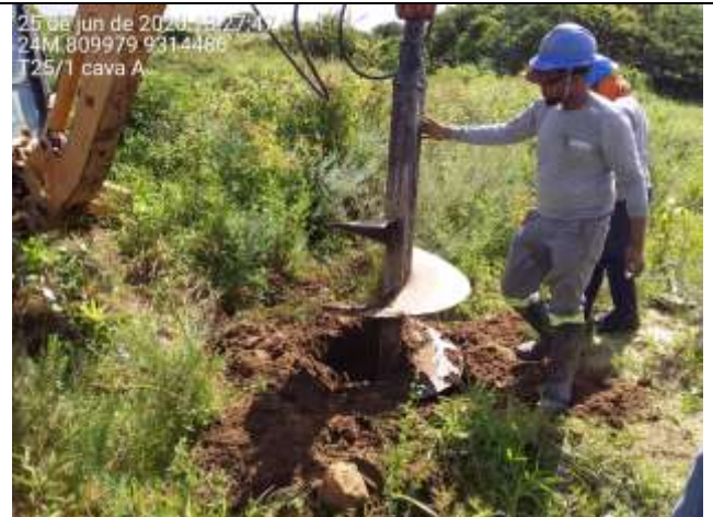
Figura 2. Escavação da Torre 25/1, cava A
