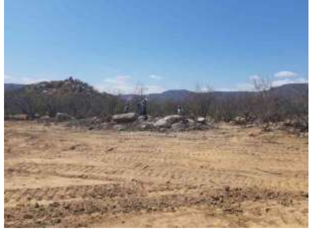
Figura 2. Torre 71/3 – rochas a serem retiradas na praça da torre.
