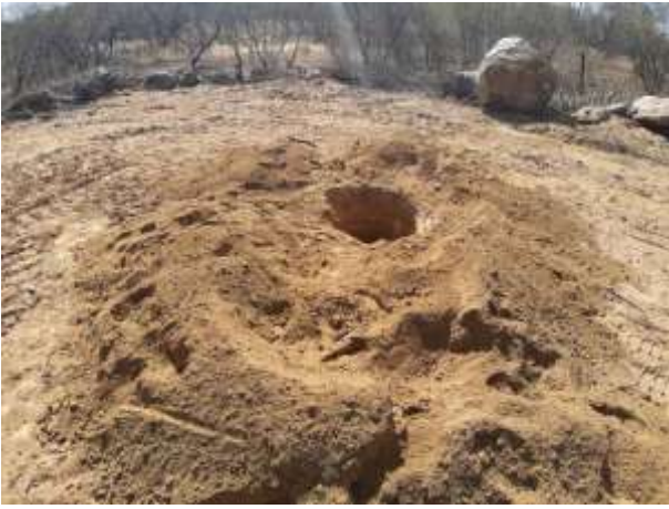
Figura 3. Torre 72/2-finalização da escavação da cava C.
