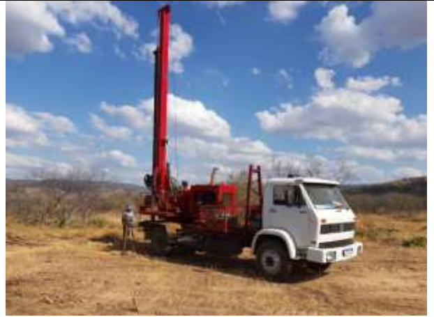
Figura 6. Torre 74/2 - Posicionamento da perfuratriz durante escavação da cava D.
