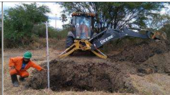
Figura 2. Finalização da cava D Torre 5/1.
