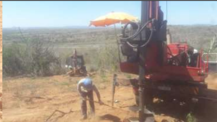
Figura 2. Caminhão perfuratriz em atividade de escavação na torre 11-1.
