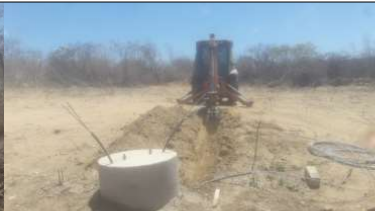
Figura 2. Retroexcavadora realizando a abertura de valas para o contrapeso na torre 46-1.
