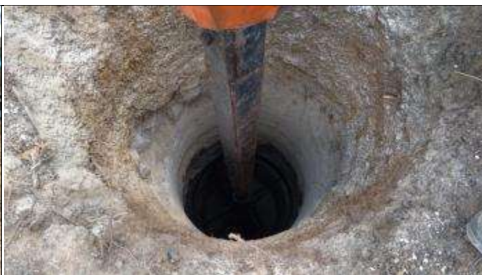
Figura 8. Finalizando cava A com broca especial
