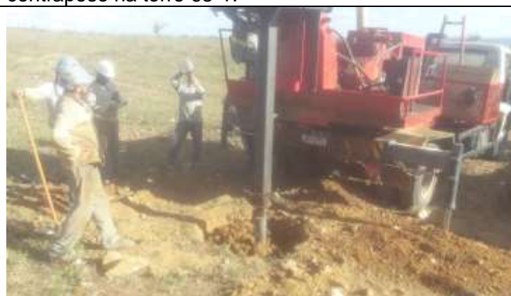
Figura 3. Atividade de escavação por caminhão-perfuratriz para cavas nas torres 30-2.
