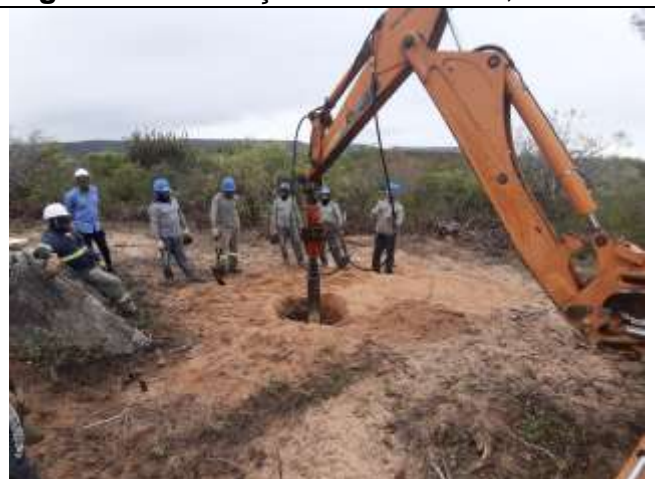
Figura 2. Escavação da Torre 50/1, cava D.
