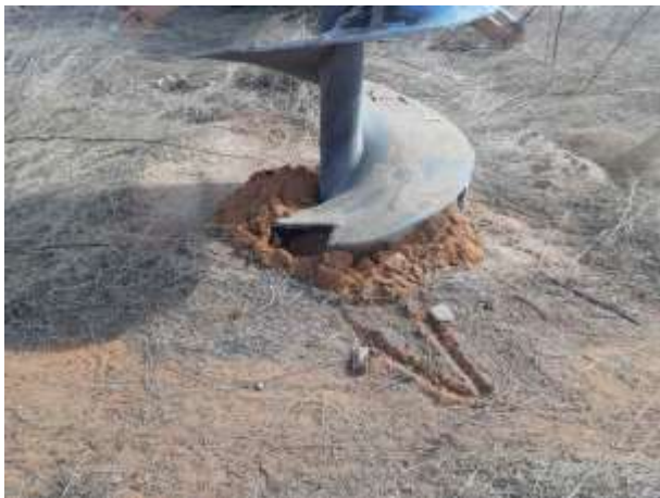
Figura 1. Escavação com retroescavadeira da torre 85/2, cava D
