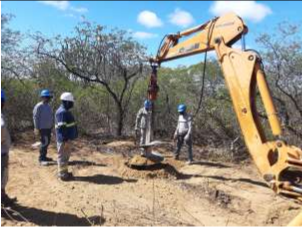
Figura 1. Escavação da torre 47/1 cava A
