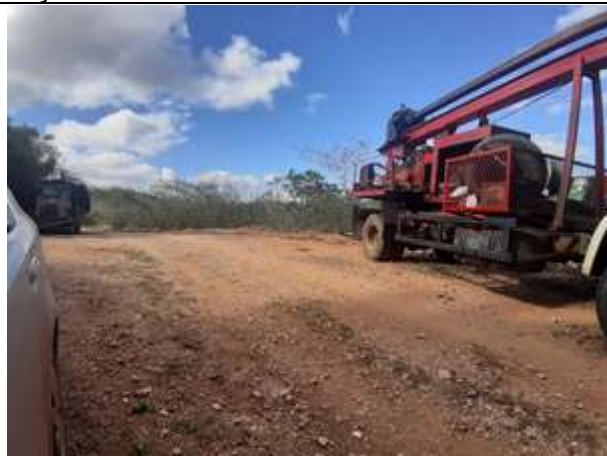
Figura 2. Retroescavadeira aguardando na praça da torre 36/1.
