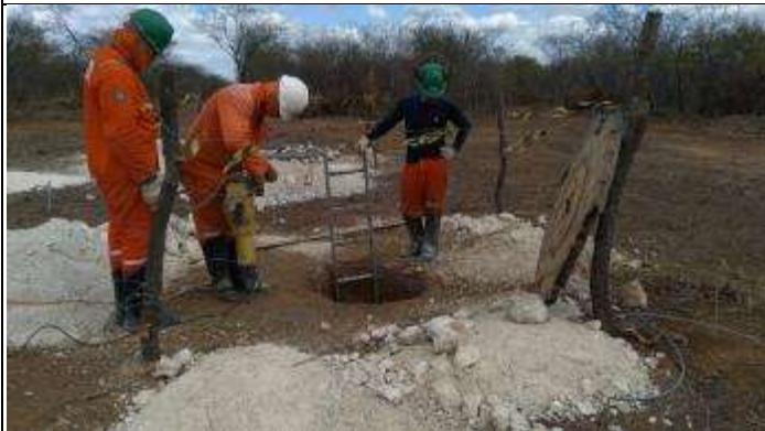
Figura 1. Reabertura da cava D com martelete.
