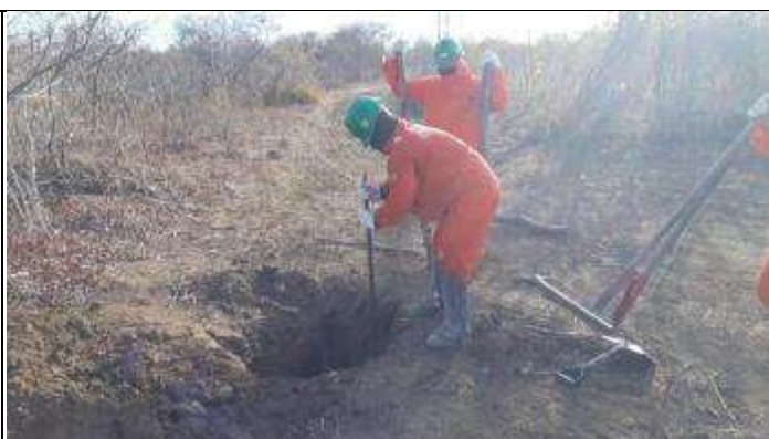
Figura 6. Abertura da cava B torre 38/1
