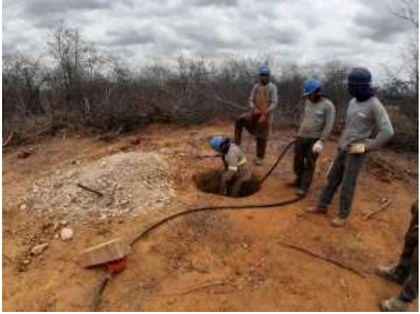
Figura 1. Escavação com rompedor da torre 88/1, cava D
