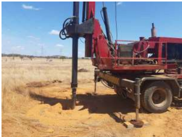
Figura 1. Escavação com perfuratriz da torre 85/2, cava C
