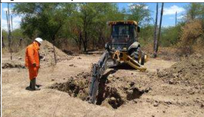
Figura 4. Abertura cava D da torre 5/2.
