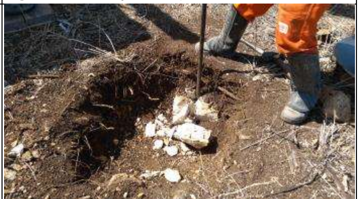
Figura 6. Escavação finalizada a 30cm T 54/4
