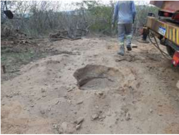
Figura 3. Escavação da torre 41/2, cava C.
