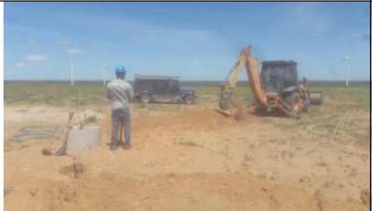
Figura 3. Atividade de escavação para contrapeso com retroescavadeira na torre 62-2.
