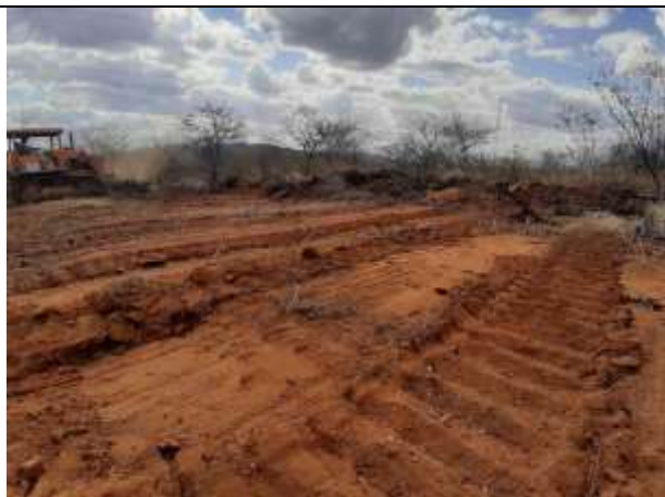
Figura 5. Torre 75/1-limpeza de praça
