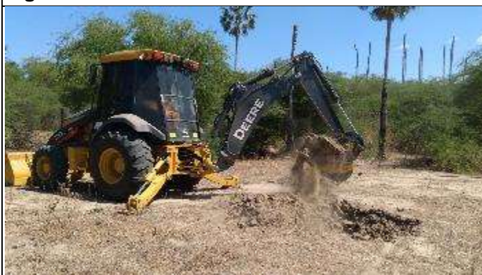
Figura 3. Abertura da cava A da torre 5/2.
