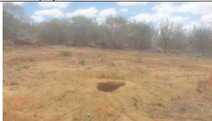
Figura 7. Vistoria de escavação por perfuratriz das cavas da praça da torre 9-1.
