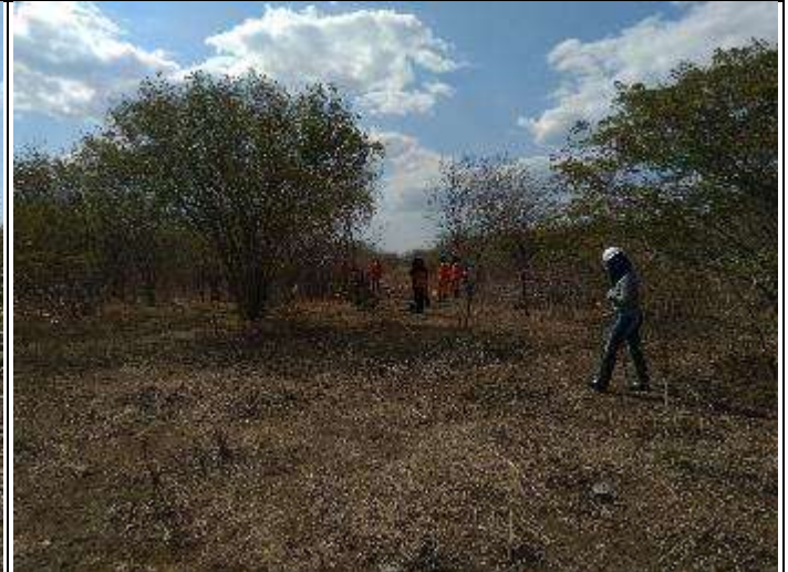
Figura 2. Supressão vegetal com moto serra no acesso da torre 38/1.
