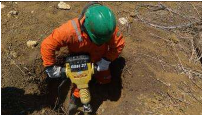
Figura 7. Reabertura cava A com martetele
