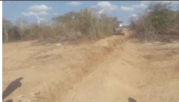
Figura 5. Atividade de escavação para contrapeso com retroescavadeira na torre 64-2.
