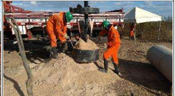
Figura 12. Escavação com broca especial Cava A
