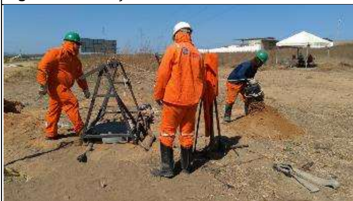
Figura 3. Escavação manual com auxílio de saia
