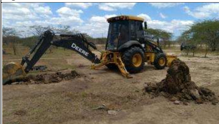
Figura 3. Início de abertura da cava C da torre 7/1.
