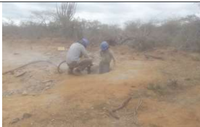
Figura 2. Atividade de escavação com martelete em cava da torre 40-1.
