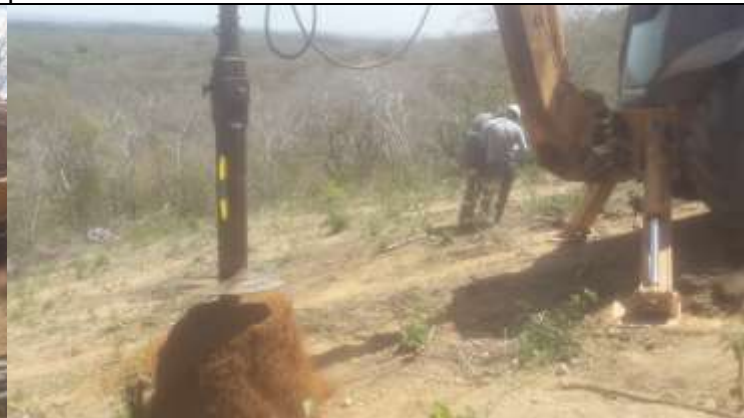
Figura 4. Atividade de escavação com retroescavadeira-perfuratriz de cava na torre 32-1.
