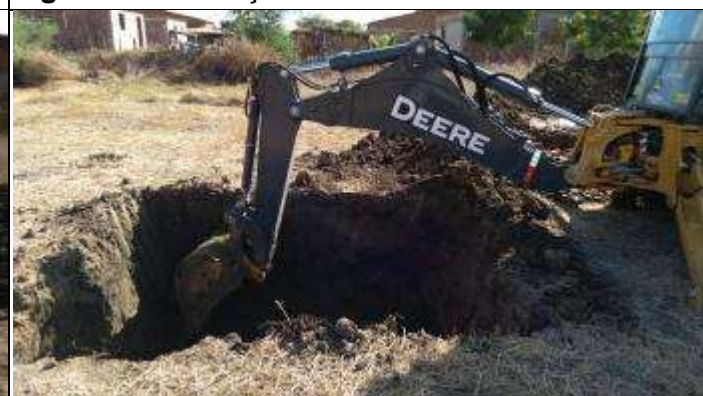
Figura 4. Abertura cava A da torre 5/1.
