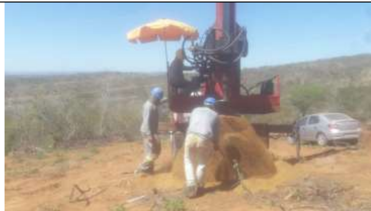
Figura 3. Caminhão perfuratriz em atividade de escavação na torre 11-1.
