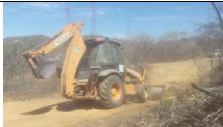
Figura 1. Retroexcavadora fazendo manutenção nos acessos para acesso de caminhão guincho.
