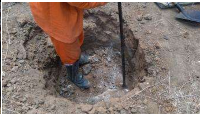
Figura 6. Reabertura cava B com alavanca
