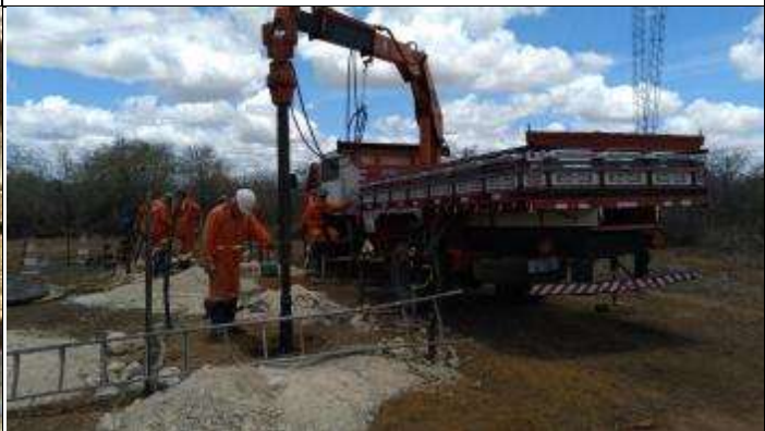
Figura 6. Reabertura cava C com perfuratriz
