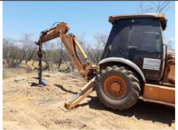
Figura 2. Torre 76/2 - Escavação com retroescavadeira e trado da cava A.
