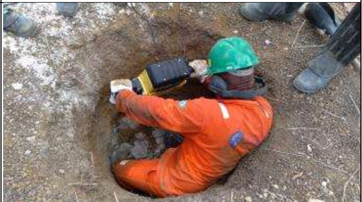
Figura 8. Reabertura cava A com martetele 1,00m .
