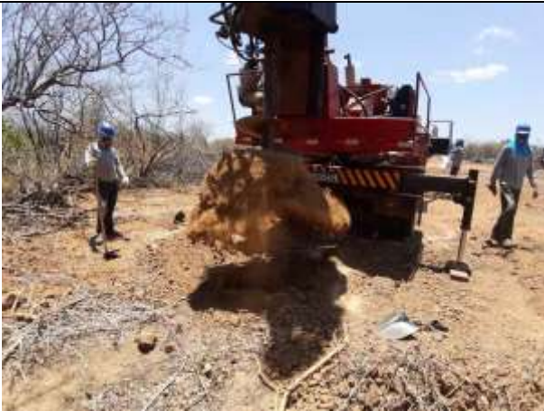
Figura 1. Torre 76/2, cava B.
