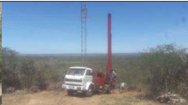
Figura 2. Caminhão-perfuratriz escavando cava na torre 27-2.
