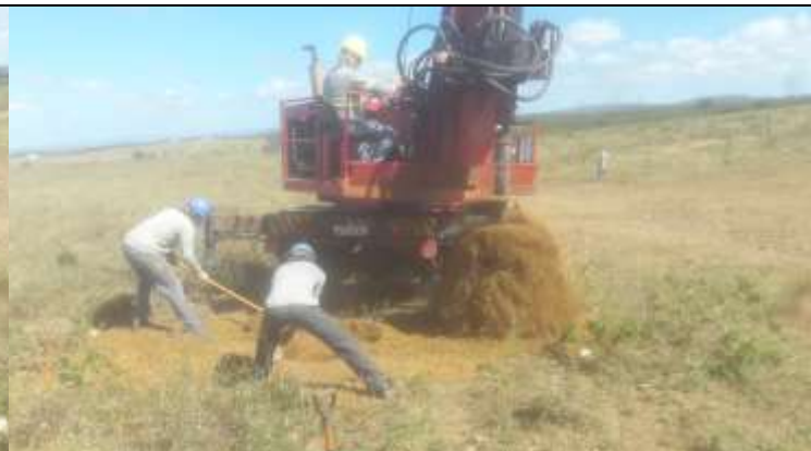
Figura 2. Atividade de escavações por caminhão-perfuratriz para cavas nas torres 30-2.
