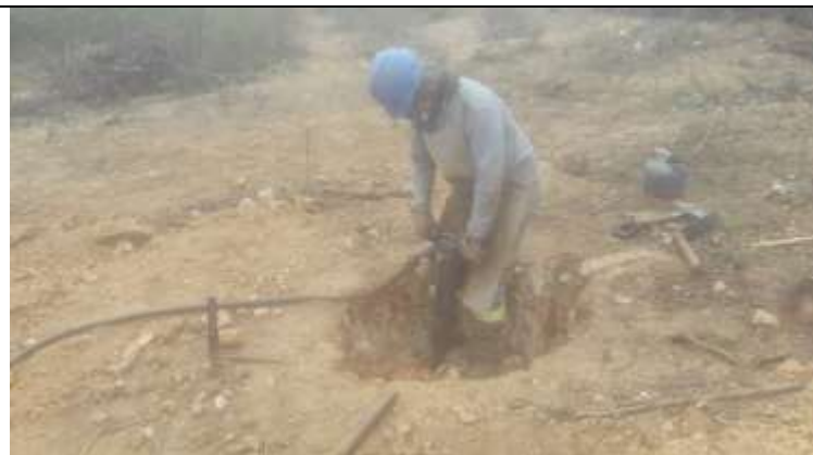
Figura 3. Atividade de escavação com martelete em cava da torre 36-2.
