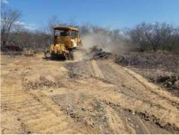
Figura 1. Torre 71/3 limpeza de praça da torre.
