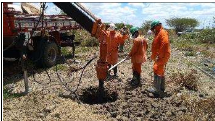
Figura 5. Abertura cava B chegando a 2,20m T 4-2
