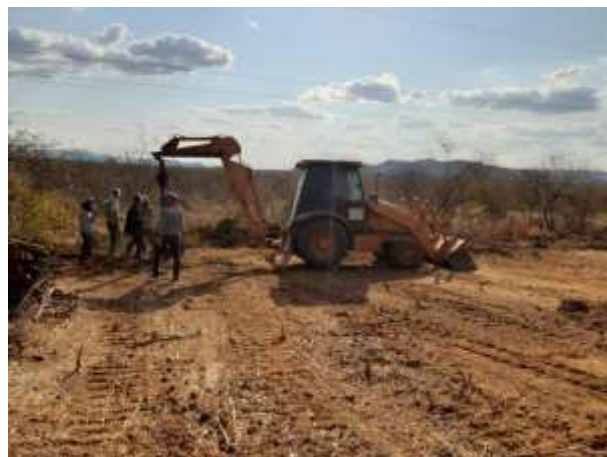
Figura 4. Torre 75/1 - Posicionamento da retroescavadeira durante escavação da cava B.
