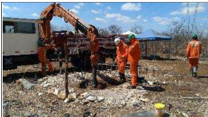
Figura 7. Reabertura cava D com perfuratriz.
