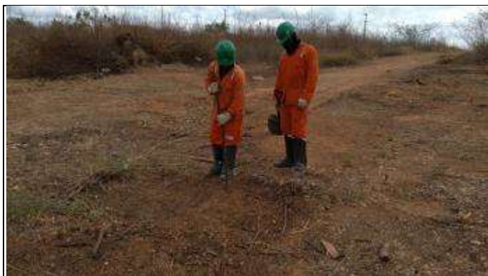
Figura 9. Abertura da cava C com alavanca
