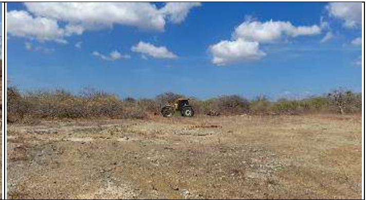
Figura 10. Limpeza de faixa Torre 37/2
