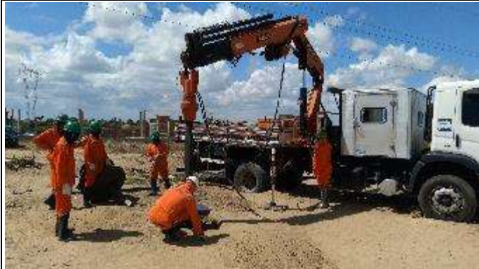
Figura 3. Abertura da cava C na Torre 76-2.
