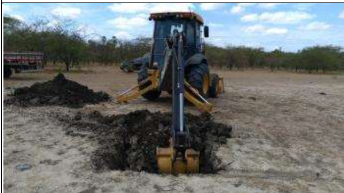
Figura 1. Abertura da cava D da Torre 6/2.
