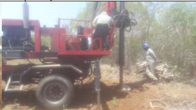
Figura 4. Caminhão-perfuratriz escavando cava na torre 13-2.
