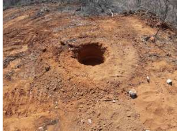
Figura 2. escavação finalizada. Torre 86/2, cava D
