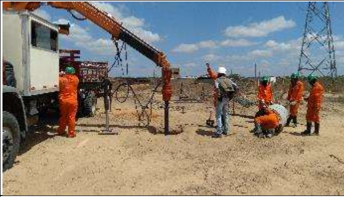
Figura 1. Abertura da cava B na Torre 76-2.
