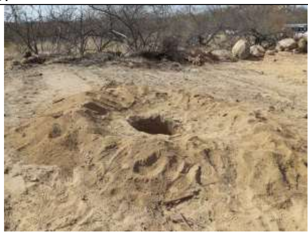
Figura 3. Escavação da torre 72/3, cava C.
