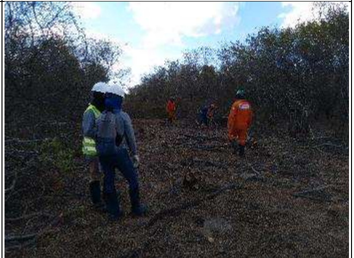
Figura 4. Supressão vegetal no acesso da torre 39/1.
