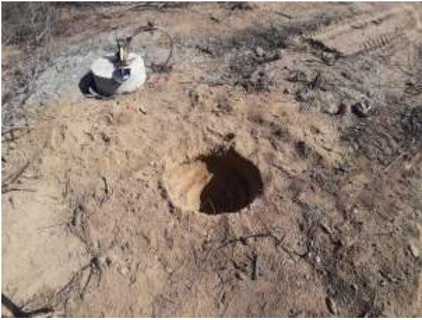
Figura 3. Escavação da torre 46/1, cava A.
