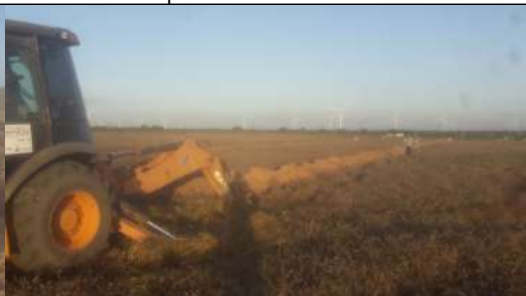
Figura 6. Atividade de escavação com retroescavadeira de vala para contrapeso na torre 62-1.
