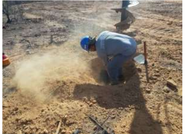
Figura 2. Torre 83/1, cava A
