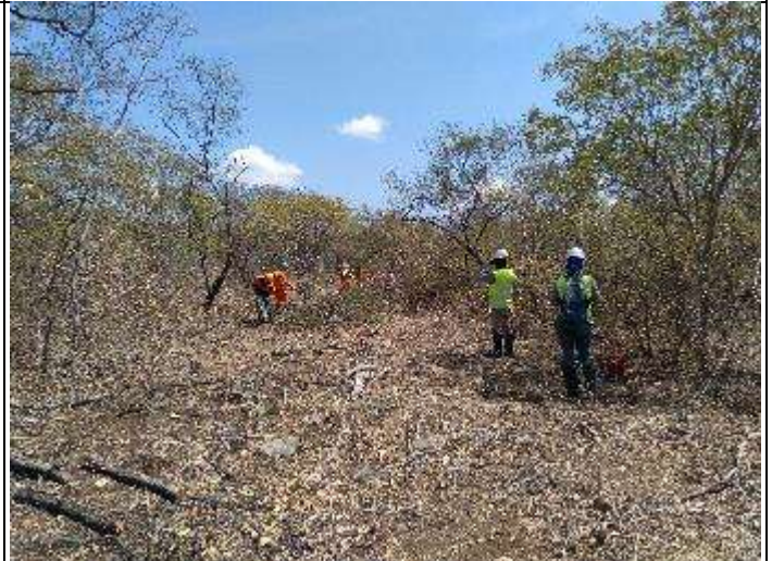
Figura 6. Supressão vegetal com moto serra no acesso da torre 38/1.
