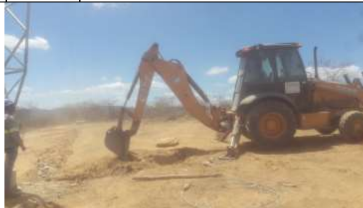
Figura 5. Escavação com retroescavadeira de vala para contrapeso na torre 40-1.
