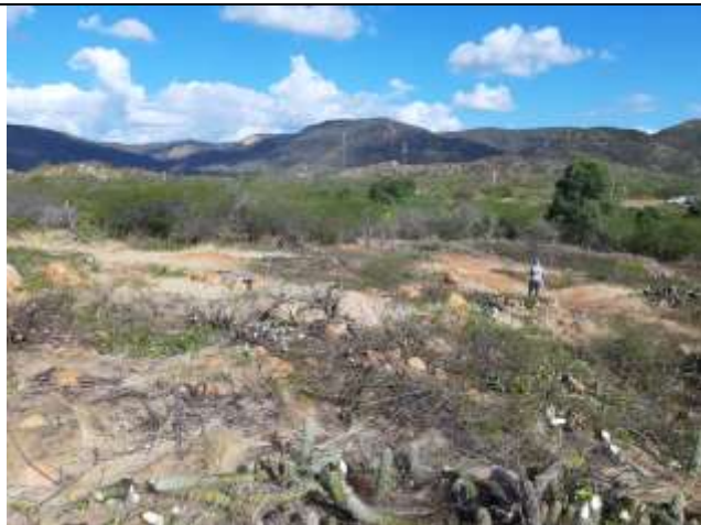
Figura 2. Supressão vegetal finalizada na Torre 70/1.
