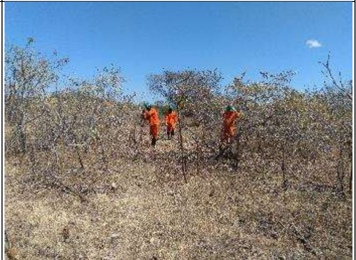
Figura 6. Supressão vegetal no início da torre 38/2.
