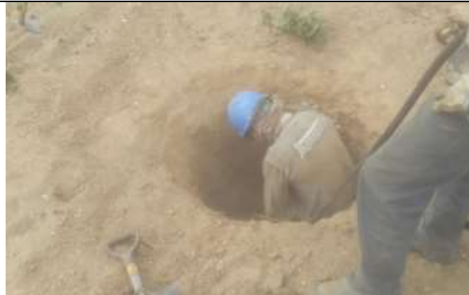
Figura 2. Atividade de escavação com martetele em cava da torre 39-2.
