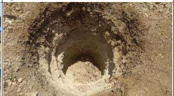
Figura 6. Finalizando cava C.
