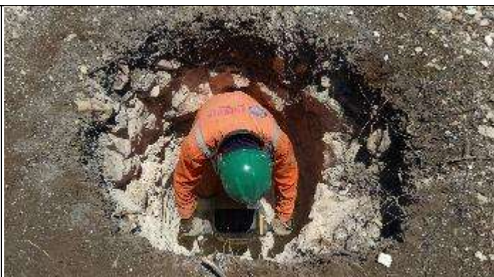
Figura 8. Reabertura cava D com martelete.
