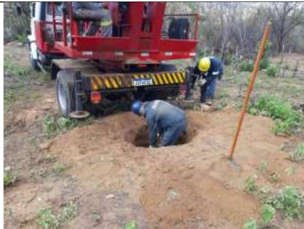
Figura 2. Torre 19/1 – escavação manual, cava B.
