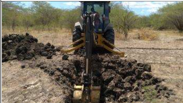
Figura 1. Abertura da cava C da Torre 6/1.
