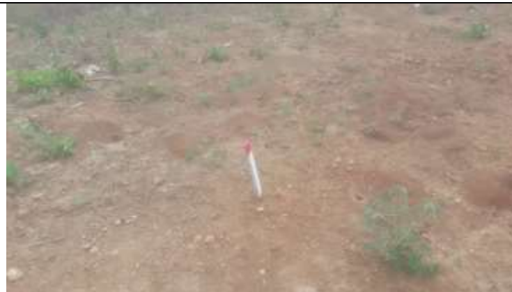
Figura 1. Ponto de marcação de cava na praça da torre 53-1.
