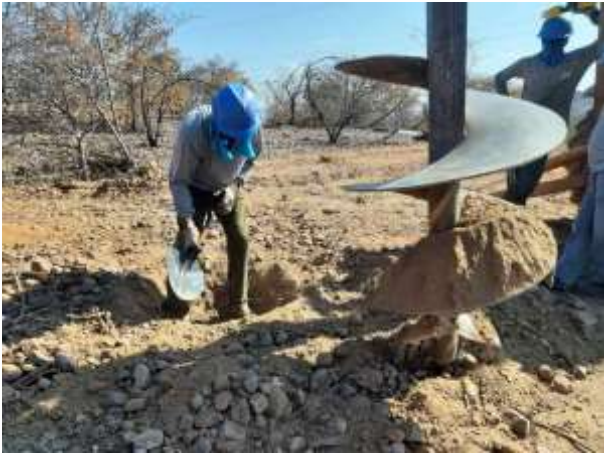
Figura 3. Escavação da torre 77/1, cava A.
