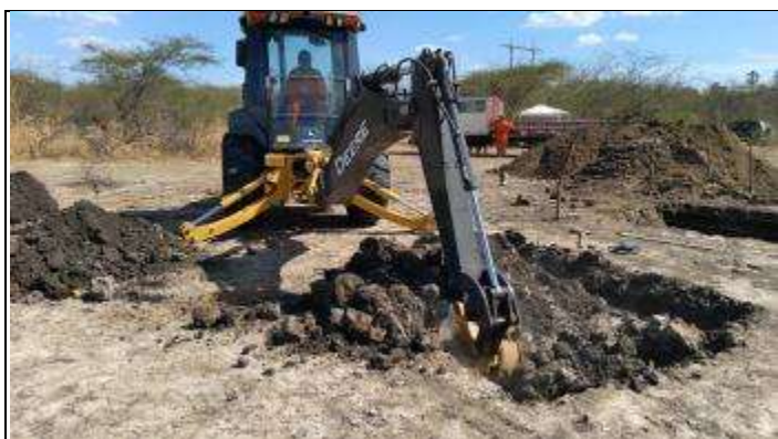
Figura 5. Inicio abertura cava C torre 6/2
