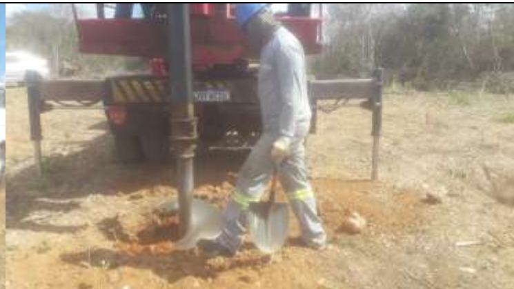
Figura 2. Atividade de escavação por caminhão-perfuratriz de cava na torre 29-1.
