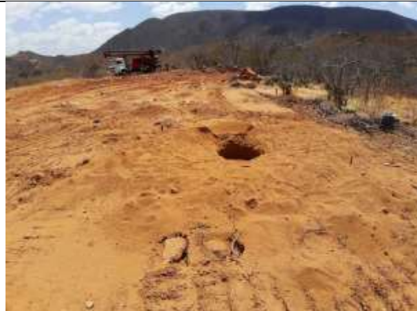
Figura 2. Torre 67/2 - cava A.
