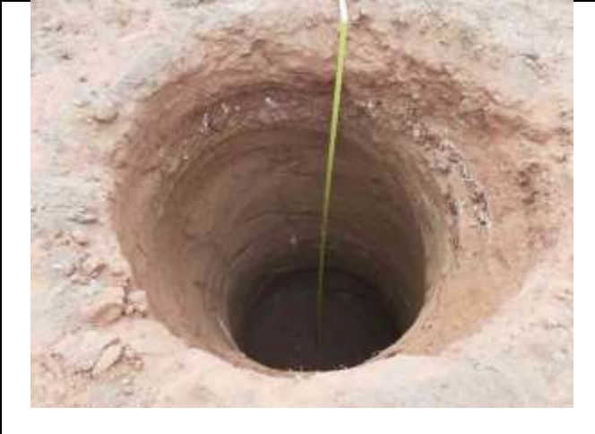
Figura 2. Torre 2/1 – finalização da escavação da cava D.
