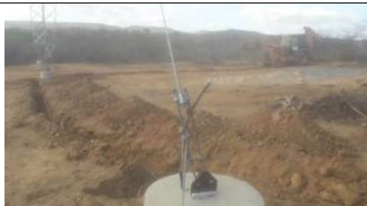
Figura 5. Abertura de vala por retroescavadeira para contrapeso na torre 44-1.
