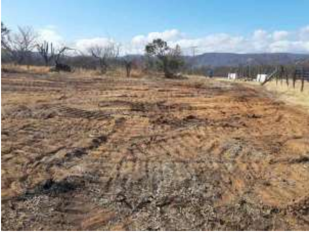
Figura 1. Torre 73/1 limpeza de praça da torre.
