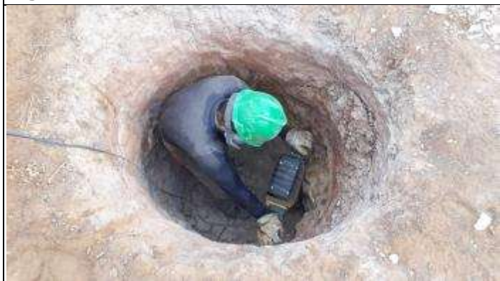
Figura 7. Reabertura cava B torre 46/1
