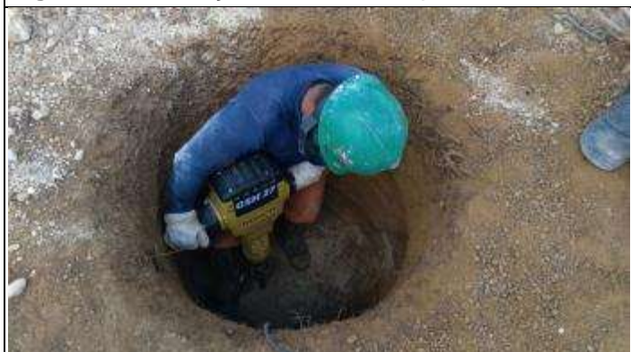
Figura 9. Reabertura com martetele cava C
