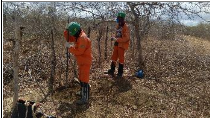
Figura 7. Abertura cava D com alavanca T 33/1
