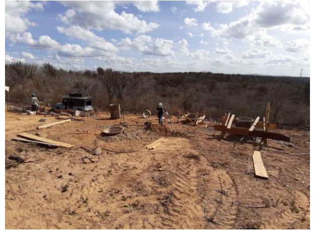
Figura 6. Torre 33/1, escavação com rompedor, rochas em baixa profundidade.
