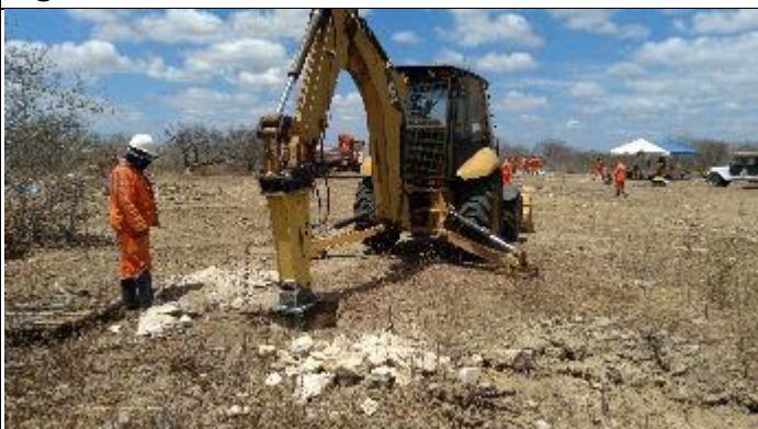
Figura 3. Abertura cava C com picão T 37/2
