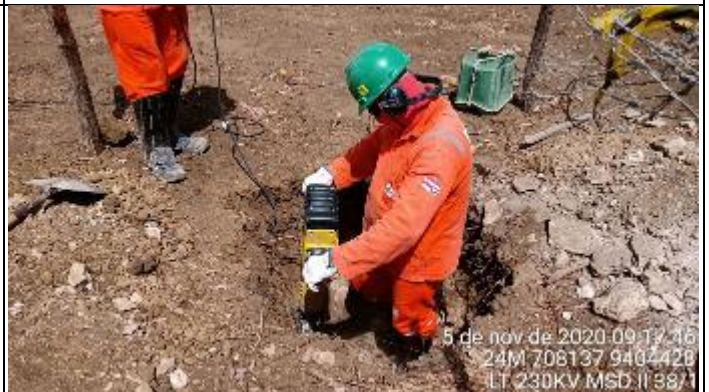
Figura 8. Reabertura cava A com martetele T 38/1
