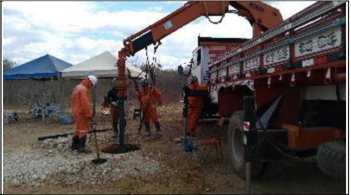
Figura 6. Abertura cava A com perfuratriz T 16/2
