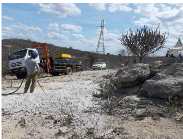
Figura 3. Torre 39/3, cava A.
