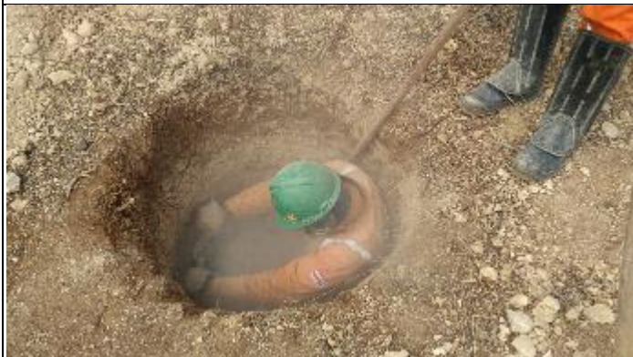
Figura 9. Abertura cava C com martetele T 16/4
