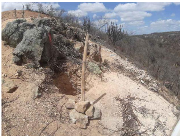
Figura 1. Torre 36/1, cava A.
