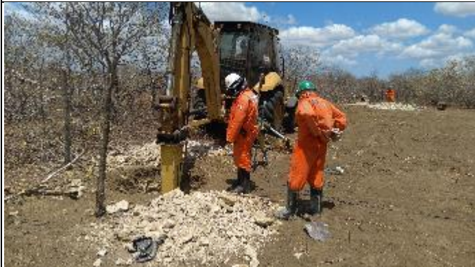
Figura 7. Reabertura cava A com picão T 38/1
