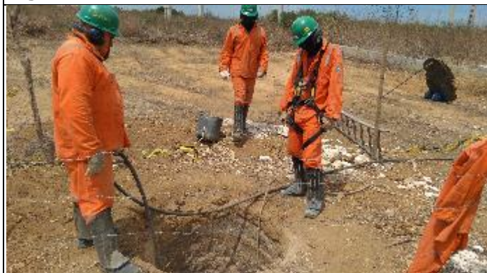
Figura 5. Reabertura cava D com martelete T 1/2
