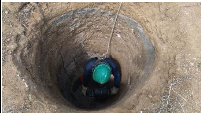
Figura 6. Reabertura cava D com martelete T 1/2
