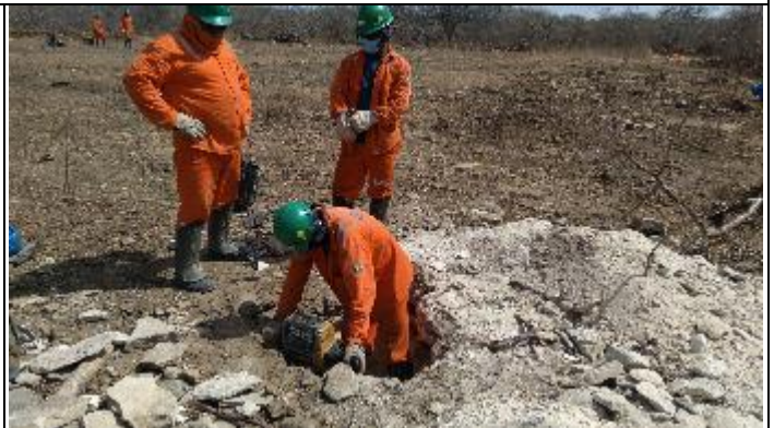
Figura 2. Abertura com Martelete T 37/2
