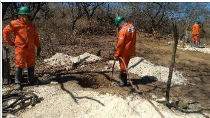
Figura 3. Reabertura Cava A com rompedor T 16/3
