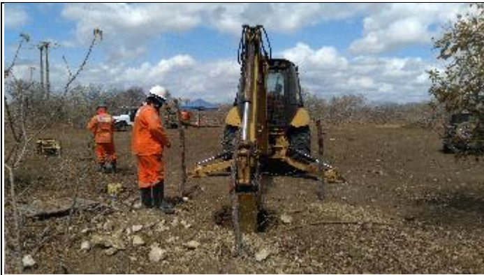
Figura 3. Reabertura cava C com picão T 38/1
