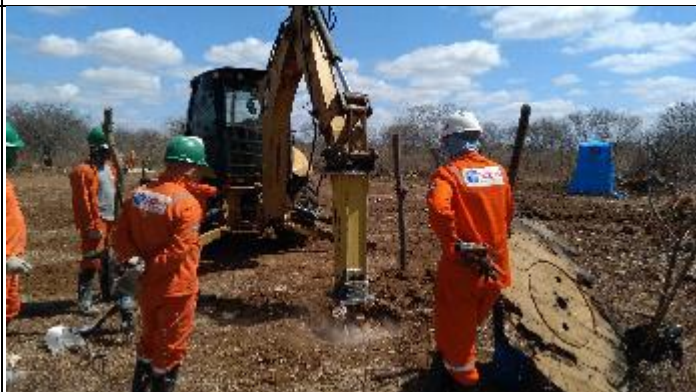
Figura 8. Reabertura cava D com Picão T 37/1
