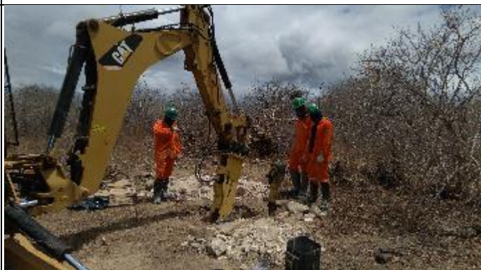
Figura 4. Reabertura cava C com Picão T 37/2
