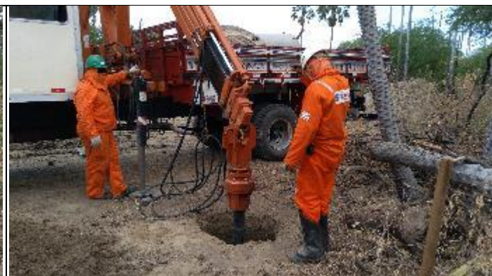
Figura 12. Abertura cava D com perfuratriz T 5/2
