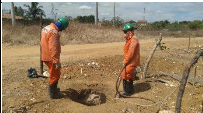
Figura 4. Reabertura Cava C com martelete T 1/2
