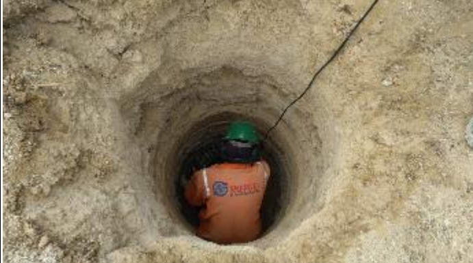
Figura 7. Reabertura cava D com martetele T 16/2
