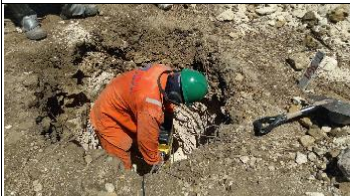
Figura 1. Reabertura com martetele Central T 36-1
