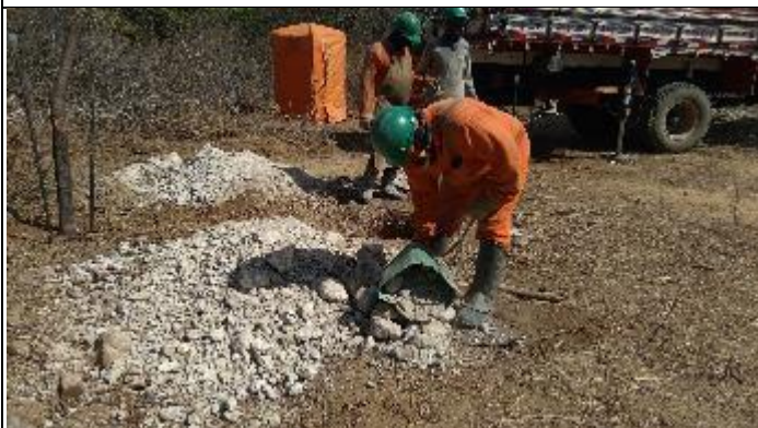
Figura 11. Retirada de rochas cava B T 15-2
