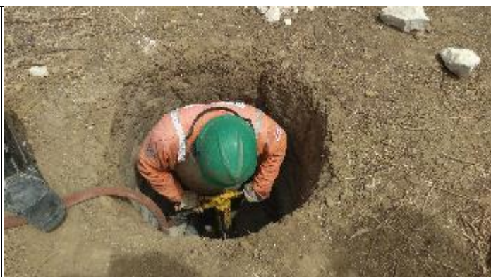
Figura 2. Reabertura cava D com martetele T 16/3
