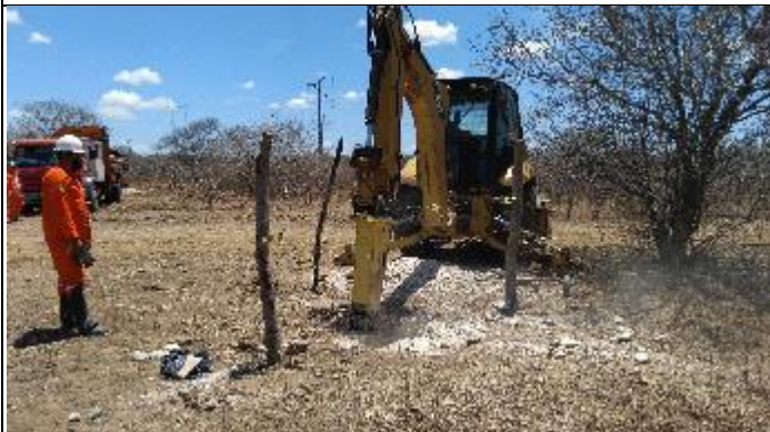
Figura 9. Reabertura cava "A" com picão T 36/1
