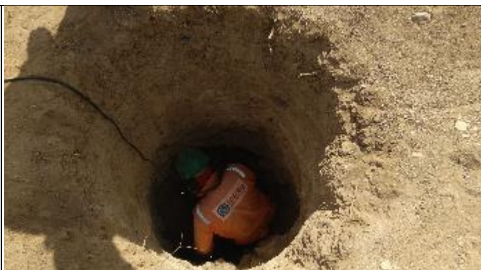
Figura 8. Final cava D 2,94m com martetele T 15/2
