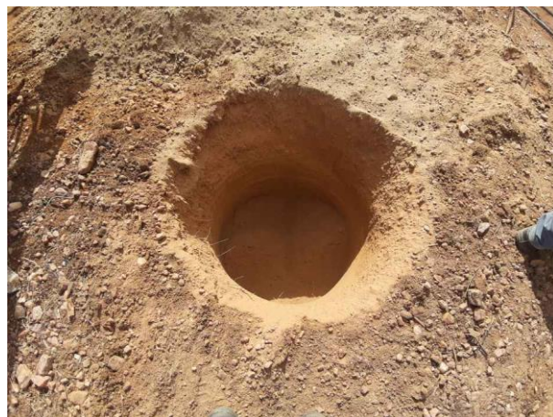
Figura 4. Torre 95/2, cava B.
