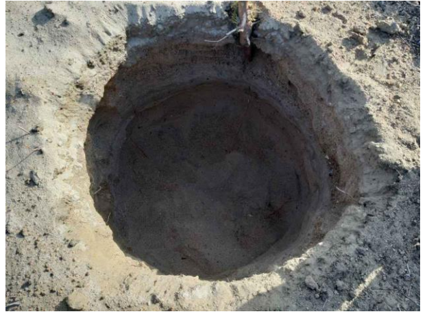
Figura 8. Torre 126/1, cava B
