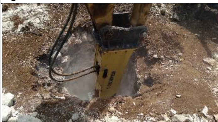
Figura 7. Reabertura cava D com picão T 37/1
