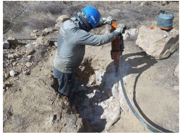
Figura 6. Torre 93/3, cava B.
