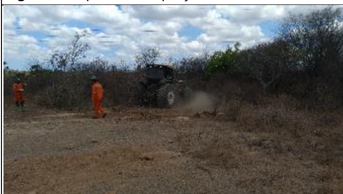
Figura 3. Supressão na praça da torre 15/2
