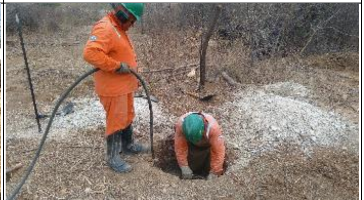
Figura 4. Abertura Cava B com martetele T 15/2
