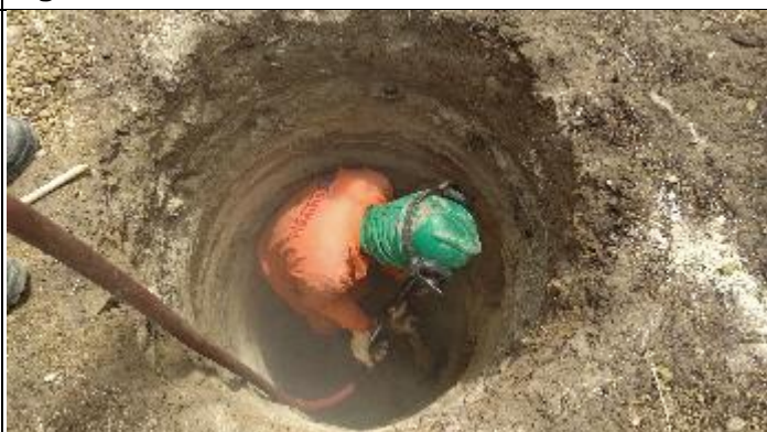
Figura 4. Reabertura Cava A com martetele T 16/3
