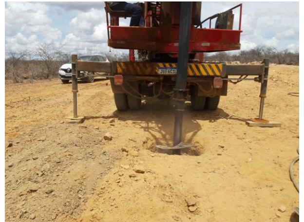
Figura 4. Torre 94/1, cava C.
