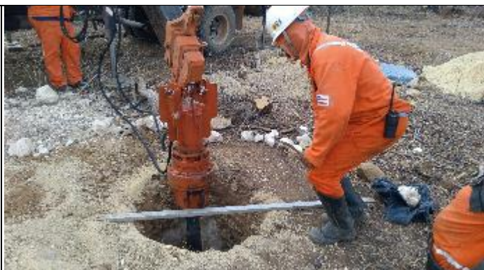
Figura 10. Finalização cava D com perfuratriz T 16/1
