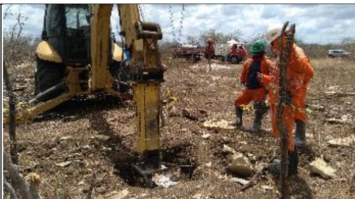
Figura 6. Reabertura cava B com picão T 34/2
