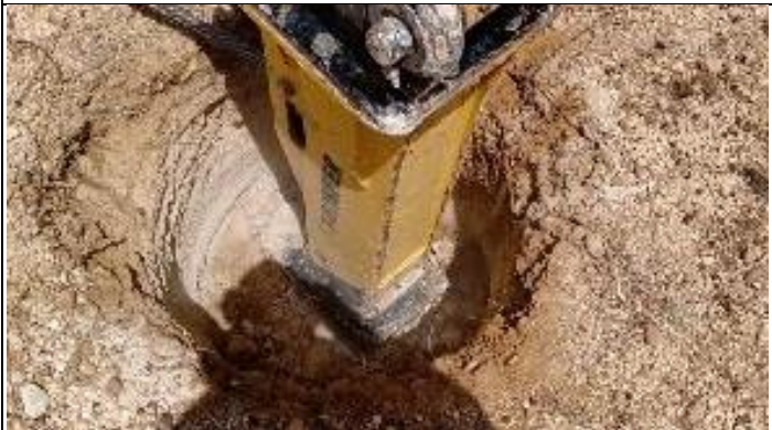
Figura 5. Abertura cava C com picão T 16/2
