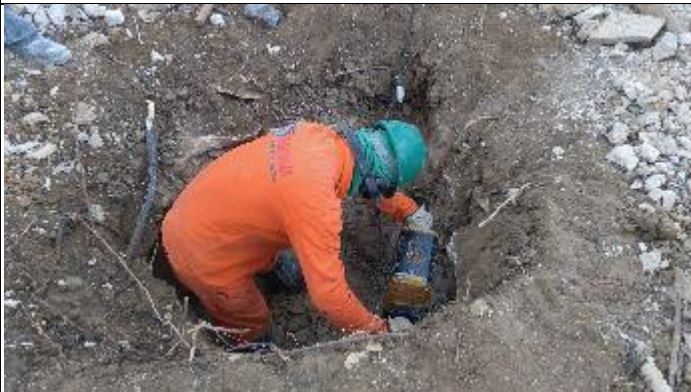
Figura 1. Reabertura cava D com martetele
