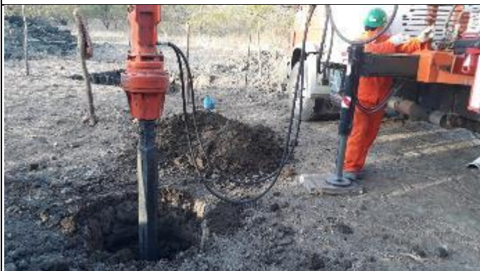
Figura 9. Abertura cava A com perfuratriz T 5/2
