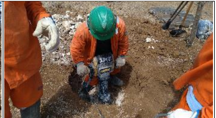
Figura 6. Reabertura cava A com martetele T 37/1
