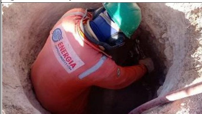
Figura 9. Continuação cava A com martetele T 15/2
