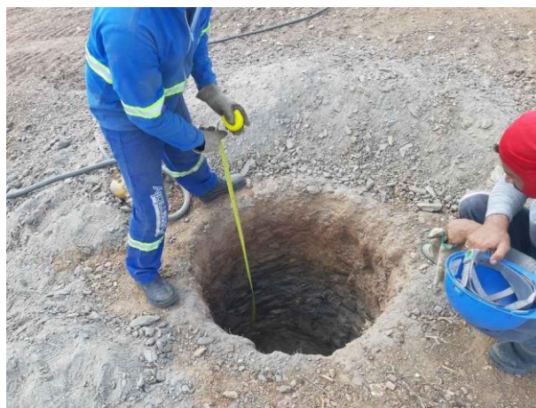
Figura 2. Torre 96/2, cava Central.
