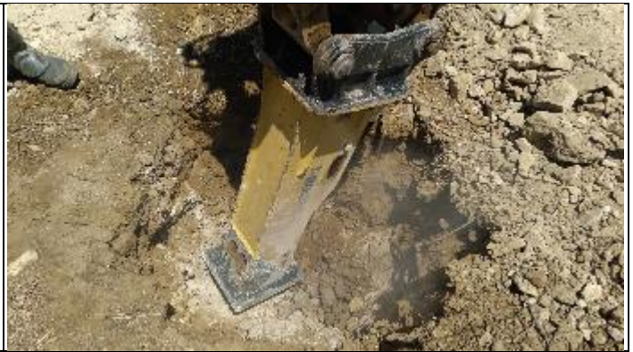
Figura 6. Reabertura cava C com picão T 36/1
