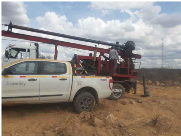
Figura 1. Torre 94/1, perfuratriz quebrada.
