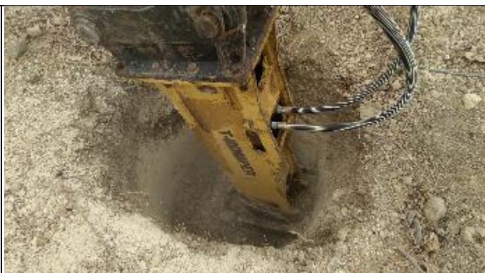
Figura 6. Abertura cava B com Picão T 33/1
