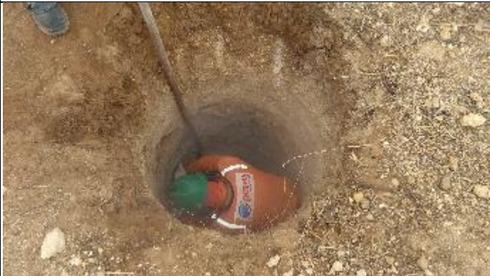
Figura 3. Reabertura Cava C com martetele T 16/4
