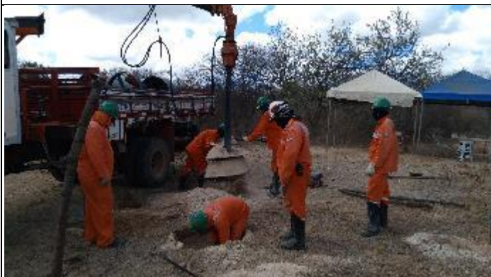
Figura 1. Abertura cava A com perfuratriz T 15/2
