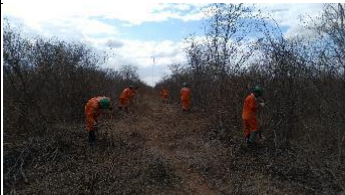
Figura 11. Supressão entre as Torres 69/1 e 68/2
