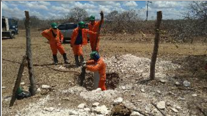
Figura 7. Reabertura cava A com martetele T 36/1
