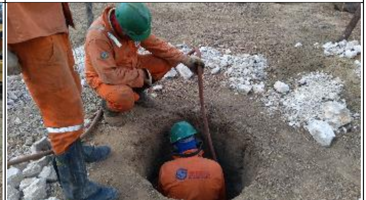
Figura 10. Continuação cava D com martelete T16/3
