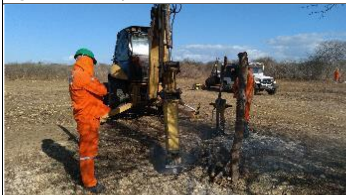
Figura 11. Reabertura cava A com picão T 36/1
