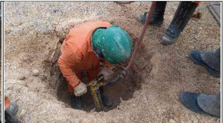
Figura 6. Abertura cava C com marteleto T 15/2
