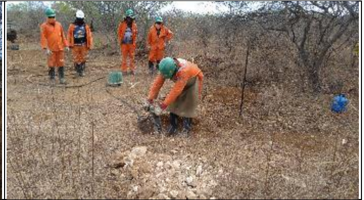
Figura 6. Abertura cava D com martetele T 17/1
