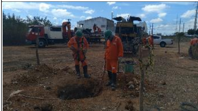
Figura 1. Reabertura cava B com martetele T 1/2
