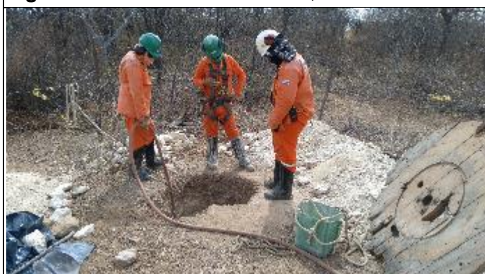
Figura 5. Início cava C 2,60m com martetele T 15/2
