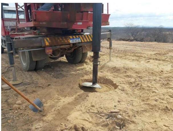
Figura 5. Torre 95/2, cava D.
