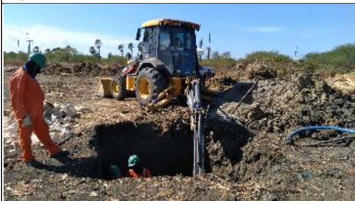
Figura 7. Escavação final Cava "B" T 4/1
