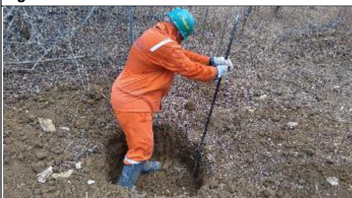
Figura 5. Reabertura cava D com alavanca T 36/1
