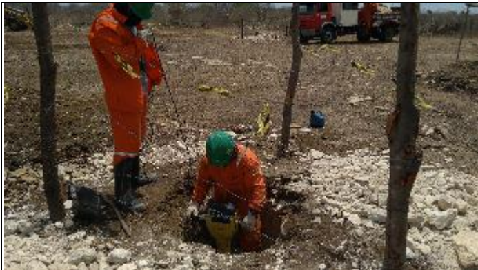
Figura 5. Abertura cava A com martetele rompedor
