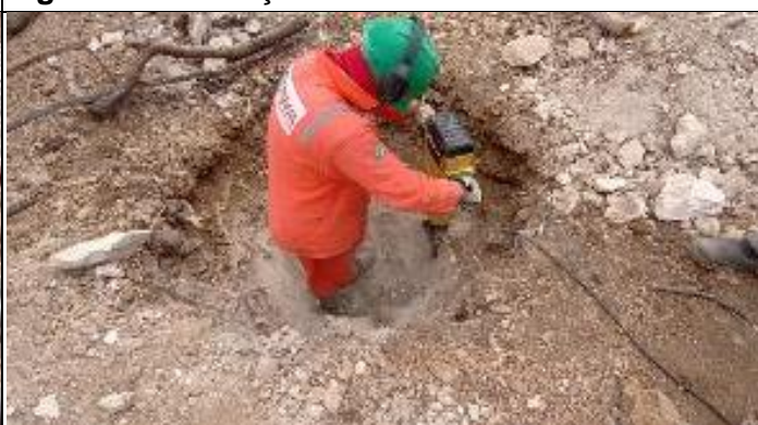
Figura 4. Reabertura Cava B com martetele T 36/1
