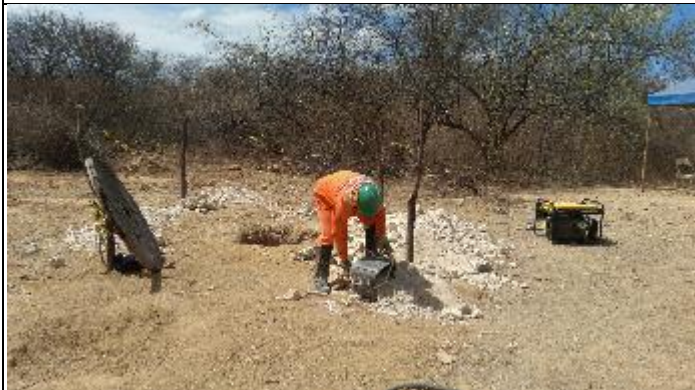
Figura 5. Reabertura cava D com martetele T 15/2
