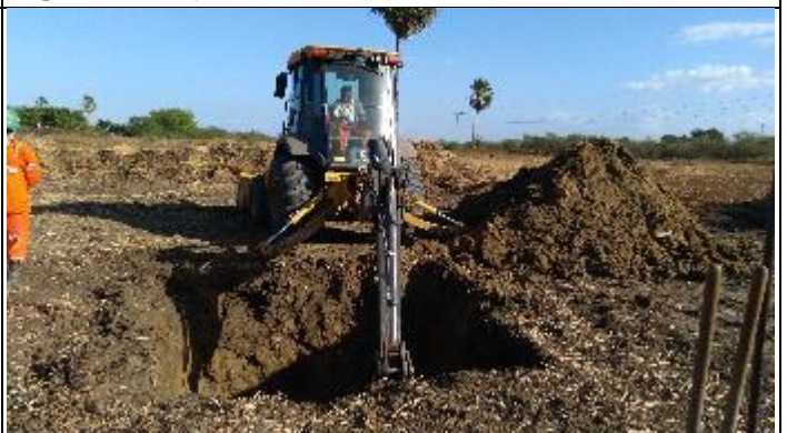
Figura 10. Abertura cava D com retroscavadeira T 16/3
