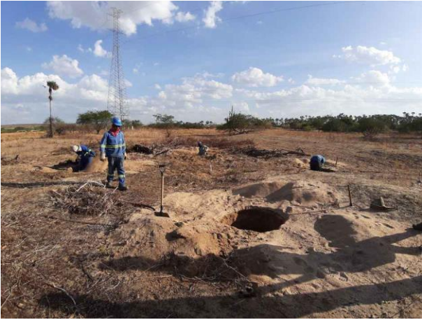
Figura 7. Torre 126/2, cava D
