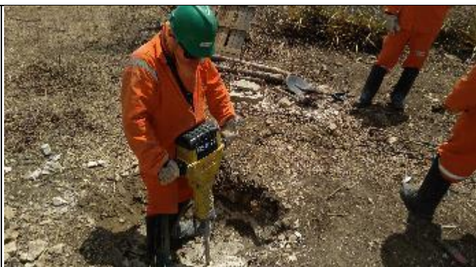
Figura 8. Abertura cava B com martetele T 37/2
