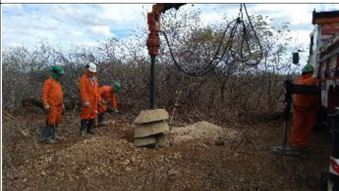
Figura 11. Finalização cava C com perfuratriz T 17/1
