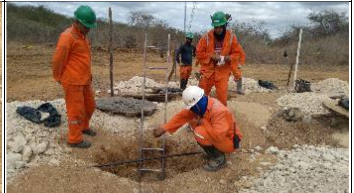
Figura 6. Finalização cava D com alavanca T 16/4
