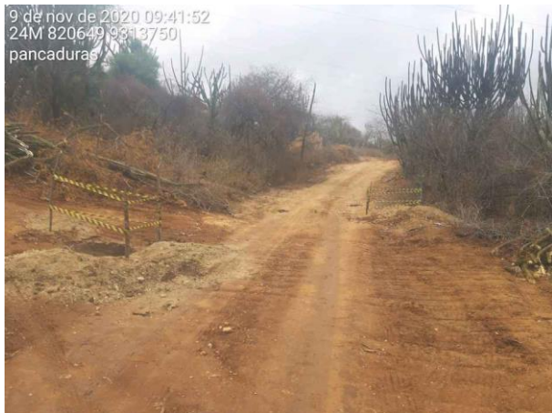
Figura 1. Escavação de pancaduras entre as torres 14/1 e 14/2, Cava A.
