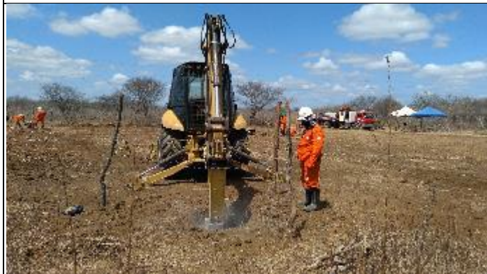
Figura 9. Reabertura Cava C com picão T 37/1
