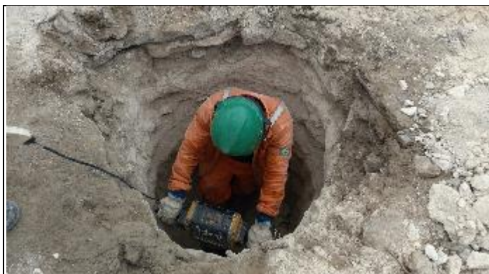
Figura 5. Reabertura cava D com martelete T 37/2
