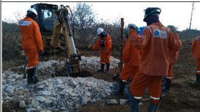
Figura 5. Reabertura cava C com Picão T 37/1
