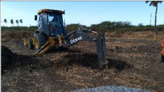
Figura 9. Abertura cava A com retro escadeira T 4/1
