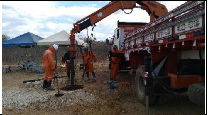
Figura 6. Abertura cava A com perfuratriz T 16/2
