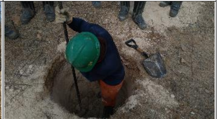
Figura 8. Abertura cava D com alavanca T 15/2
