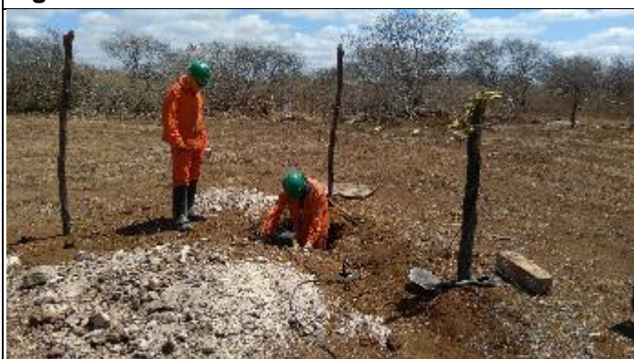
Figura 3. Reabertura Central com martetele T 37/1
