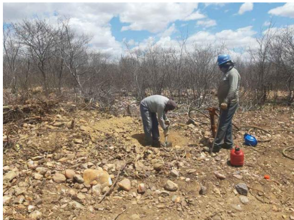
Figura 1. Torre 97/1, cava D.
