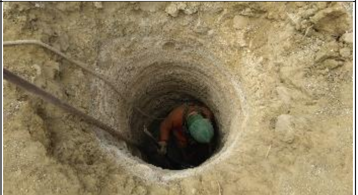
Figura 10. Finalização cava B com alavanca.
