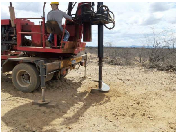
Figura 3. Torre 95/1, cava C.
