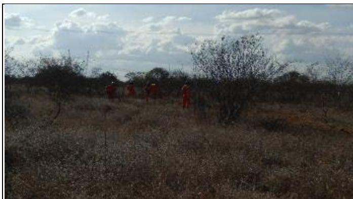
Figura 7. Supressão entre as torres 66/2 e 66/1
