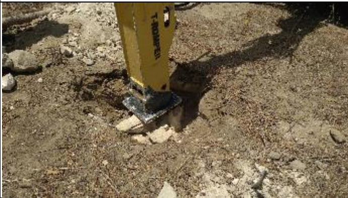
Figura 1. Abertura cava D com Picão T 37/2
