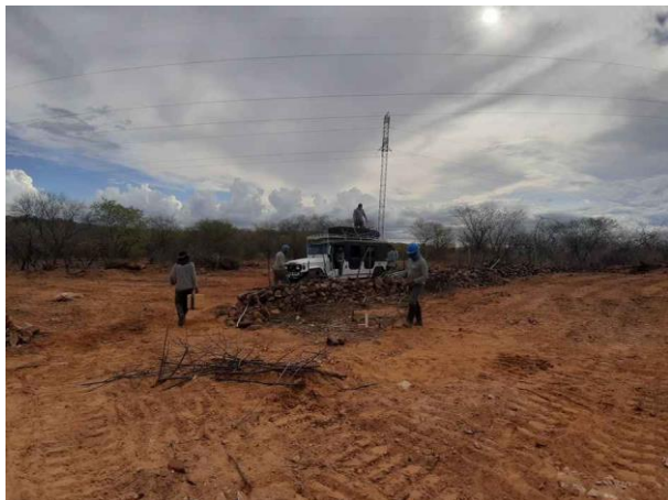
Figura 3. Torre 92/1, demarcação das áreas que serão escavadas.
