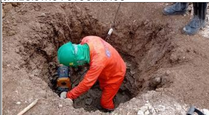
Figura 1. Reabertura cava D com martetele T 38/1
