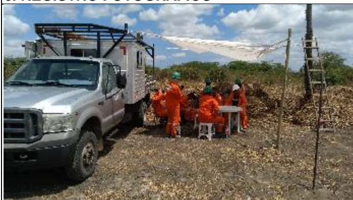
Figura 1. Escavação parada T 4/1
