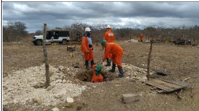
Figura 7. Reabertura cava Central T 37/2
