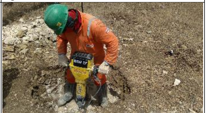
Figura 4. Abertura cava C com Martelete T 37/2
