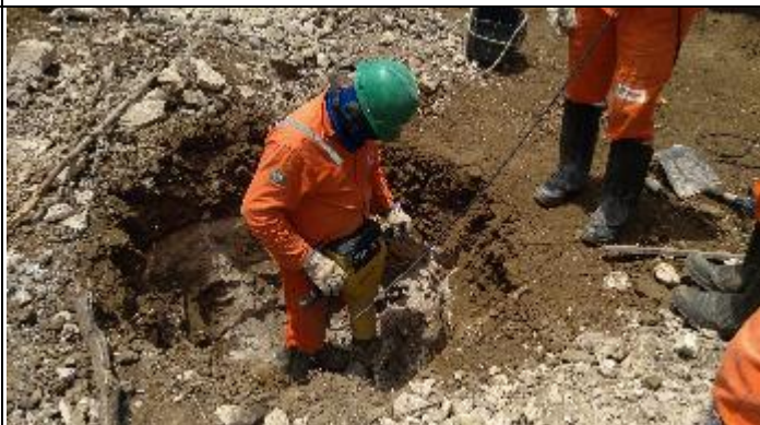
Figura 6. Reabertura cava C com martetele T 37/1
