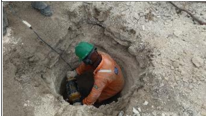
Figura 11. Finalizando Cava B com Martetele T 37/1
