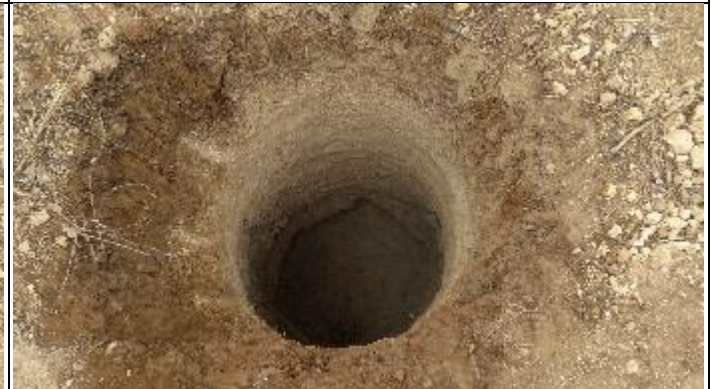
Figura 4. Finalização Cava C com martetele T 16/4
