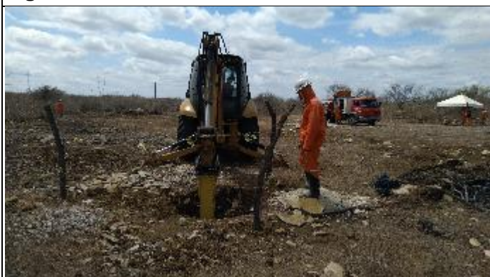
Figura 3. Reabertura cava "B" Torre 38/2
