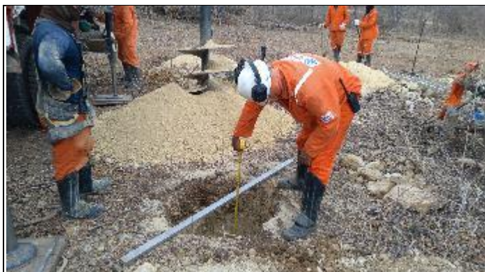
Figura 9. Finalização cava A com perfuratriz T 16/1
