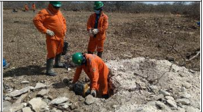
Figura 2. Abertura com Martelete T 37/2
