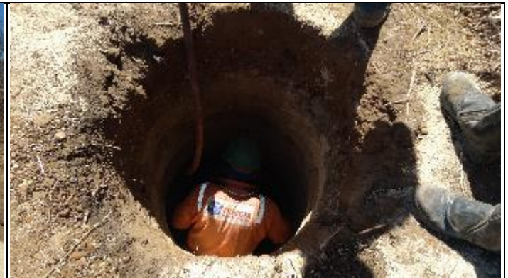
Figura 6. Reabertura cava B com martelete T 16/3
