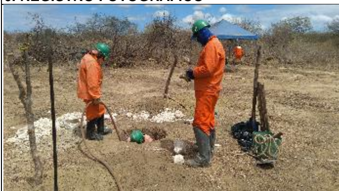
Figura 1. Reabertura cava D com martetele T 16/3
