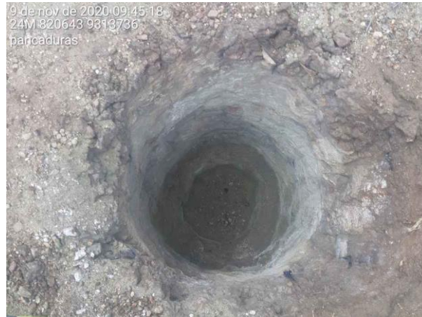
Figura 2. Escavação de pancaduras entre as torres 14/1 e 14/2, Cava B.
