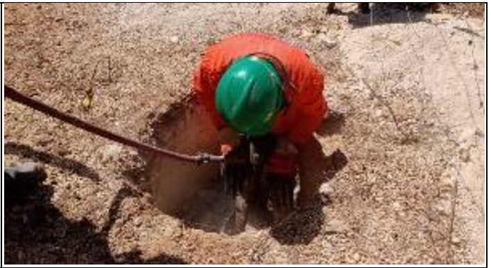
Figura 4. Abertura Cava B com martetele T 16/2
