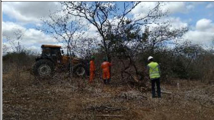
Figura 1. Supressão na praça da Torre 16/1
