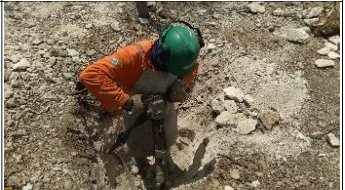
Figura 8. Reabertura cava A com martetele T 36/1
