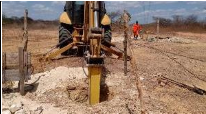
Figura 3. Abertura Cava A com picão T 16/2
