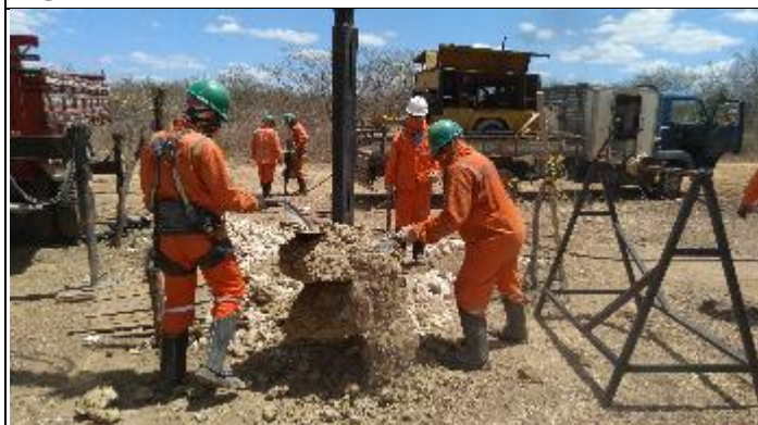
Figura 7. Finalização cava D com perfuratriz T 16/3
