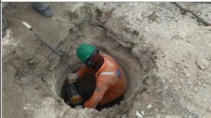
Figura 11. Finalizando Cava B com Martetele T 37/1
