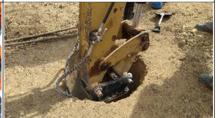
Figura 12. Reabertura cava C com picão T 16/3
