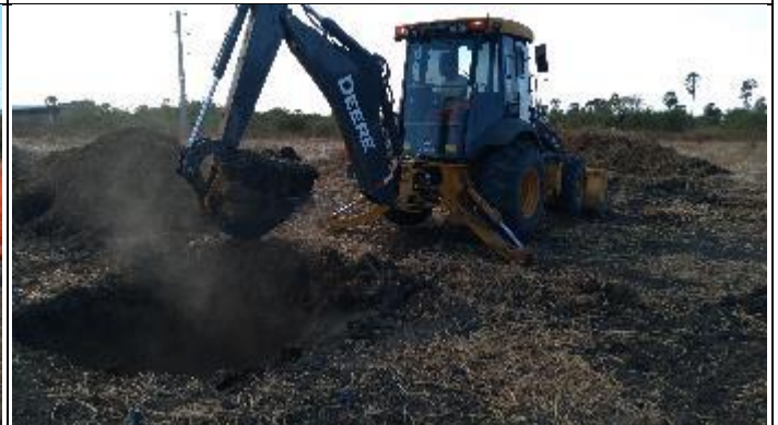
Figura 10. Abertura cava A retroescavadeira T 4/1
