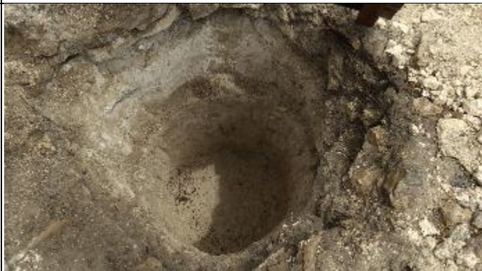
Figura 12. Cava B finalizada T 37/1
