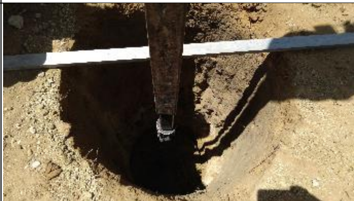
Figura 4. Finalização Cava C com perfuratriz T 16/3
