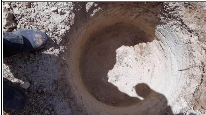
Figura 7. Abertura cava C com perfuratriz T 16/2
