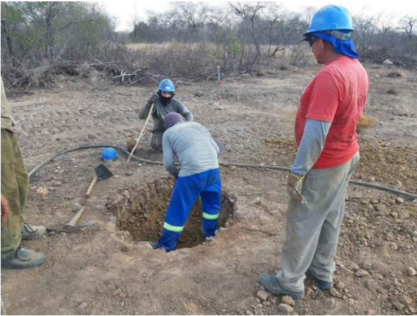
Figura 5. Torre 117/2, cava A.
