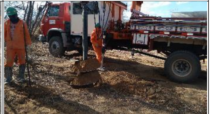
Figura 12. Abertura cava D com perfuratriz T 16/3
