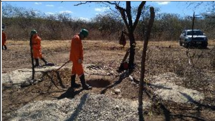
Figura 7. Continuação cava A com martelete T 16/3
