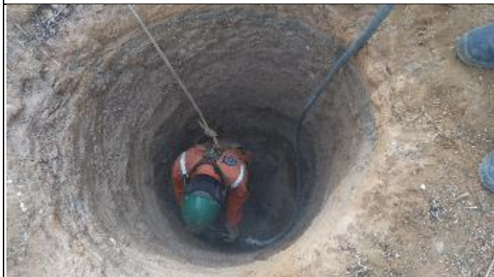
Figura 9. Reabertura cava D com martelete T 1/2
