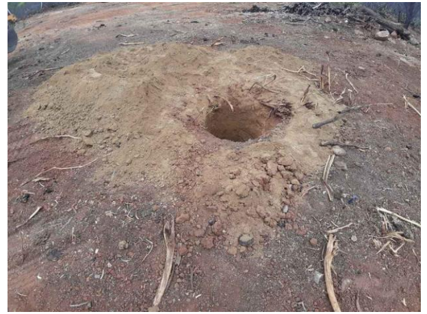
Figura 2. Escavação finalizada. Torre 71/1, cava C
