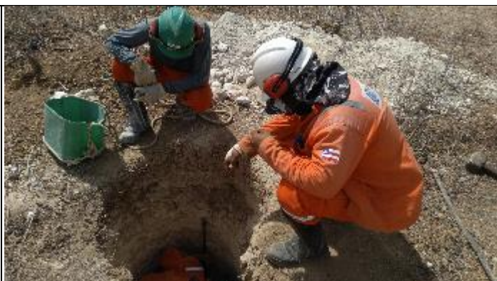
Figura 4. Reabertura Cava C com martetele T 15/2
