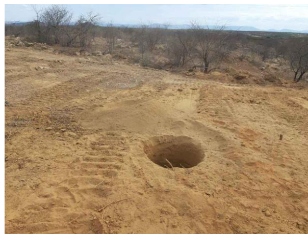
Figura 6. Torre 95/2, cava B.
