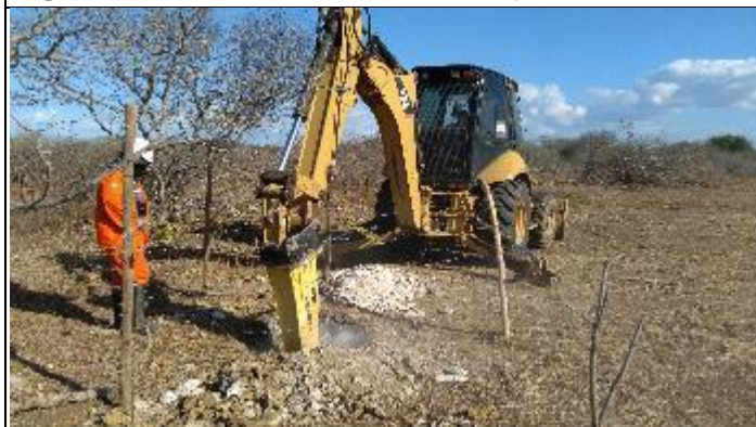
Figura 13. Reabertura cava B com picão T 36/1
