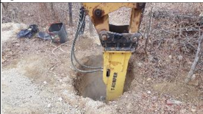
Figura 12. Finalização cava A com picão T 33/1
