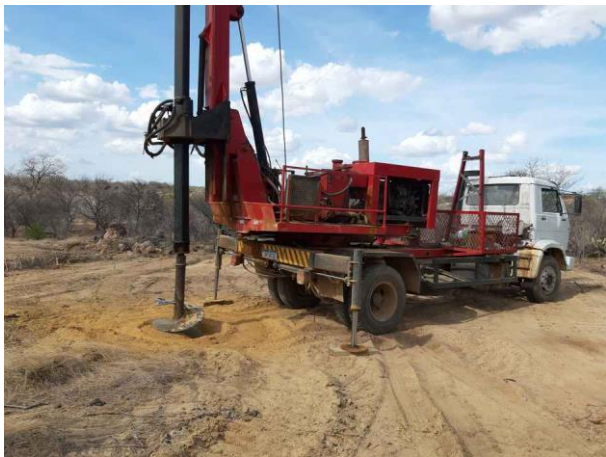
Figura 5. Torre 93/3, cava A.
