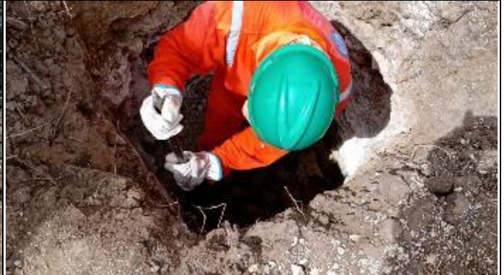
Figura 6. Finalização cava Central T com alavanca
