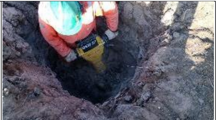
Figura 4. Reabertura cava C com martetele T 38/1
