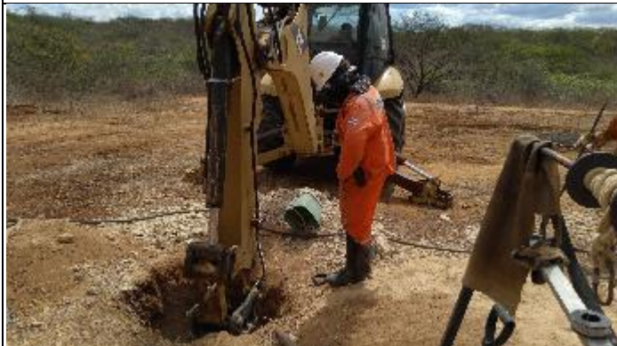
Figura 7. Abertura cava D com picão T 16/4
