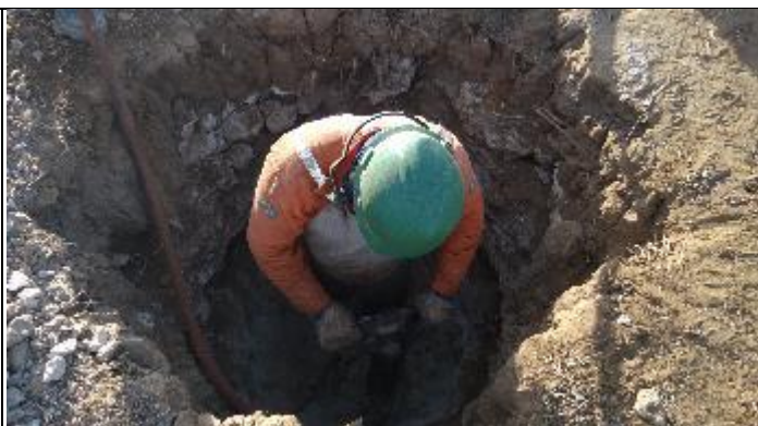
Figura 12. Reabertura cava C com martetele T 36/1
