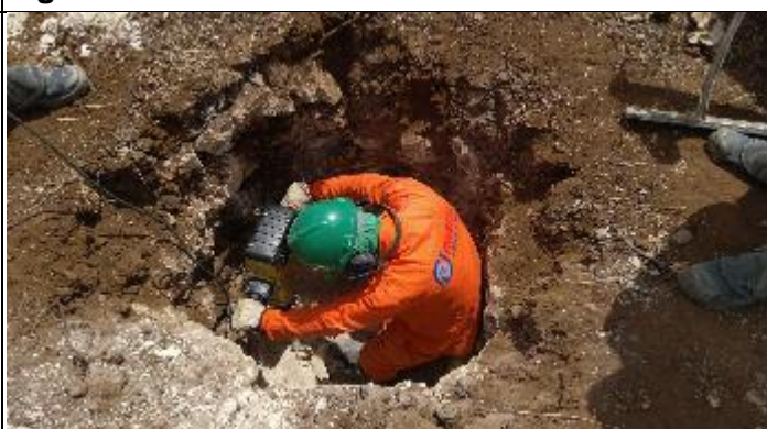
Figura 8. Reabertura cava D com martetele T 37/1
