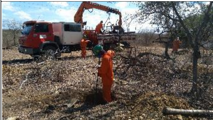
Figura 1. Abertura cava A com alavanca T 16/1
