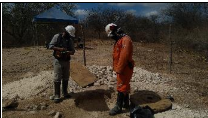
Figura 2. Finalização cava A com 2,94m T 15/2
