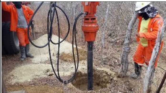
Figura 10. Abertura cava A com perfuratriz T 33/1
