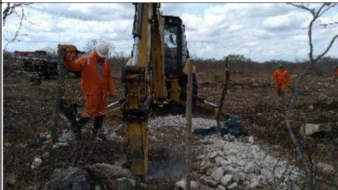
Figura 4. Reabertura Cava C com picão T 34/2
