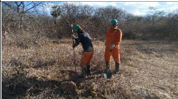
Figura 12. Abertura Cava C com alavanca T 15/2
