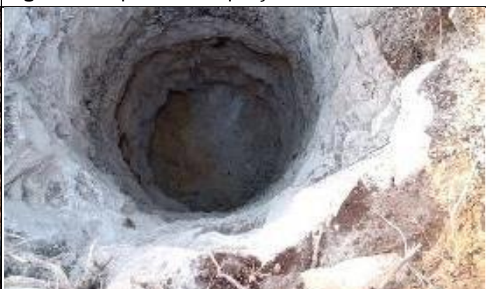
Figura 6. Finalização da Torre 36/1
