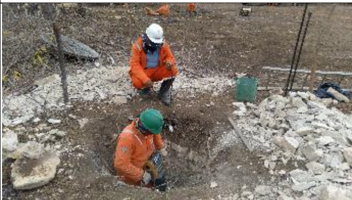
Figura 3. Reabertura cava C com martetele
