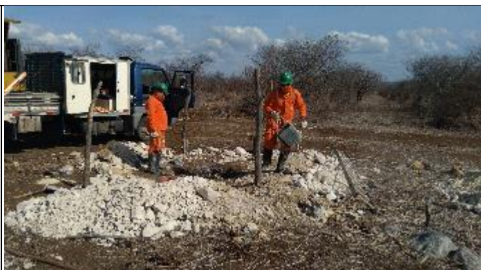
Figura 8. Reabertura cava C com martelete T 54/4
