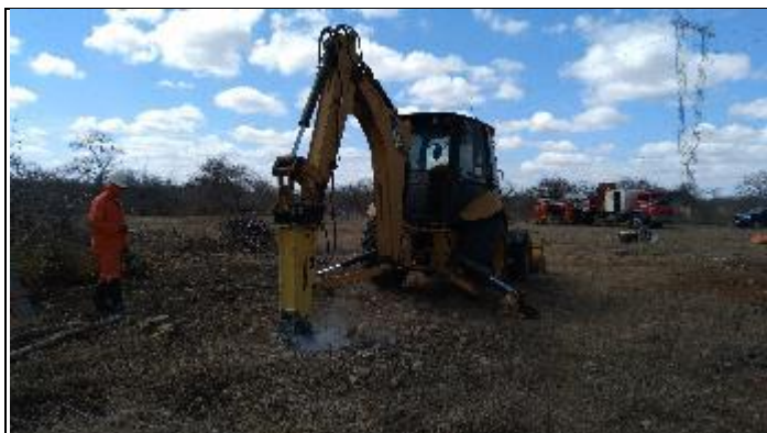
Figura 7. Abertura cava B com picão T 37/2
