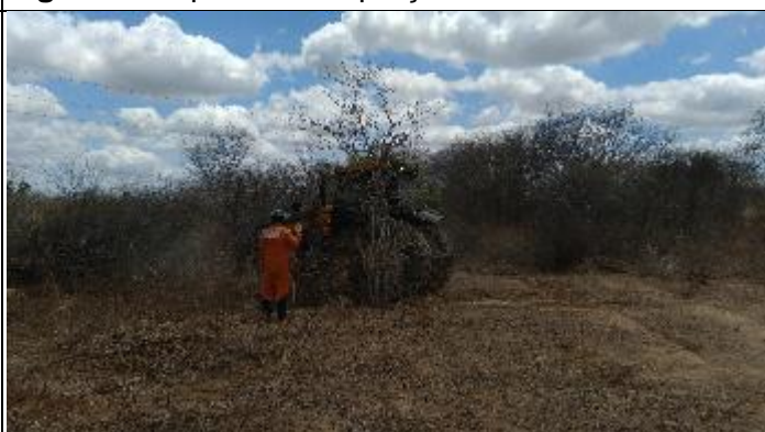
Figura 4. Supressão na praça da Torre 15/2
