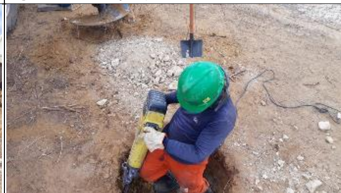
Figura 4. Abertura Cava C com martelete T 16/2
