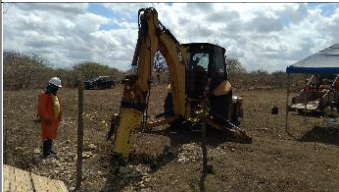
Figura 7. Reabertura cava A com picão T 38/1
