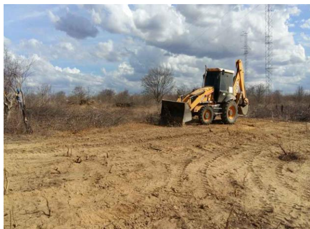
Figura 2. Torre 110/2, supressão com retroescavadeira.
