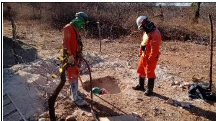
Figura 11. Continuação cava C com martetele T 15-2
