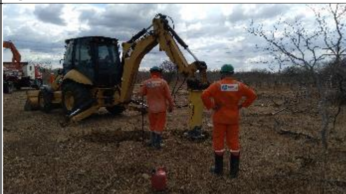
Figura 12. Reabertura cava Central T 37/2
