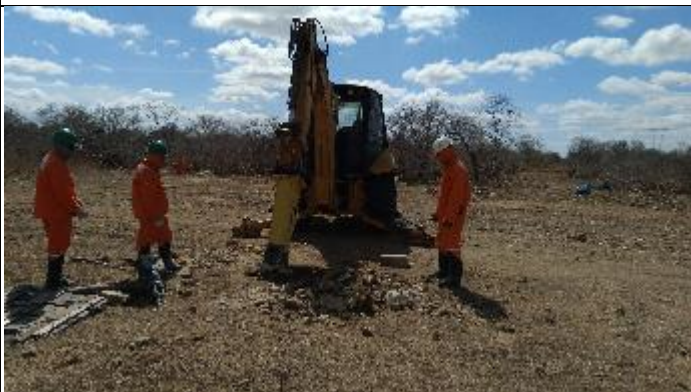
Figura 5. Abertura cava Central com Picão T 37/2
