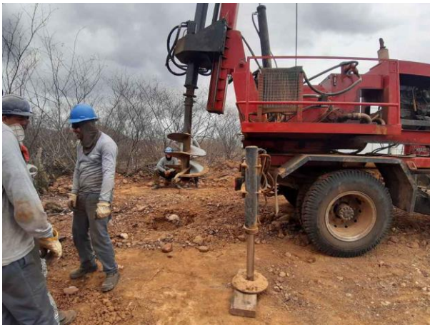
Figura 1. Escavação com perfuratriz da torre 71/1, cava B
