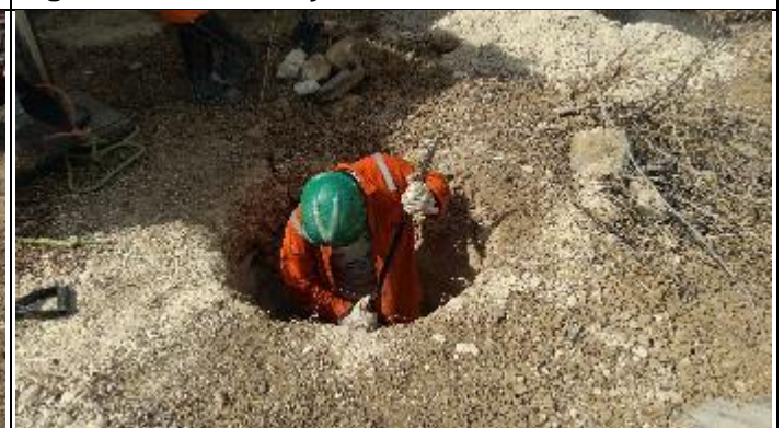
Figura 12. Continuação Cava C com alavanca 15/2
