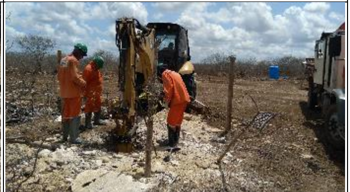
Figura 4. Reabertura Cava A com picão T 34/2
