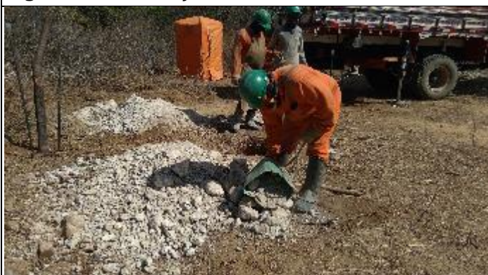
Figura 11. Retirada de rochas cava B T 15-2
