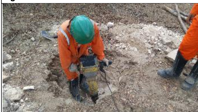
Figura 3. Reabertura cava C com martetele T 37/2
