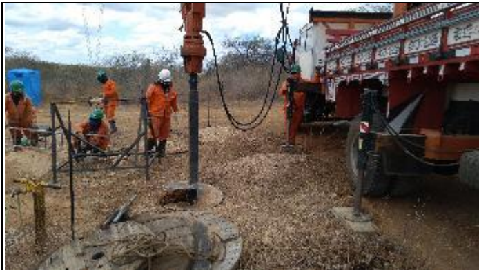
Figura 5. Abertura cava C com perfuratriz T 16/4
