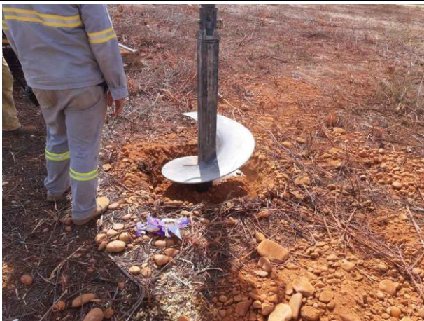
Figura 5. Torre 133/1, cava D.
