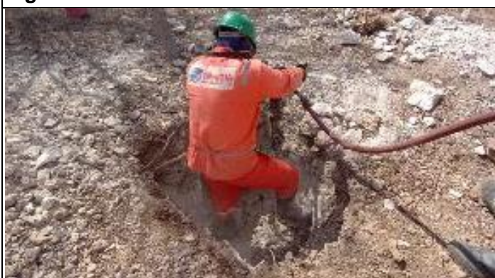
Figura 3. Reabertura Cava A com martetele T 36/1
