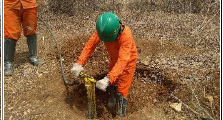
Figura 8. Abertura cava C com martetele T 17/1
