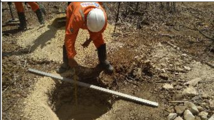
Figura 8. Finalização cava C com perfuratriz T 16/1
