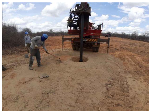
Figura 4. Torre 94/2, cava B.
