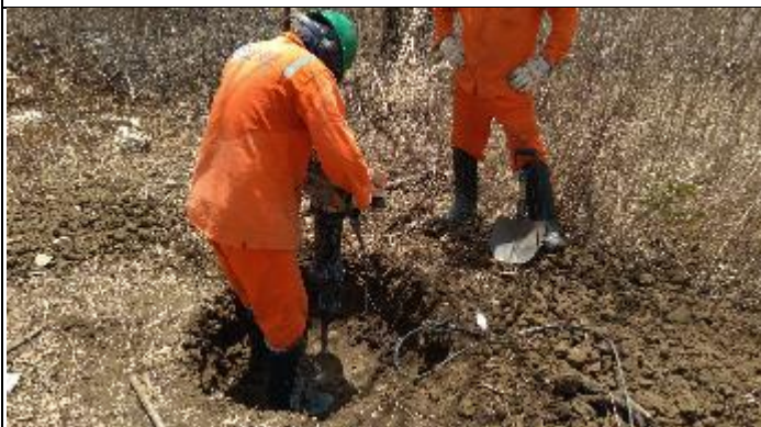
Figura 9. Reabertura cava D com martetele T 34/2
