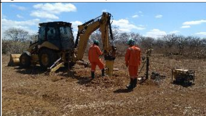
Figura 4. Abertura cava Central com picão T 37/1
