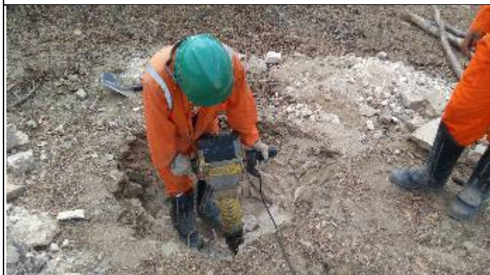
Figura 3. Reabertura cava C com martetele T 37/2
