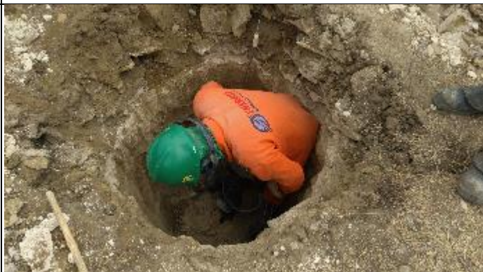
Figura 8. reabertura cava Central T 37/2
