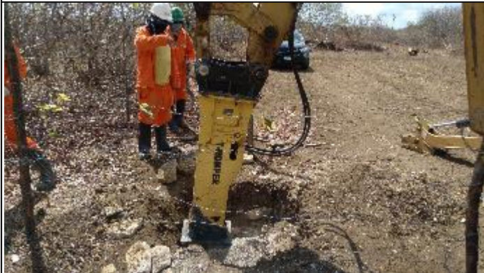
Figura 5. Reabertura cava B com picão T 38/1
