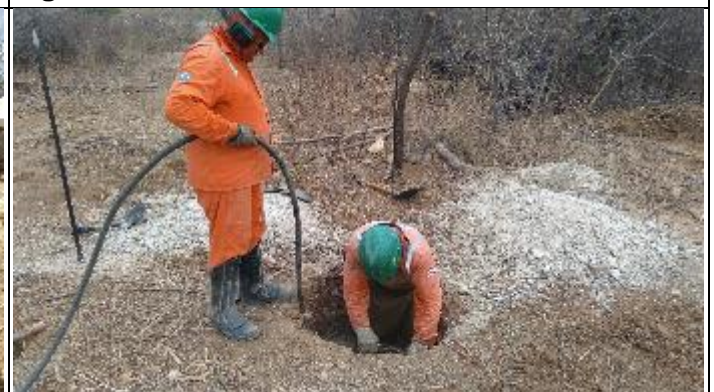
Figura 4. Abertura Cava B com marteleto T 15/2
