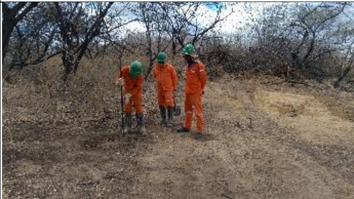
Figura 7. Abertura cava A com alavanca T 16/3
