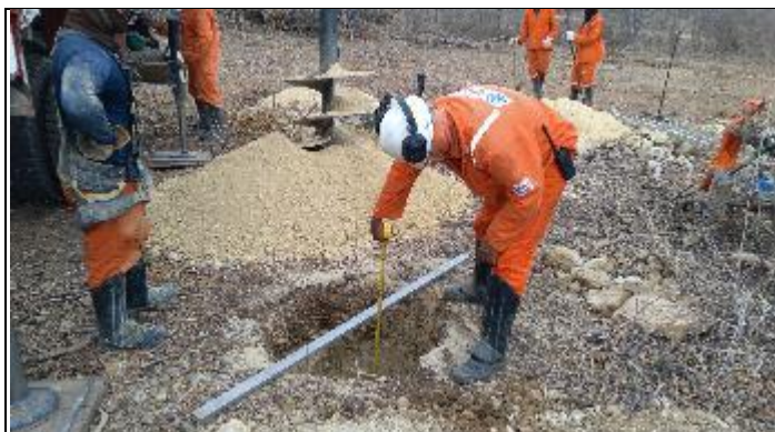
Figura 9. Finalização cava A com perfuratriz T 16/1
