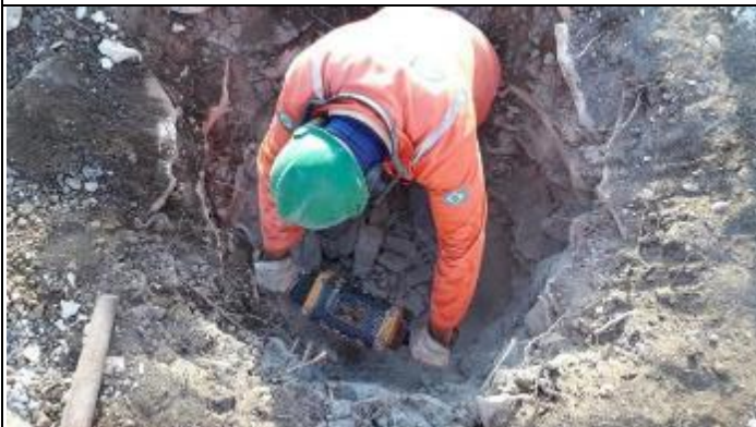
Figura 9. Reabertura cava "C" com martetele
