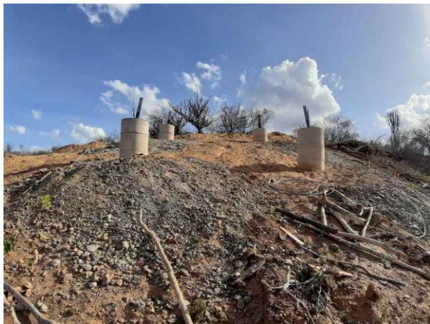
Figura 7. Torre 33/2. Escavação com rompedor, rochas em baixa profundidade.
