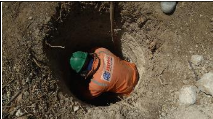
Figura 2. Reabertura cava B com martetele T 15/2
