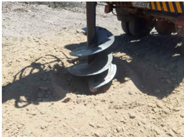
Figura 1. Torre 93/1, Cava D. Escavação com perfuratriz.
