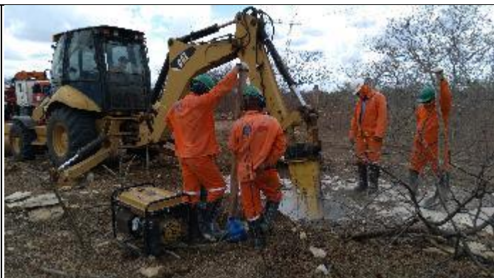
Figura 2. Reabertura cava A com picão T 34/2
