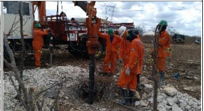
Figura 2. Reabertura cava B com perfuratriz T 34/2
