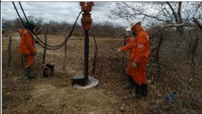
Figura 8. Abertura cava D com perfuratriz T 33/1
