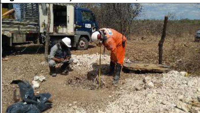
Figura 4. Finalização Cava B com 2,94m T 15/2
