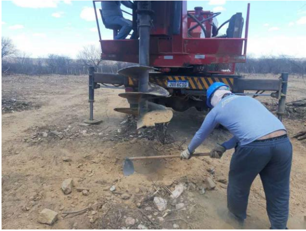
Figura 1. Torre 96/2, cava B.
