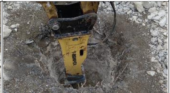
Figura 4. Reabertura cava C com picão rompedor
