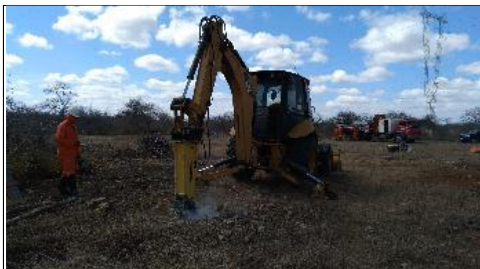
Figura 7. Abertura cava B com picão T 37/2
