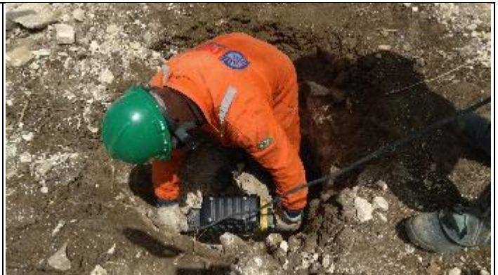
Figura 6. Abertura cava A com martetele rompedor
