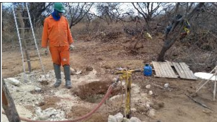
Figura 8. Continuação cava B com martetele T 16/3
