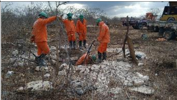
Figura 5. Reabertura cava C com Rompedor T 34/2
