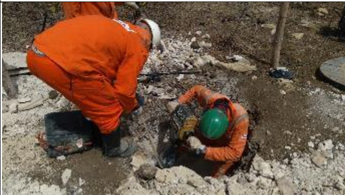
Figura 3. Reabertura cava A com martetele T 34/2
