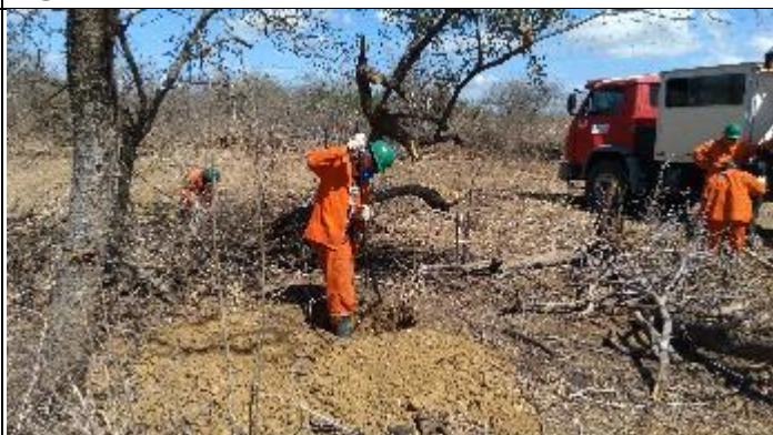
Figura 4. Abertura Cava D com alavanca T 16/1
