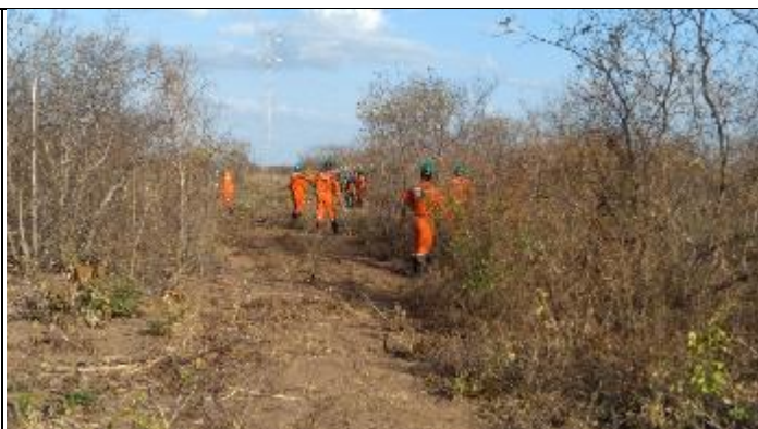
Figura 8. Supressão entre as torres 66/1 e 65/3
