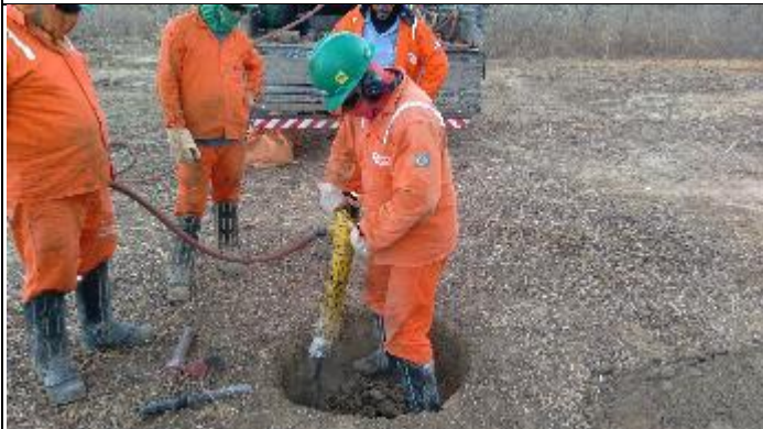
Figura 11. Abertura cava D com martelete T 16/3
