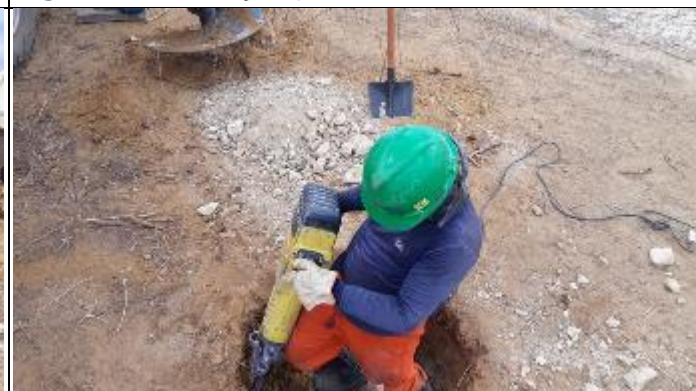
Figura 4. Abertura Cava C com martelete T 16/2
