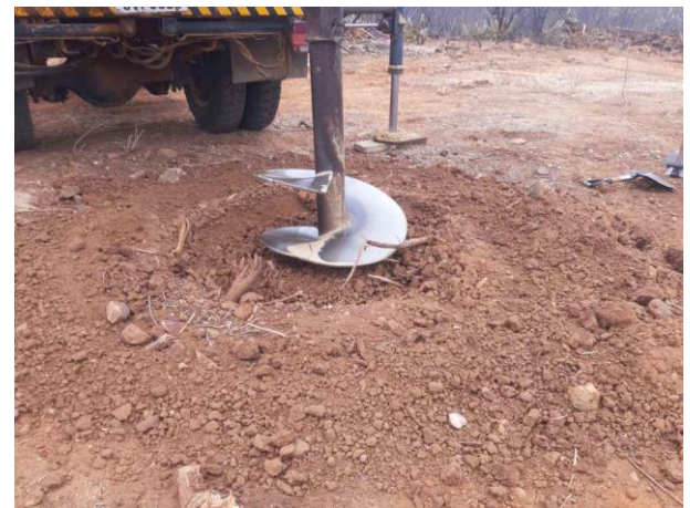
Figura 2. Torre 90/2 – escavação com perfuratriz, cava central.
