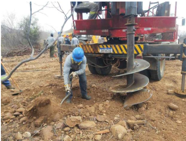
Figura 1. Escavação com perfuratriz da torre 71/1, cava A
