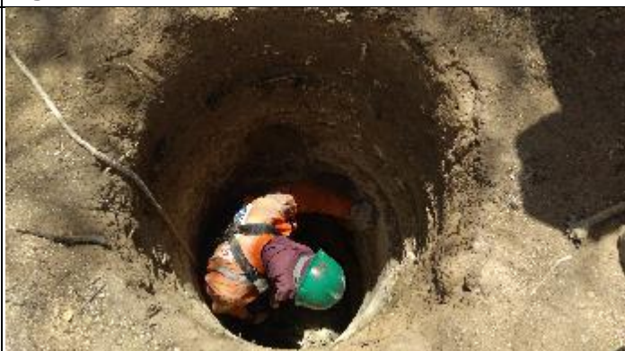
Figura 4. Reabertura Cava A com rompedor T 16/3
