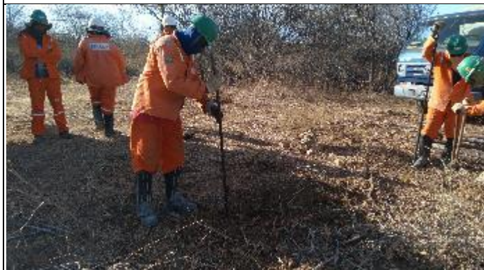
Figura 11. Abertura Cava B com alavanca T 15/2
