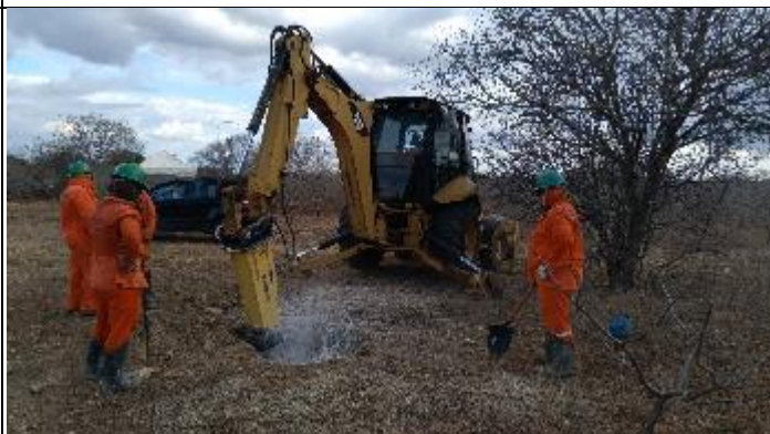
Figura 14. Abertura cava A Picão rompedor T 36/1
