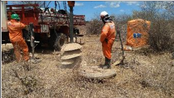
Figura 7. Abertura cava D com perfuratriz T 15/2
