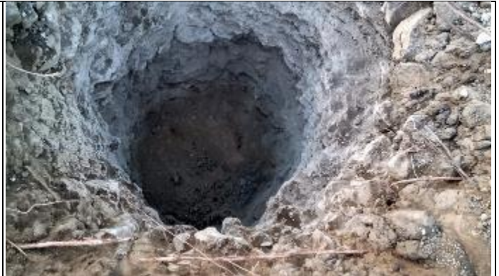
Figura 4. Finalização cava C T 38/1
