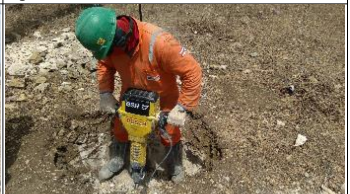
Figura 4. Abertura cava C com Martelete T 37/2
