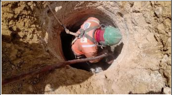
Figura 6. Abertura cava D com martetele T 16/2
