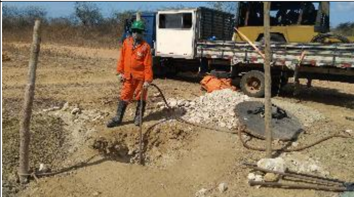
Figura 9. Finalização cava B com martetele.
