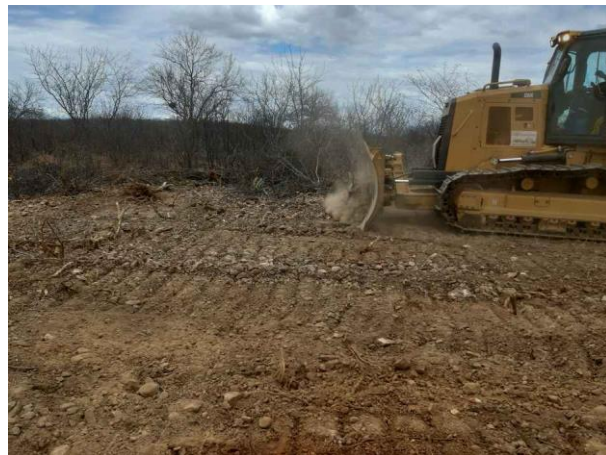
Figura 2. Torre 98/2, limpeza de praça.
