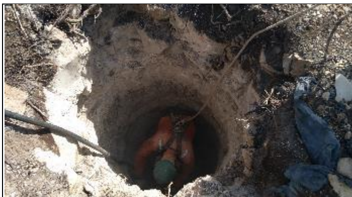
Figura 7. Reabertura cava A com martelete T 54/4
