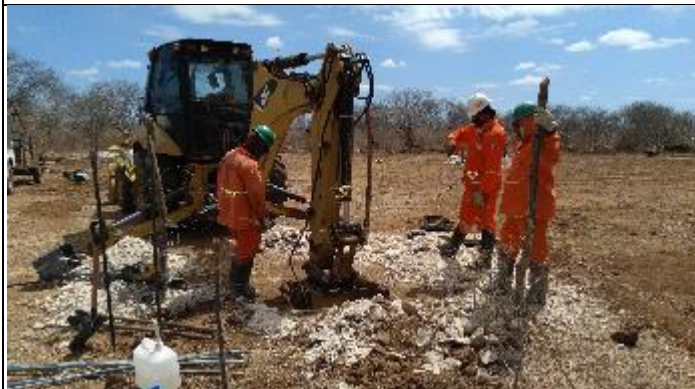
Figura 1. Reabertura com Picão Cava A T 37-1
