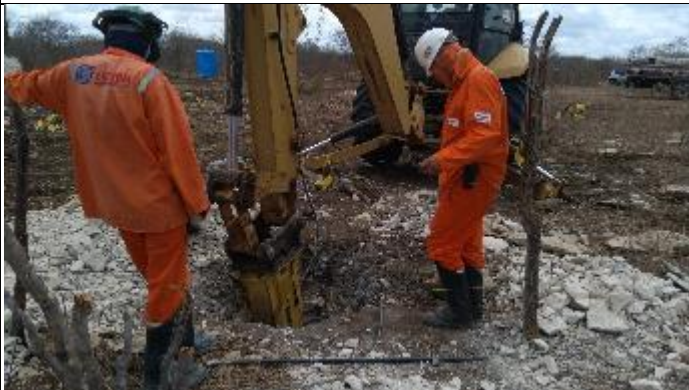
Figura 1. Reabertura cava B com picão T 34/2
