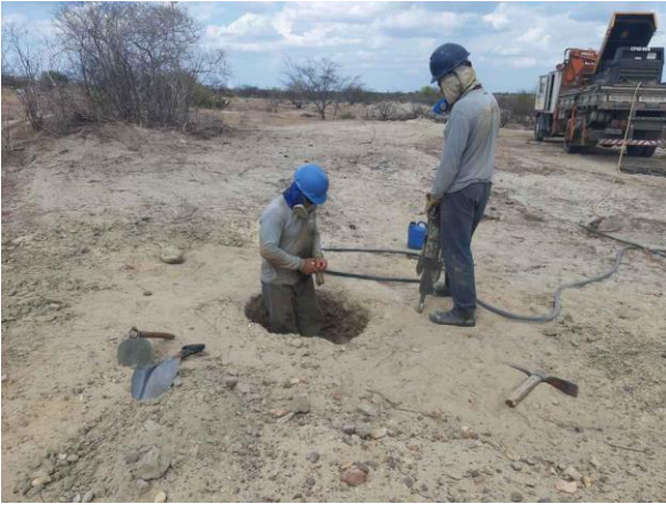
Figura 3. Torre 116/1, cava C.
