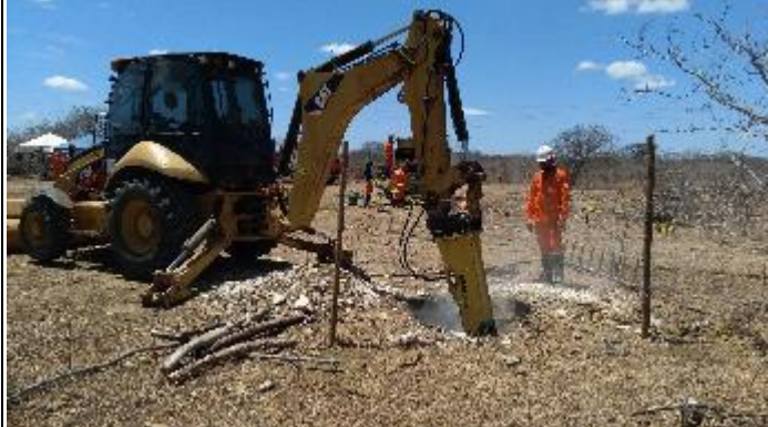
Figura 7. Reabertura cava B com picão T 36/1
