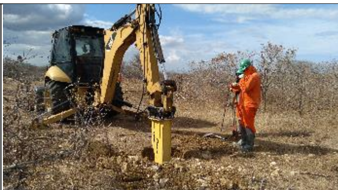
Figura 8. Abertura cava C com Picão T 37/2
