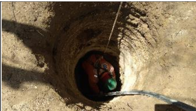
Figura 2. Finalização cava A com martetele T 16/3
