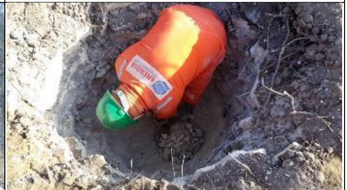
Figura 10. Retirada de material com pá cava "D"
