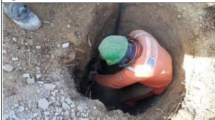
Figura 11. Finalização cava A com martetele T 33/1
