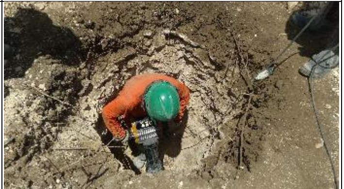
Figura 8. Reabertura cava B com martetele T 38/1
