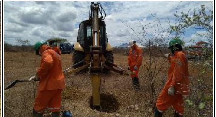
Figura 10. Abertura cava B com picão T 17/1
