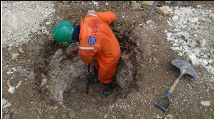
Figura 7. Abertura cava Central com alavanca
