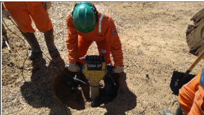
Figura 2. Reabertura cava C com martelete T 16/3
