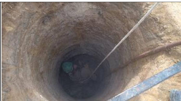
Figura 8. Reabertura cava C com martelete T 1/2
