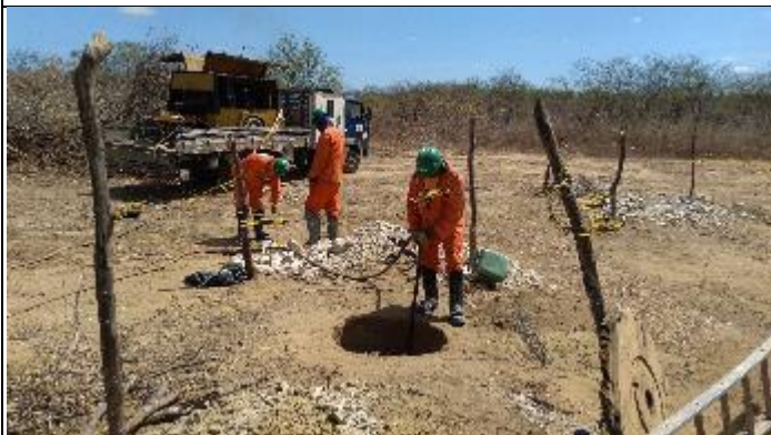
Figura 3. Reabertura Cava C com martetele T 16/3
