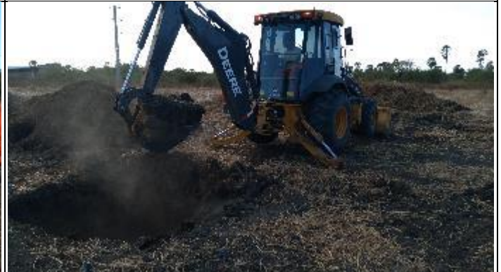
Figura 10. Abertura cava A retroescavadeira T 4/1
