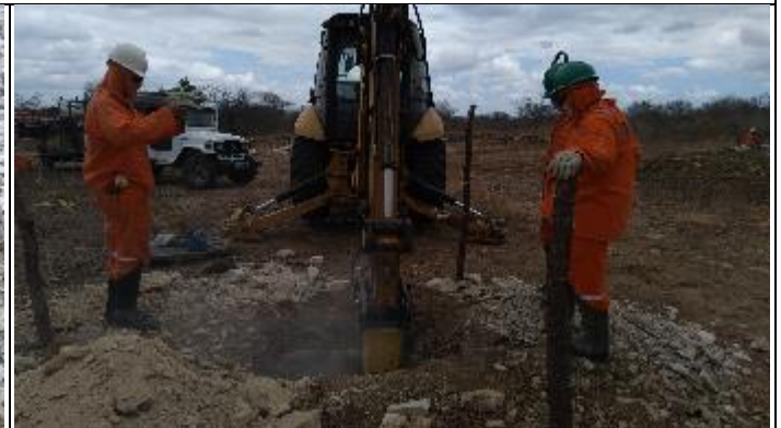
Figura 2. Reabertura cava D com picão rompedor
