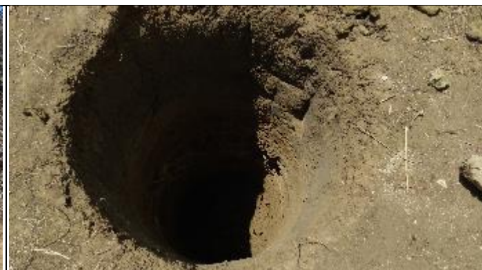
Figura 6. Finalização cava B com martetele T 16/3
