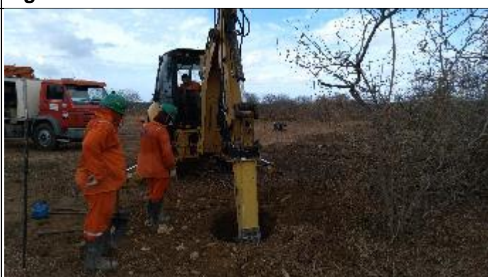
Figura 6. Abertura cava D com picão T 36/1
