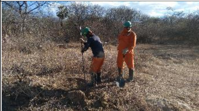
Figura 12. Abertura Cava C com alavanca T 15/2
