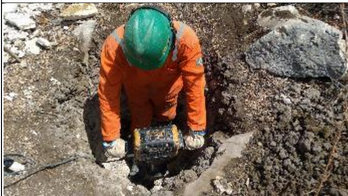
Figura 3. Reabertura cava C com martetele T 34/2
