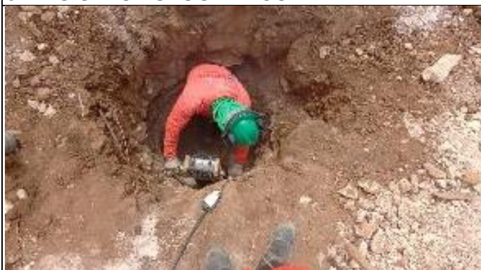
Figura 1. Reabertura com martetele cava D T 36-1
