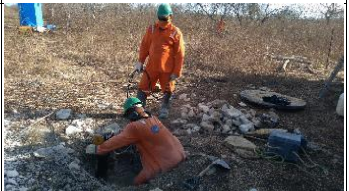
Figura 10. Reabertura central com martetele T 34/2
