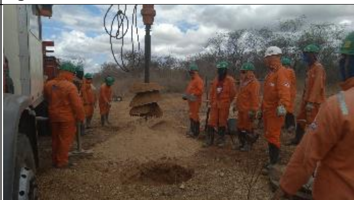
Figura 4. Abertura Cava D com perfuratriz T 16/4
