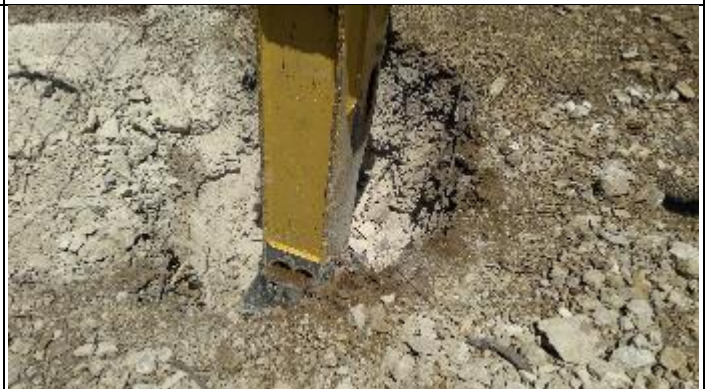
Figura 10. Reabertura cava "A" com picão T 36/1
