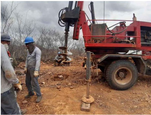
Figura 1. Escavação com perfuratriz da torre 71/1, cava B
