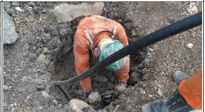
Figura 6. Reabertura cava C com Rompedor T 34/2
