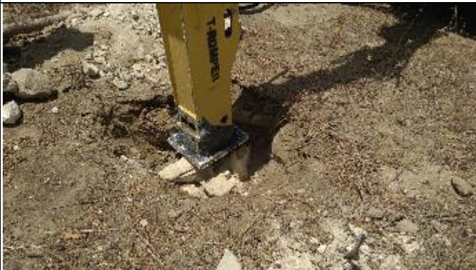
Figura 1. Abertura cava D com Picão T 37/2
