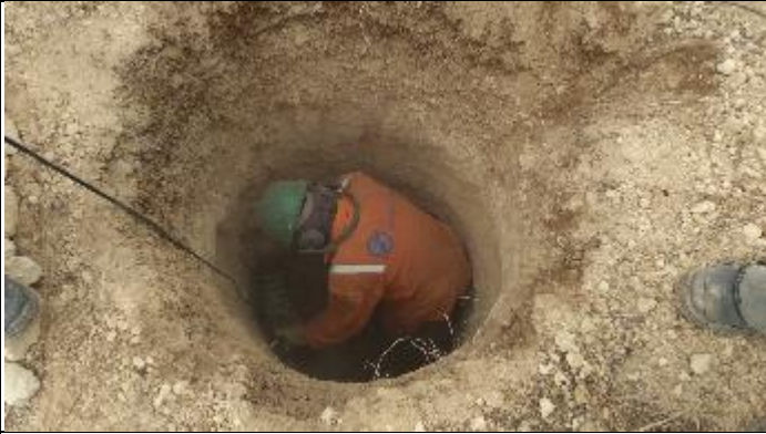
Figura 1. Reabertura cava B com martetele T 16/4
