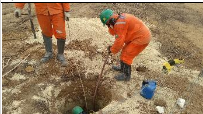
Figura 5. Reabertura cava B com rompedor T 16/3
