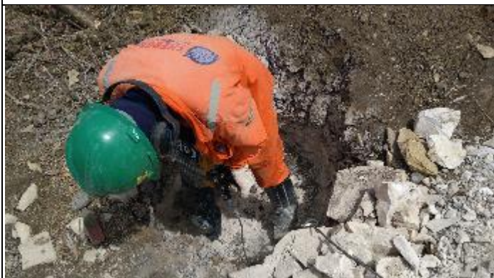
Figura 1. Reabertura cava A com martetele T 34/2
