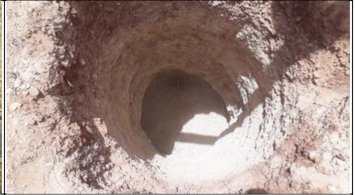
Figura 2. Finalização cava B com martetele T 16/4
