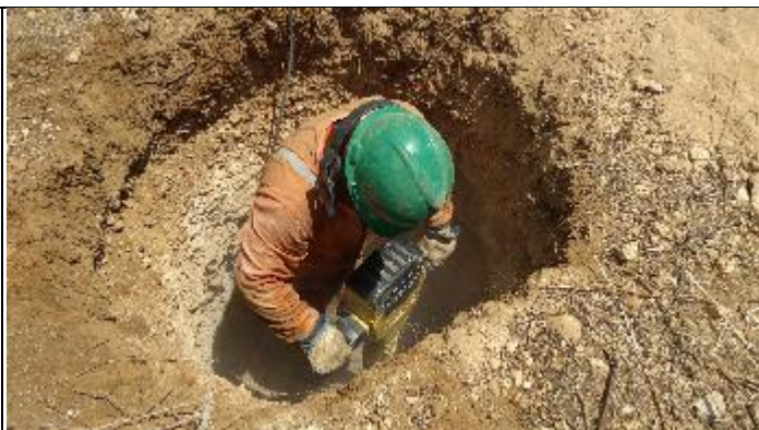
Figura 2. Abertura cava A com martetele T 16/4
