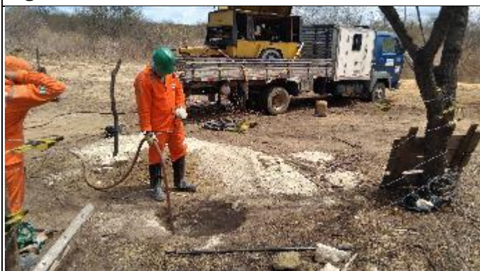
Figura 3. Reabertura Cava A com martetele T 16/3
