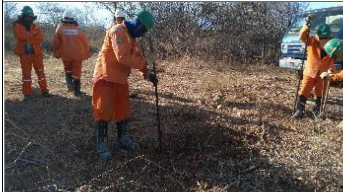
Figura 11. Abertura Cava B com alavanca T 15/2
