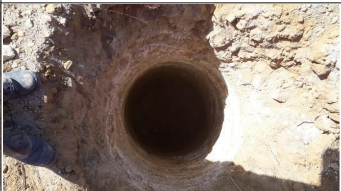
Figura 8. Abertura cava D com Perfuratriz T 16/2
