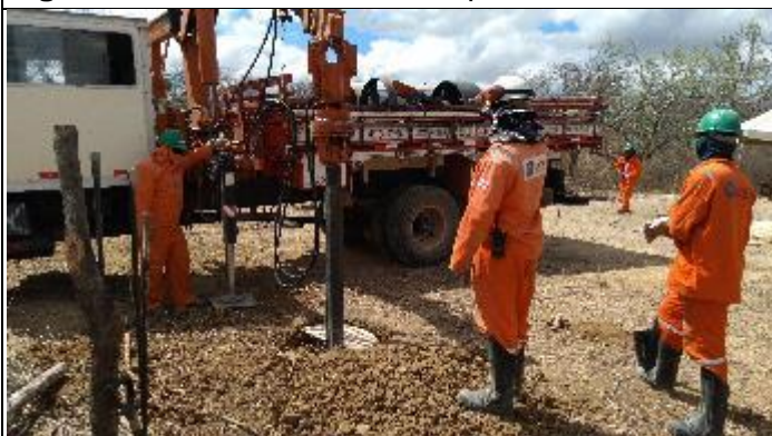
Figura 3. Abertura Cava B com perfuratriz 15/2
