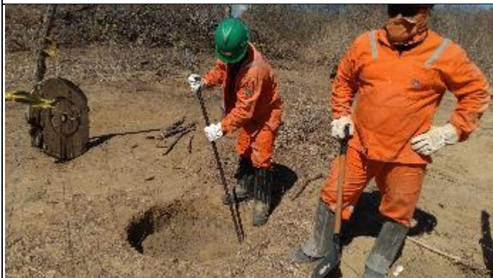
Figura 1. Reabertura cava C com alavanca T 16/3
