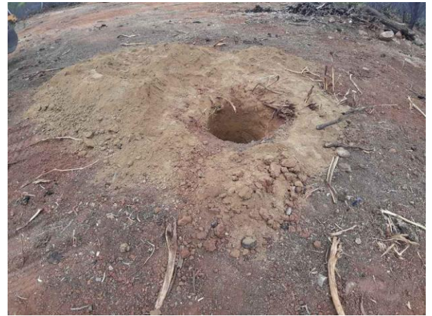
Figura 2. Escavação finalizada. Torre 71/1, cava C
