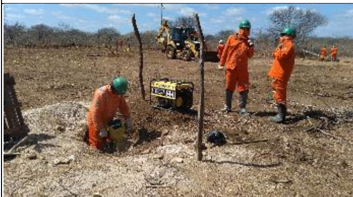
Figura 1. Reabertura com martetele Cava B T 37-1
