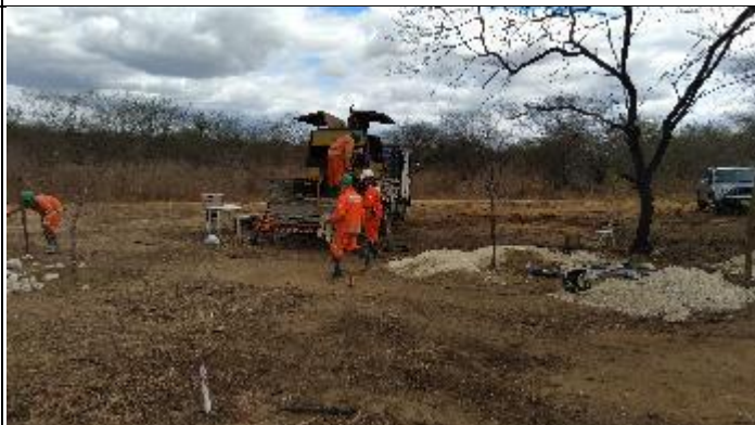
Figura 10. Máquina quebrada T 16/3
