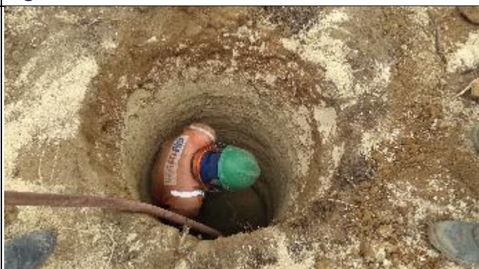
Figura 6. Reabertura cava B com rompedor T 16/3
