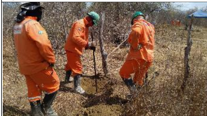
Figura 9. Abertura cava A com alavanca T 33/1
