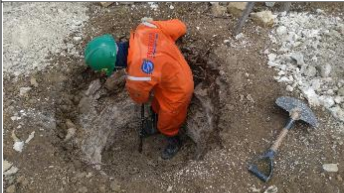
Figura 7. Abertura cava Central com alavanca
