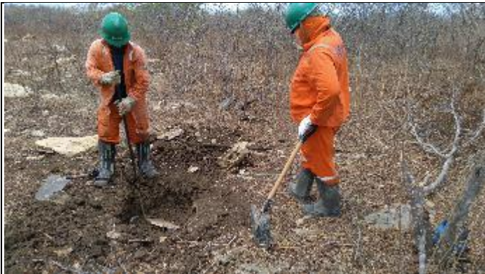
Figura 3. Abertura Cava B com alavanca T 34/2
