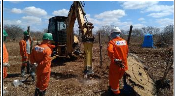
Figura 8. Reabertura cava D com Picão T 37/1
