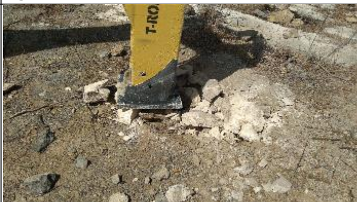
Figura 10. Abertura cava A com Martelete T 37/2
