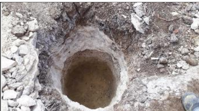
Figura 8. Finalização cava B com martetele T 34/2
