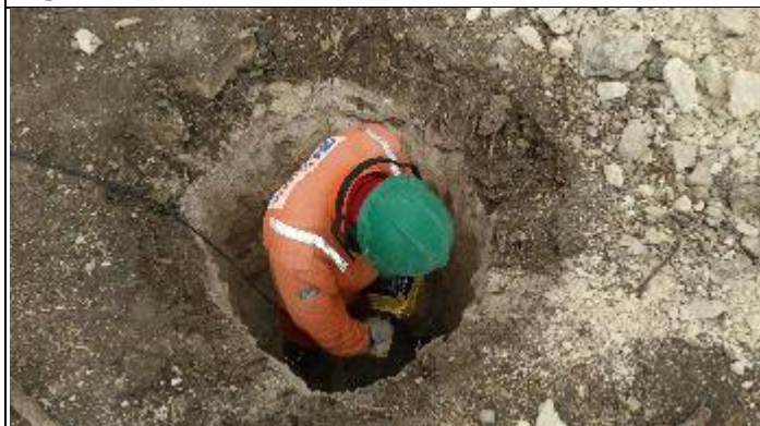
Figura 9. Reabertura cava B com martelete T 37/2
