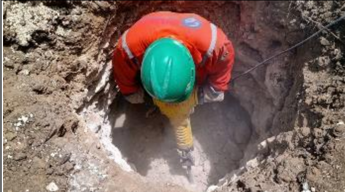
Figura 5. Reabertura cava Central T 38/1
