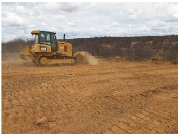
Figura 1. Torre 98/2, limpeza de praça.
