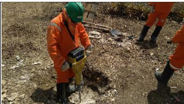
Figura 8. Abertura cava B com martelete T 37/2
