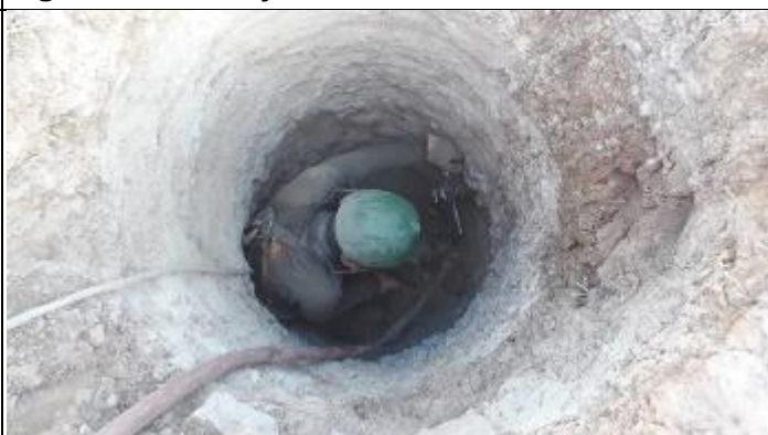
Figura 10. Continuação cava B com martetele 15/2
