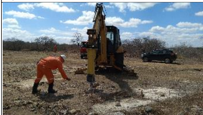
Figura 9. Abertura cava A com Picão T 37/2
