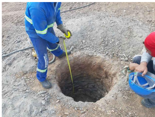
Figura 2. Torre 96/2, cava Central.
