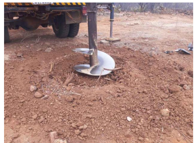
Figura 2. Torre 90/2 – escavação com perfuratriz, cava central.
