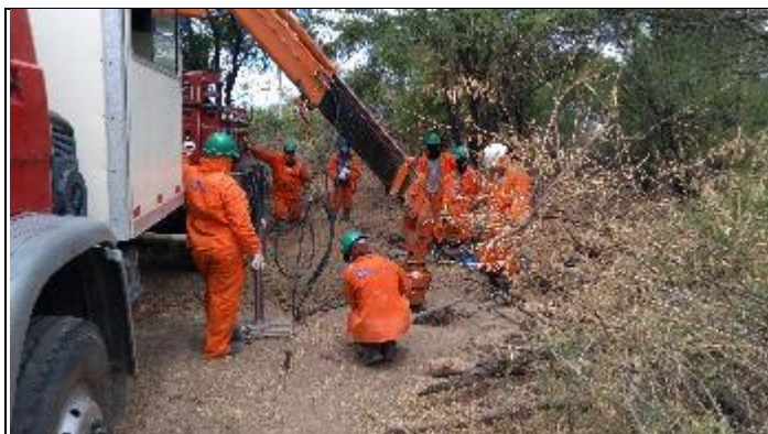
Figura 11. Abertura cava C com perfuratriz T 5/2
