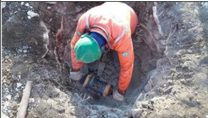
Figura 9. Reabertura cava "C" com martetele
