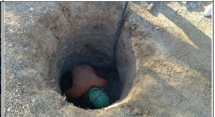
Figura 10. Continuação cava D com marteleto 16/1
