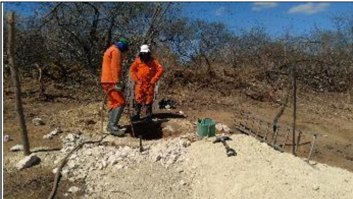
Figura 5. Reabertura cava B com martelete T 16/3
