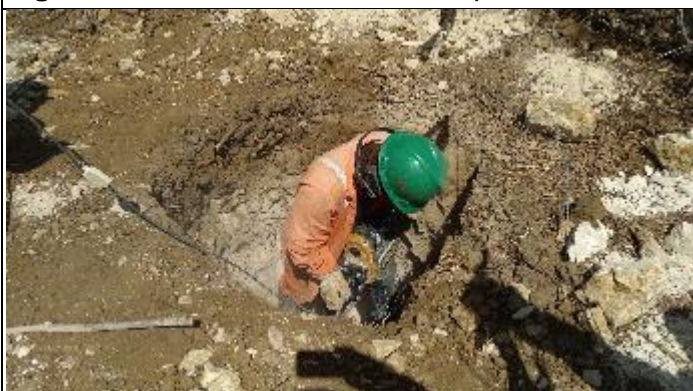
Figura 11. Reabertura cava D com martetele T 36/1
