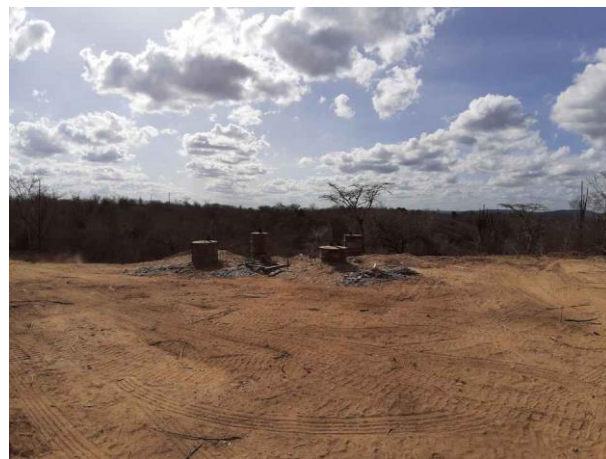
Figura 4. Torre 32/2, escavação com rompedor, rochas em baixa profundidade.
