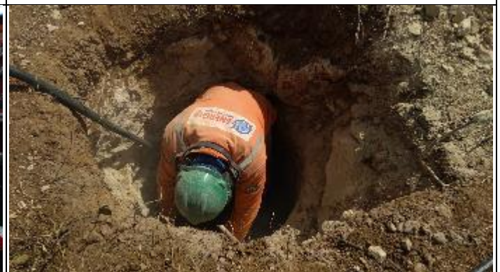
Figura 12. Finalização cava D com martetele T 17/1
