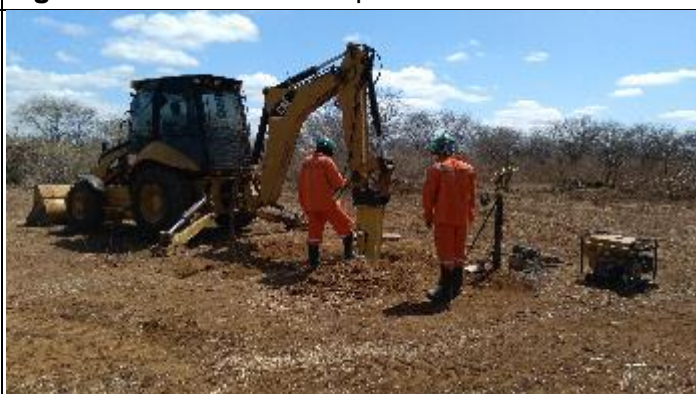
Figura 4. Abertura cava Central com picão T 37/1
