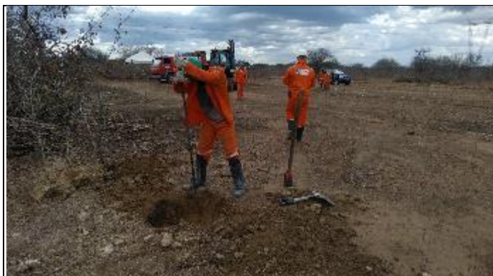
Figura 7. Abertura cava C com alavanca T 36/1
