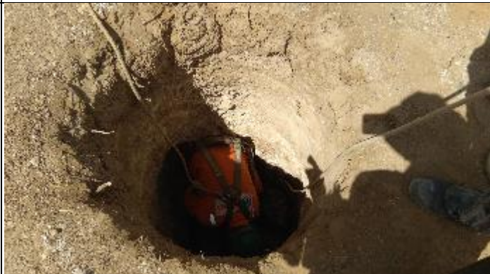
Figura 6. Abertura cava D com martetele T 15/2
