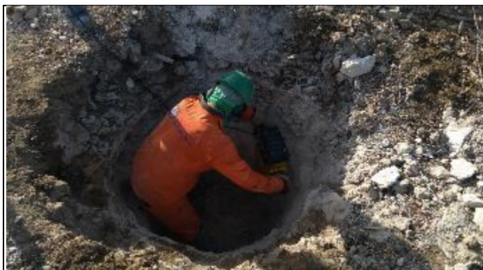
Figura 11. Reabertura cava B com martetele T 36/1
