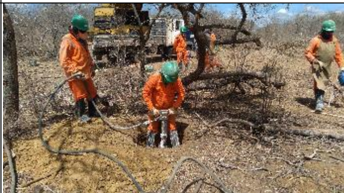
Figura 6. Abertura cava D com martetele T 16/1
