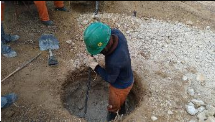
Figura 5. Abertura cava A com alavanca T 16/2
