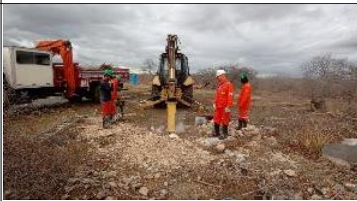
Figura 12. Reabertura cava Central T 37/2
