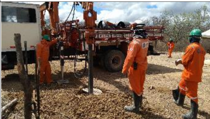
Figura 3. Abertura Cava B com perfuratriz 15/2
