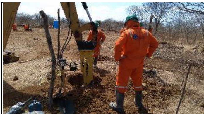
Figura 5. Reabertura cava A com picão T 37/1
