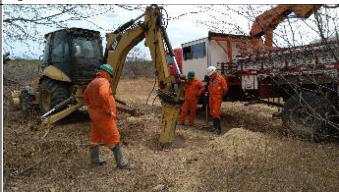
Figura 4. Abertura Cava A com picão T 17/1
