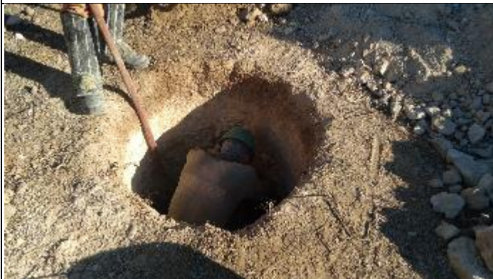
Figura 9. Continuação cava A com marteleto T 15/2
