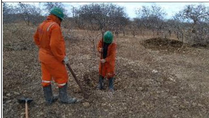
Figura 13. Abertura cava A com alavanca T 36/1
