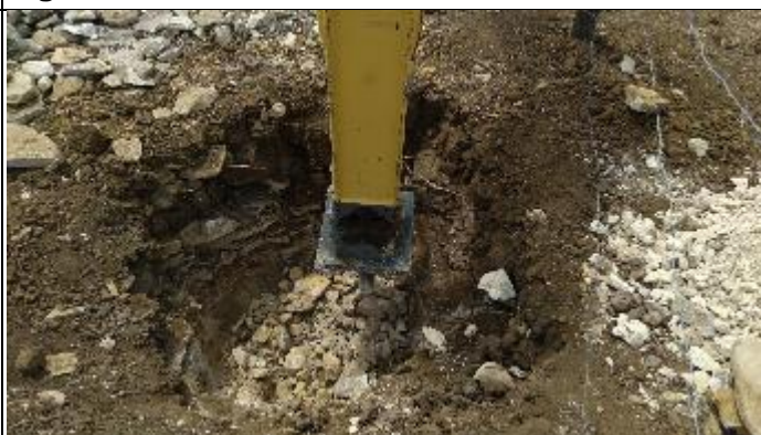
Figura 4. Reabertura cava "B" Torre 38/2
