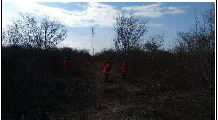
Figura 12. Supressão entre as Torres 69/1 e 68/2
