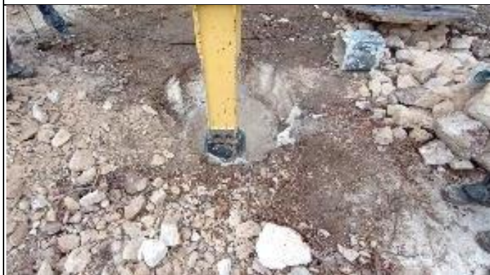
Figura 11. Reabertura cava A com Picão T 37/2
