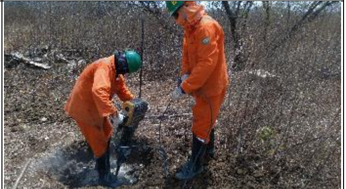
Figura 6. Abertura cava D com martetele T 34/2
