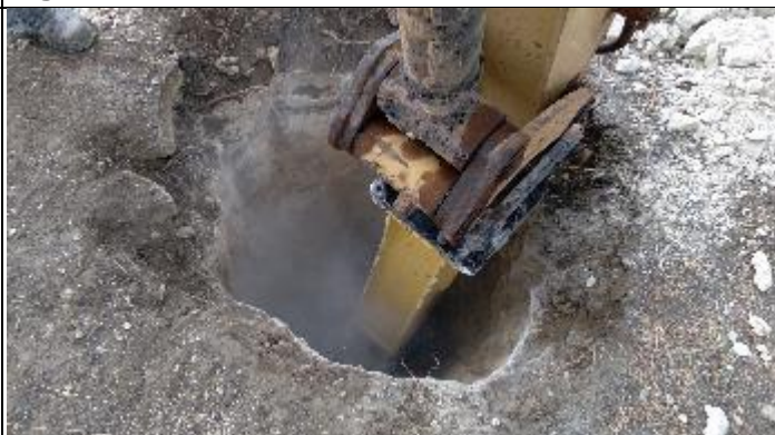
Figura 10. Reabertura cava B com Picão T 37/2
