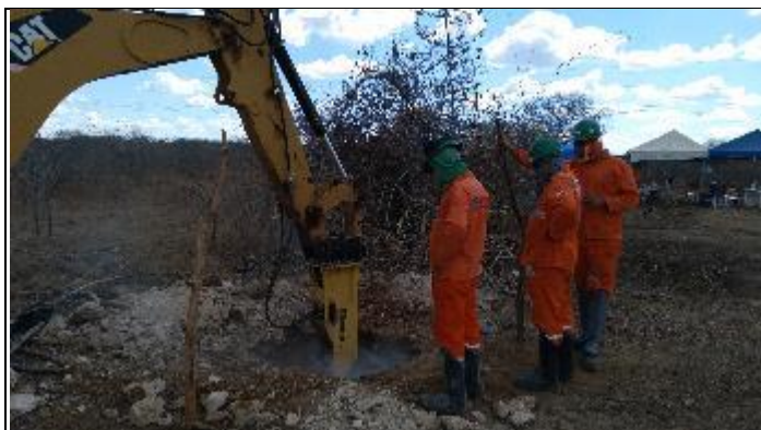
Figura 13. Reabertura cava C com picão T 36/1
