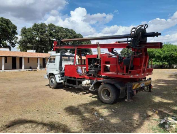
Figura 1. Perfuratriz parada no canteiro.
