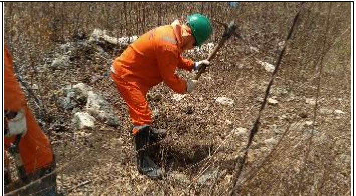
Figura 4. Abertura Cava C com Chibanca T 34/2
