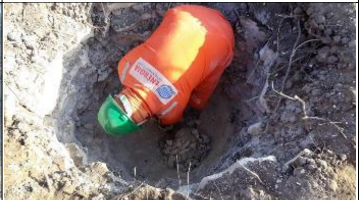
Figura 10. Retirada de material com pá cava "D"
