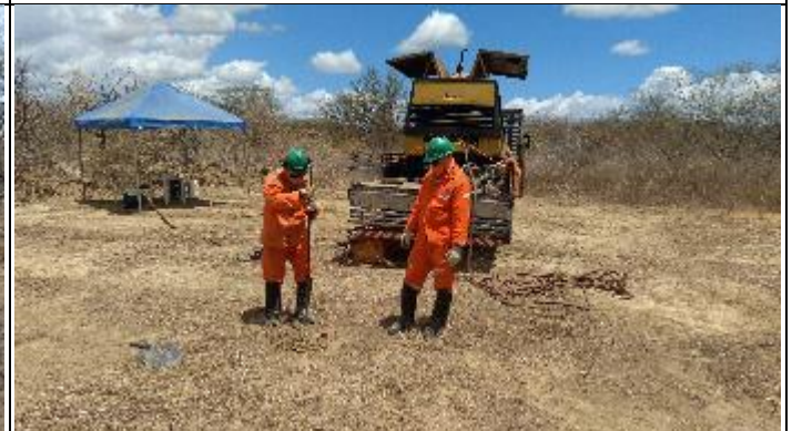
Figura 8. Abertura cava D com alavanca T 16/3
