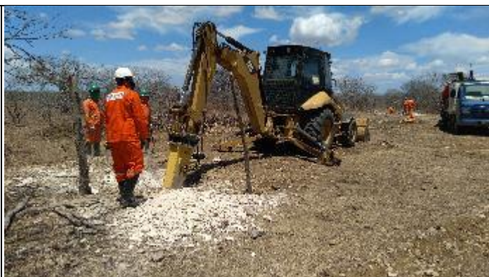
Figura 14. Reabertura cava A com Picão T 36/1
