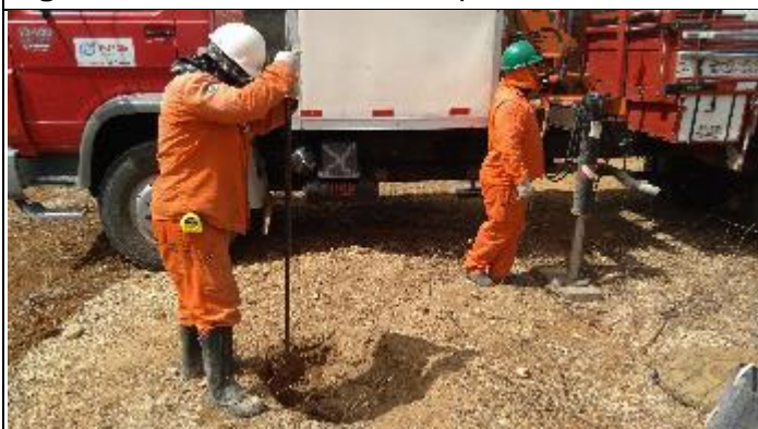
Figura 3. Abertura Cava D com alavanca T 16/4
