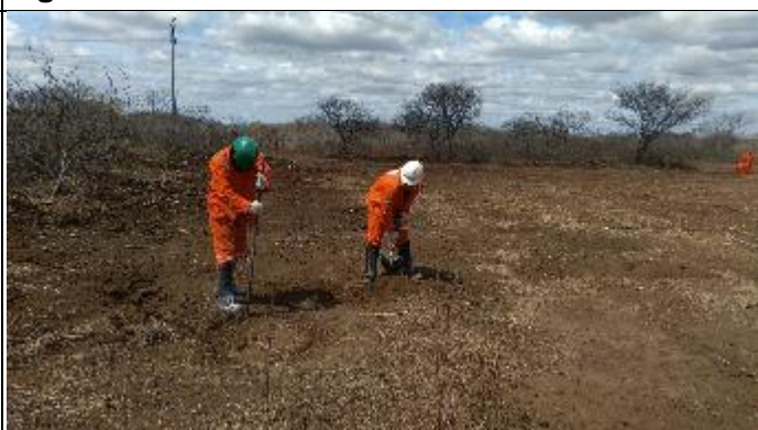
Figura 4. Abertura cava C com alavanca T 37/1
