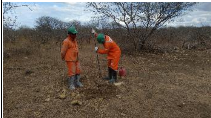
Figura 11. Abertura cava B com Alavanca T 36/1
