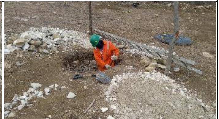
Figura 8. Abertura cava Central com alavanca
