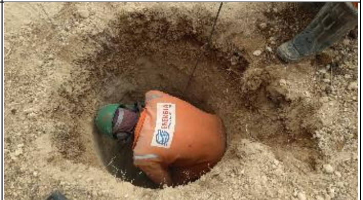
Figura 8. Abertura cava B com martetele T 16/4
