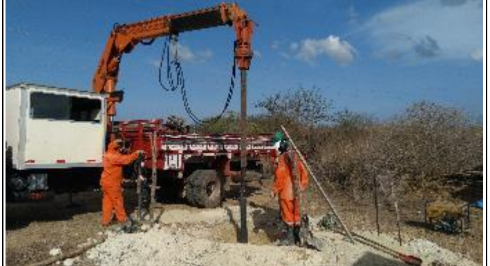
Figura 8. Reabertura cava D com perfuratriz T 16/2
