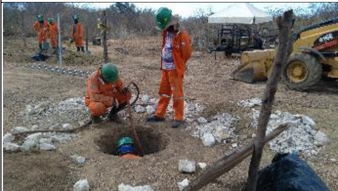
Figura 9. Continuação cava D com martelete T 16/3
