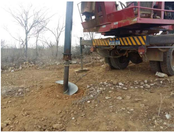
Figura 5. Torre 107/1, cava A.
