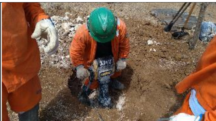
Figura 6. Reabertura cava A com martetele T 37/1
