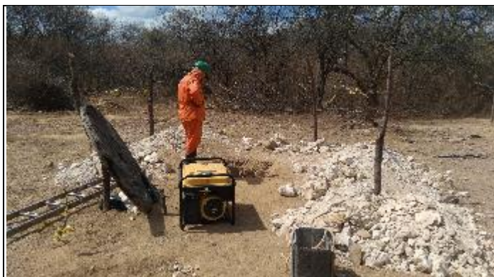
Figura 7. Início cava D 2,60m com martetele T 15/2
