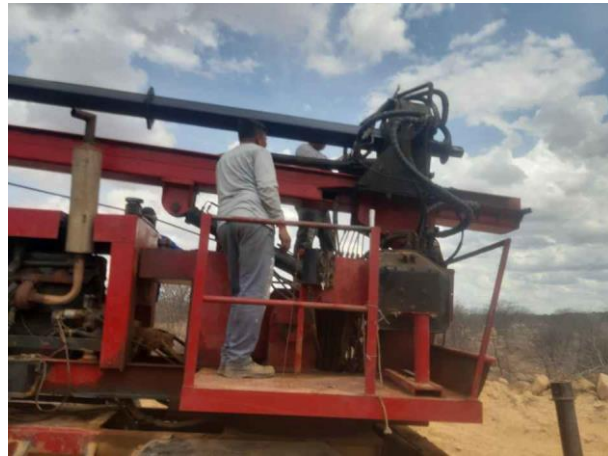
Figura 2. Torre 94/1, perfuratriz quebrada.
