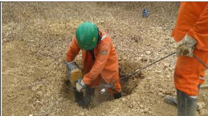
Figura 2. Abertura cava C com martetele T 33/1
