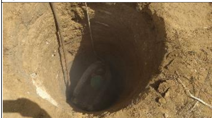
Figura 3. Reabertura Cava C com martelete 1/2
