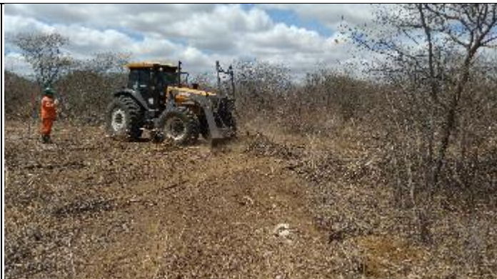
Figura 2. Supressão na praça da Torre 16/1
