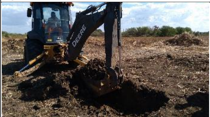
Figura 9. Abertura cava C com retroscavadeira T 16/3
