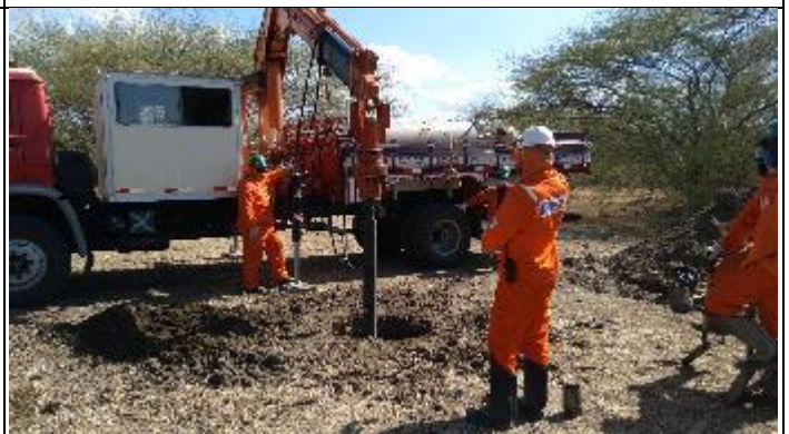
Figura 10. Abertura cava D com perfuratriz T 6/1
