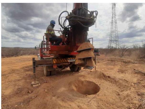
Figura 3. Torre 94/2, cava D.
