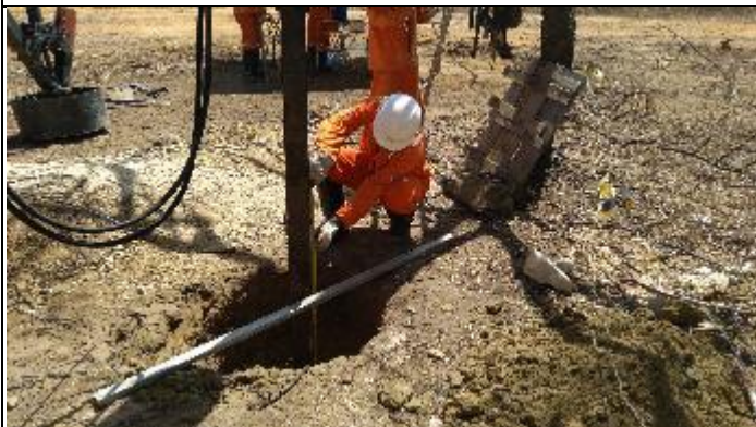
Figura 1. Finalizando cava A com perfuratriz T 16/3
