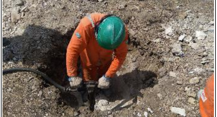
Figura 8. Reabertura cava B com Rompedor T 36/1
