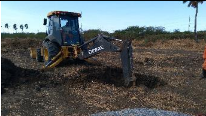
Figura 9. Abertura cava A com retro escadeira T 4/1
