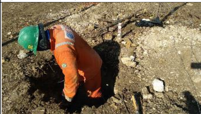
Figura 12. Reabertura cava Central T 36/1
