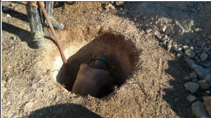
Figura 9. Continuação cava A com martetele T 15/2
