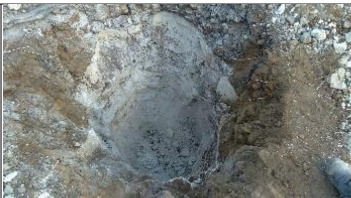
Figura 10. Finalização cava "C" T 37/1
