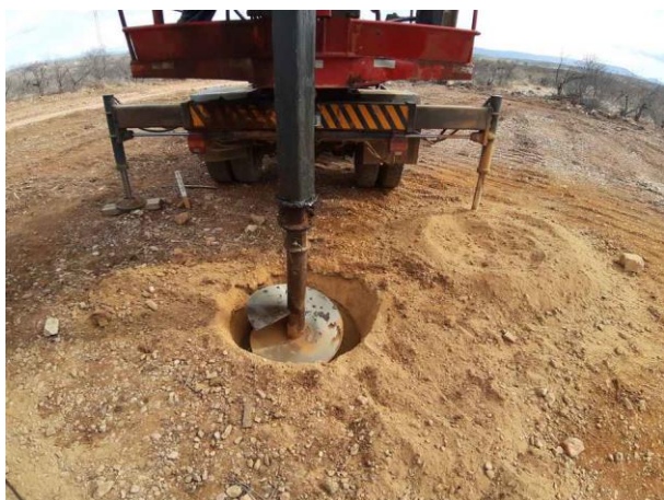
Figura 3. Torre 95/2, cava Central.
