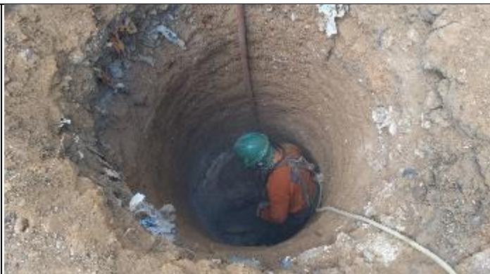
Figura 2. Reabertura cava B com martelete T 1/2
