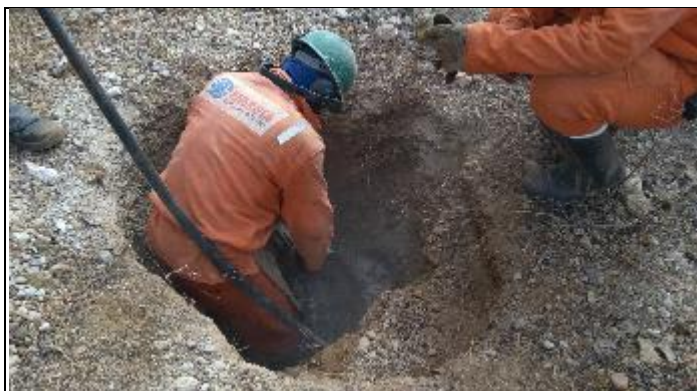
Figura 13. Finalização cava B c/ Rompedor T 17/1
