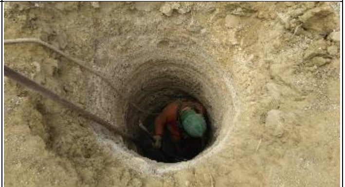
Figura 10. Finalização cava B com alavanca.
