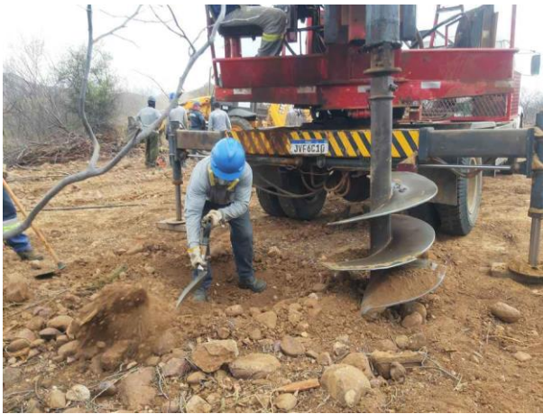
Figura 1. Escavação com perfuratriz da torre 71/1, cava A
