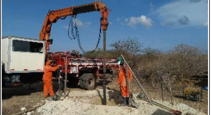
Figura 8. Reabertura cava D com perfuratriz T 16/2
