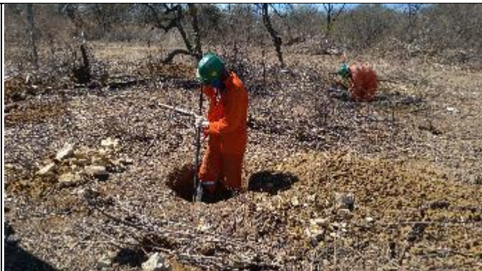
Figura 2. Abertura cava B com alavanca T 16/1
