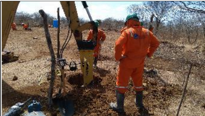
Figura 5. Reabertura cava A com picão T 37/1
