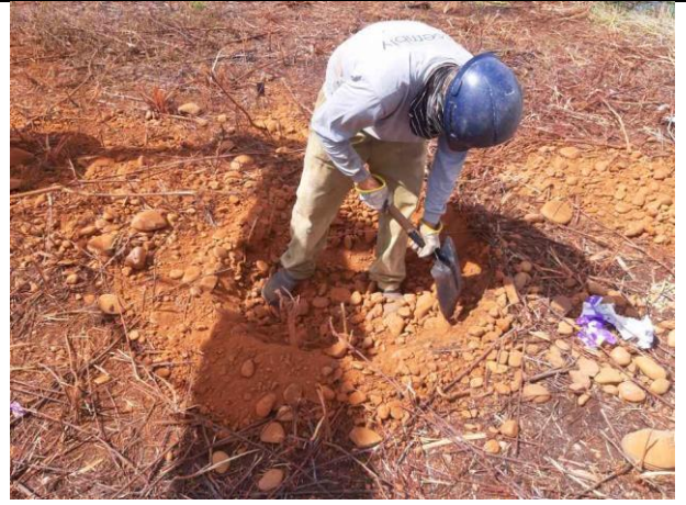
Figura 6. Torre 133/1, cava C
