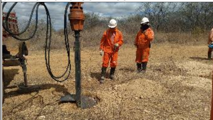
Figura 1. Abertura cava A com perfuratriz T 16/4
