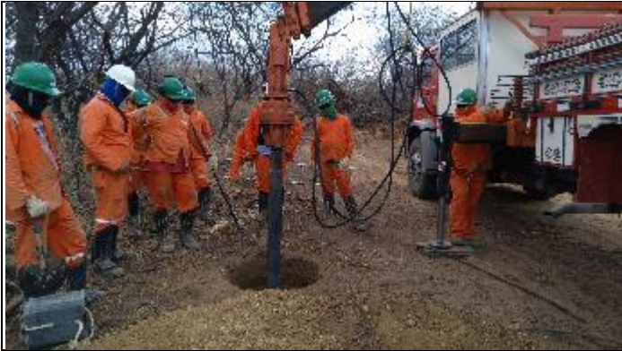
Figura 9. Abertura cava A com perfuratriz T 16/3
