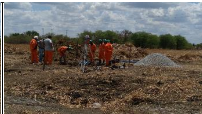
Figura 2. Escavação parada T 4/1
