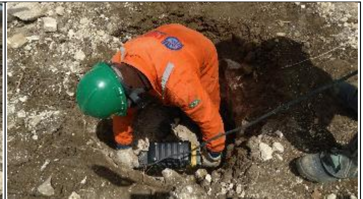
Figura 6. Abertura cava A com martetele rompedor
