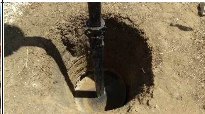
Figura 8. Finalização cava D com perfuratriz T 16/3
