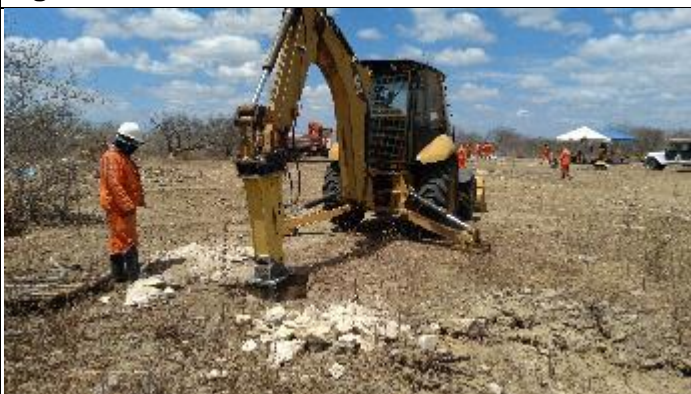
Figura 3. Abertura cava C com picão T 37/2
