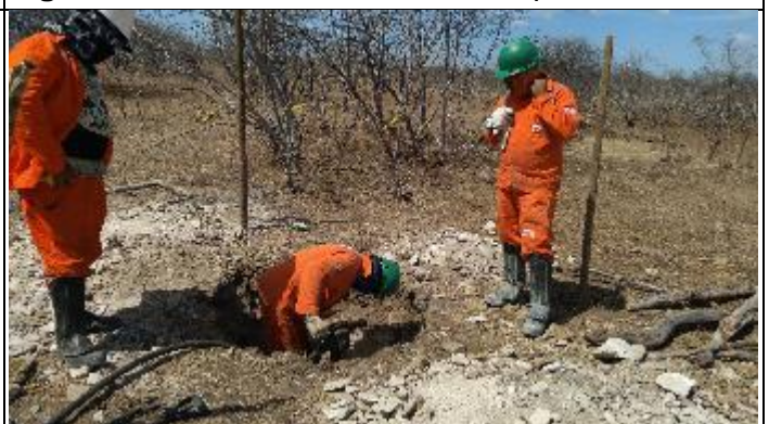
Figura 12. Reabertura cava B com rompedor T 36/1
