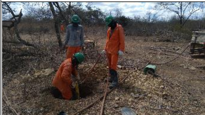
Figura 5. Abertura cava A com martetele T 16/1
