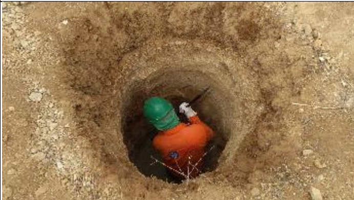
Figura 5. Reabertura cava D com alavanca T 16/4
