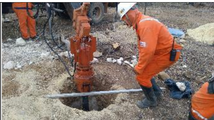
Figura 10. Finalização cava D com perfuratriz T 16/1
