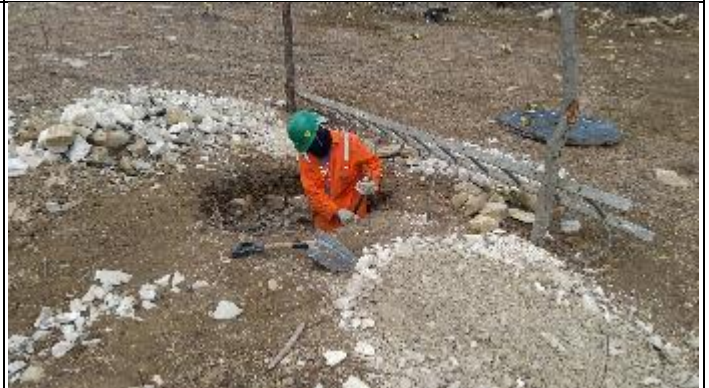
Figura 8. Abertura cava Central com alavanca
