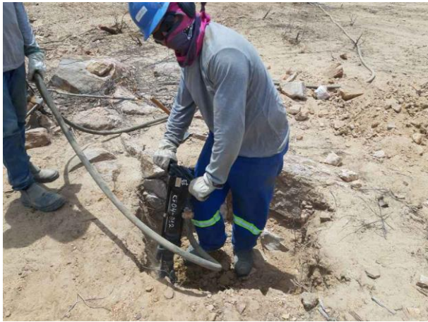
Figura 3. Torre 94/1, cava A.
