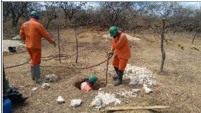
Figura 9. Continuação cava D com martetele T 16/3
