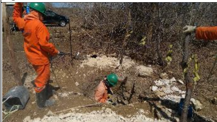
Figura 3. Reabertura Cava D com martetele T 36/1
