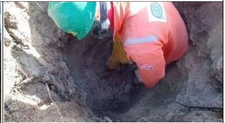
Figura 2. Reabertura cava D com martetele T 38/1
