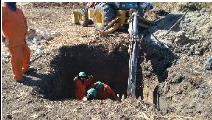
Figura 8. Escavação final Cava "B" T 4/1
