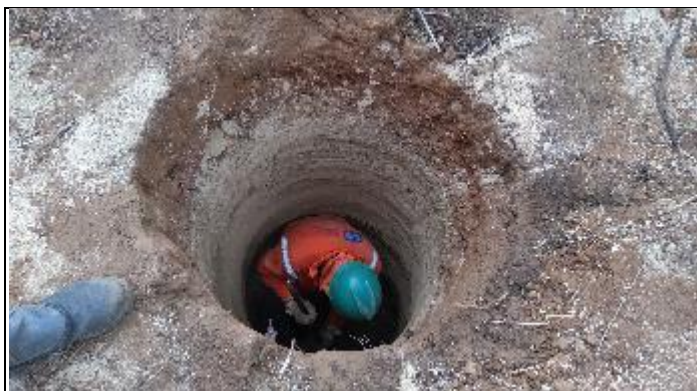
Figura 7. Continuação cava B com alavanca T 16/3
