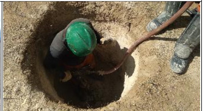
Figura 2. Abertura cava A com martetele T 15/2
