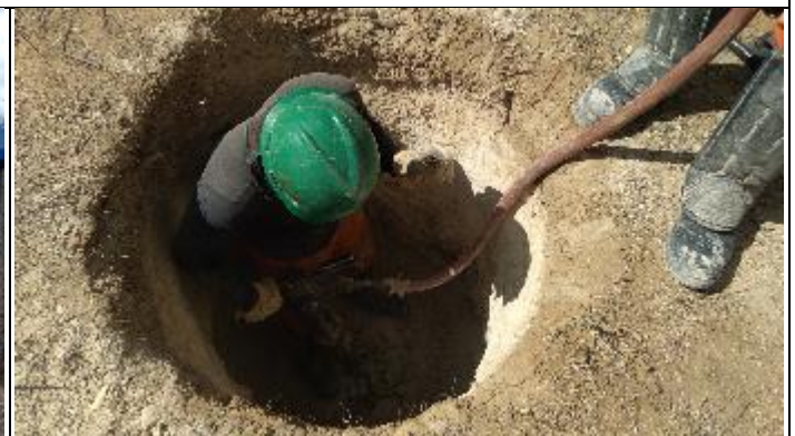
Figura 2. Abertura cava A com marteleto T 15/2
