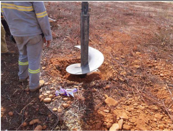
Figura 5. Torre 133/1, cava D.
