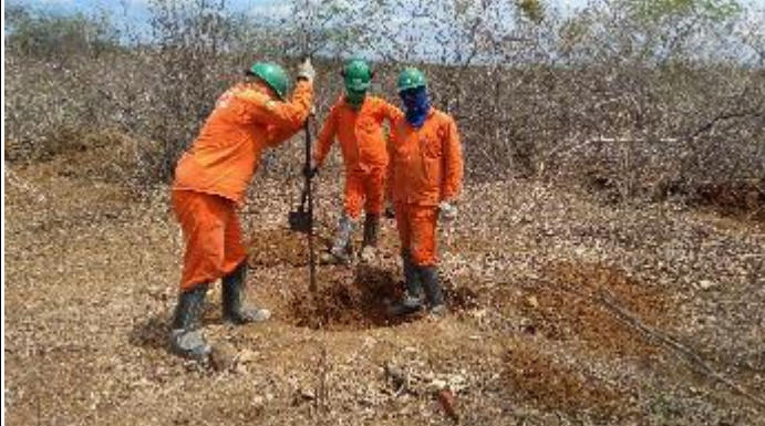
Figura 7. Abertura cava C com alavanca T 17/1
