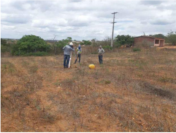
Figura 1. Demarcação das cavas para escavação da torre 22/2.
