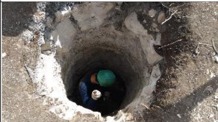
Figura 8. Finalização cava C com alavanca T 54/4
