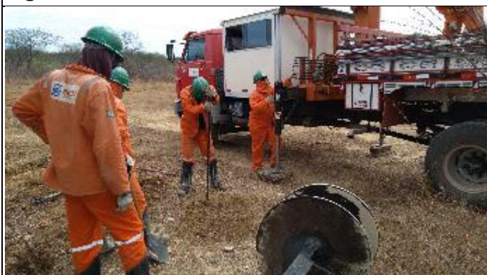
Figura 3. Abertura Cava A com alavanca T 17/1
