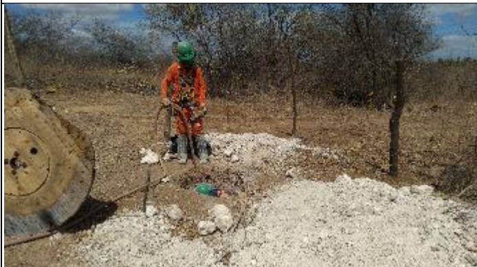
Figura 1. Reabertura cava B com martetele T 15/2
