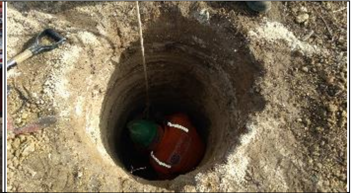
Figura 10. Abertura cava A com martelete T 16/3
