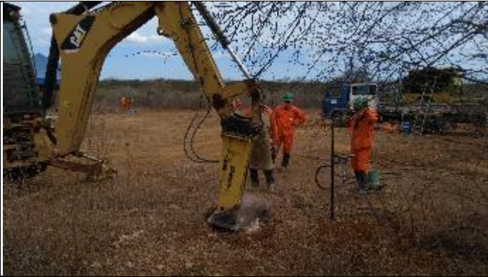
Figura 5. Abertura cava D com picão T 17/1
