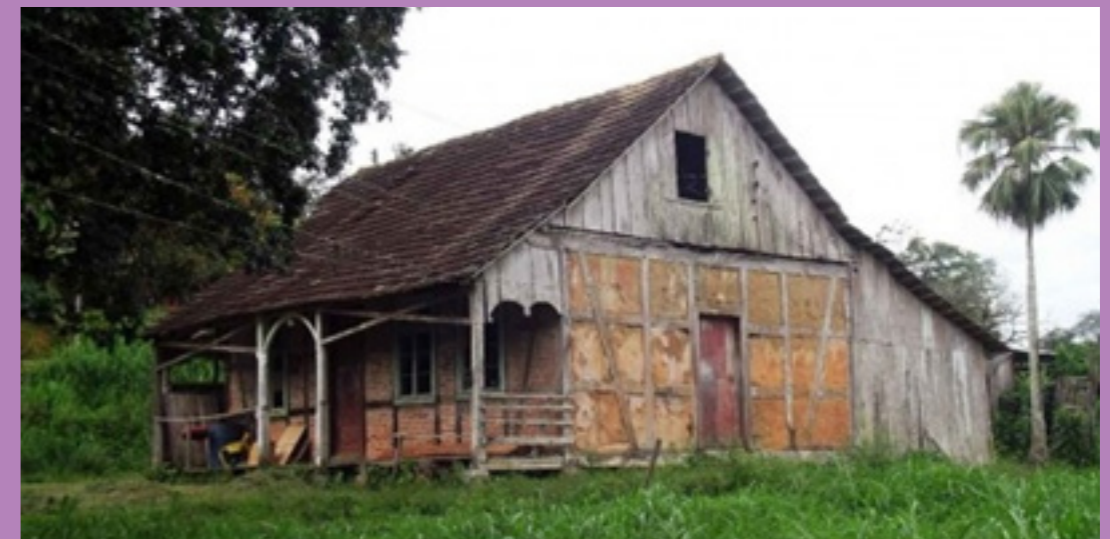
Casa enxaimel, SC, Brasil. Fonte: Wittmann, Angelina. Fachwerk, a técnica construtiva enxaimel, Revista Vitruvius, jul 2016.
